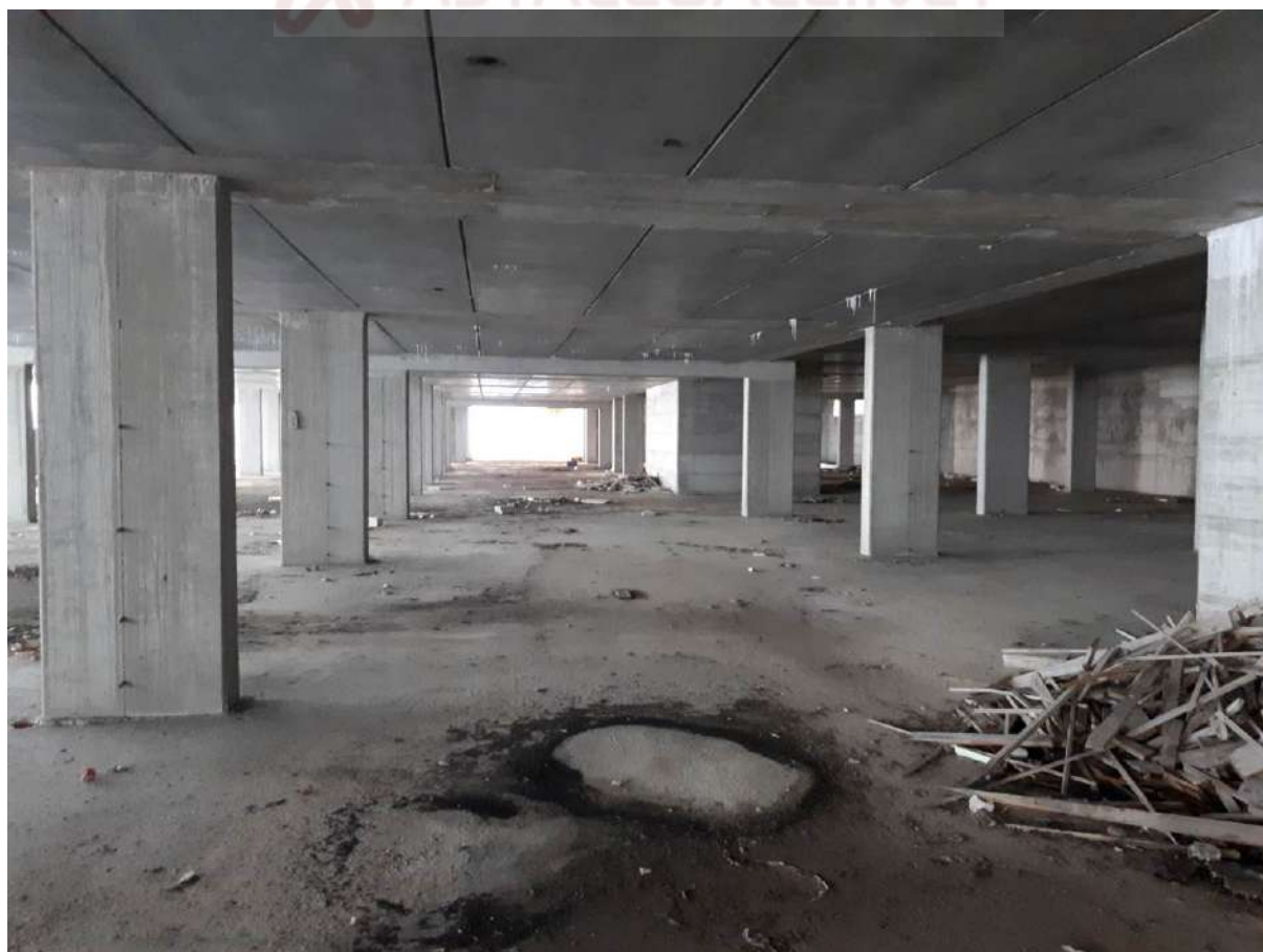
Foto 31 piano primo interrato
