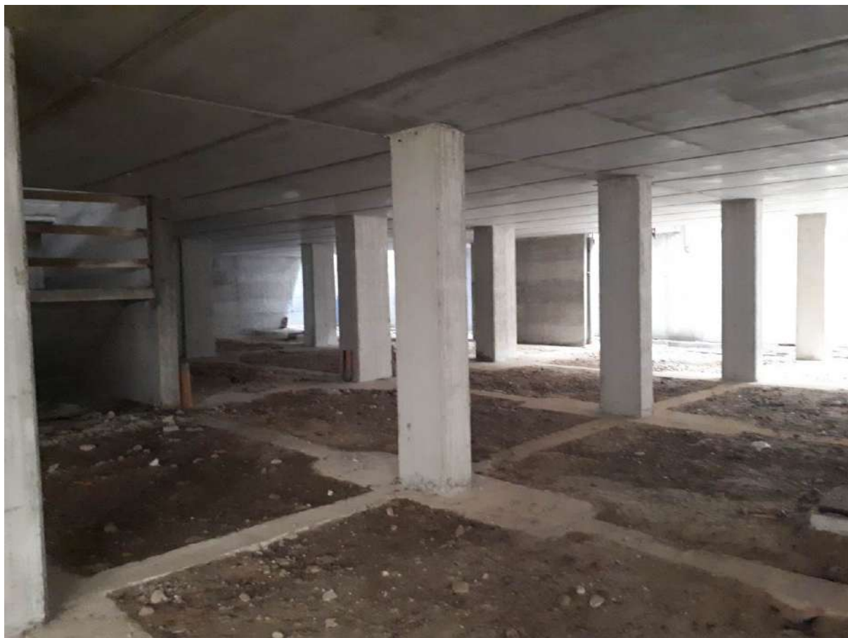
Foto 31 piano interrato S2 allo stato grezzo
