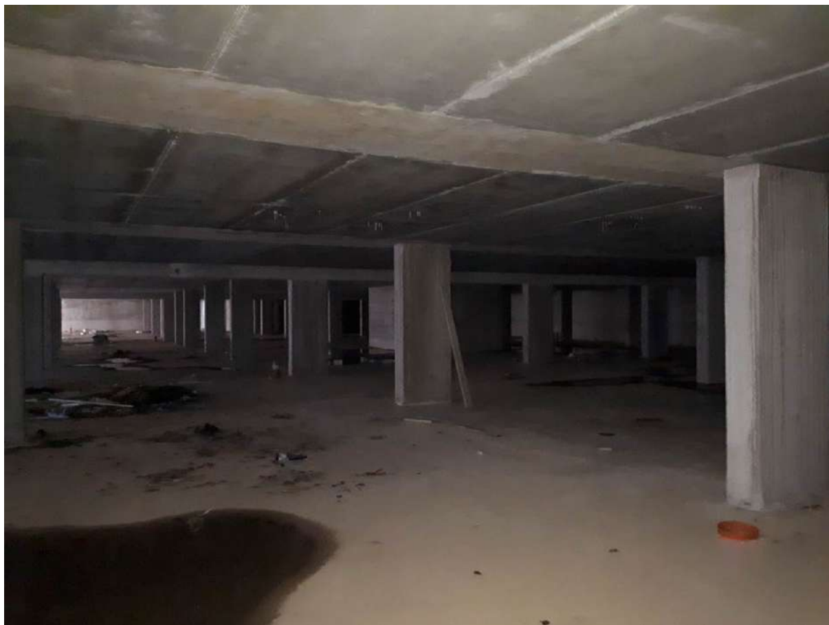
Foto 34 piano secondo interrato
