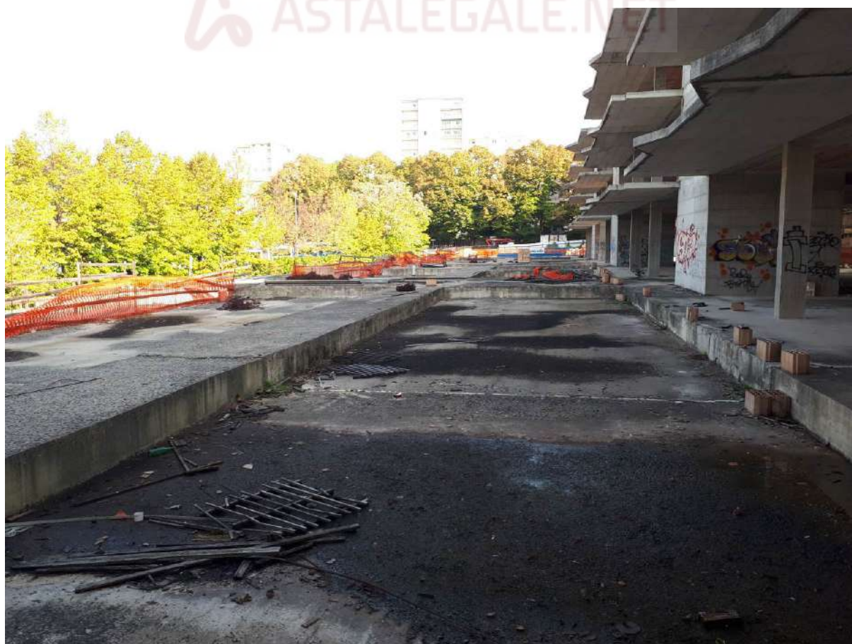
Foto 21 spazi esterni lungo il prospetto ovest
