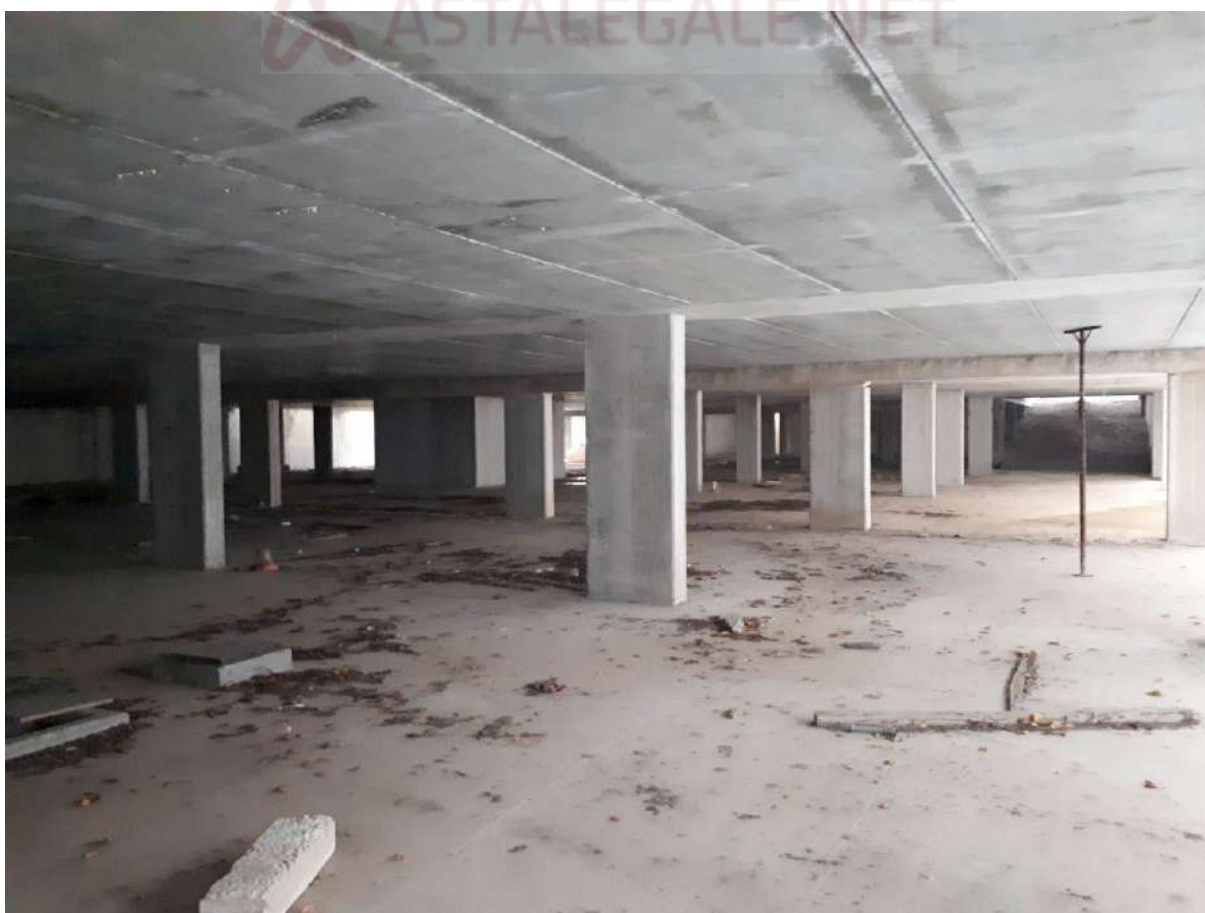
Foto 33 piano secondo interrato
