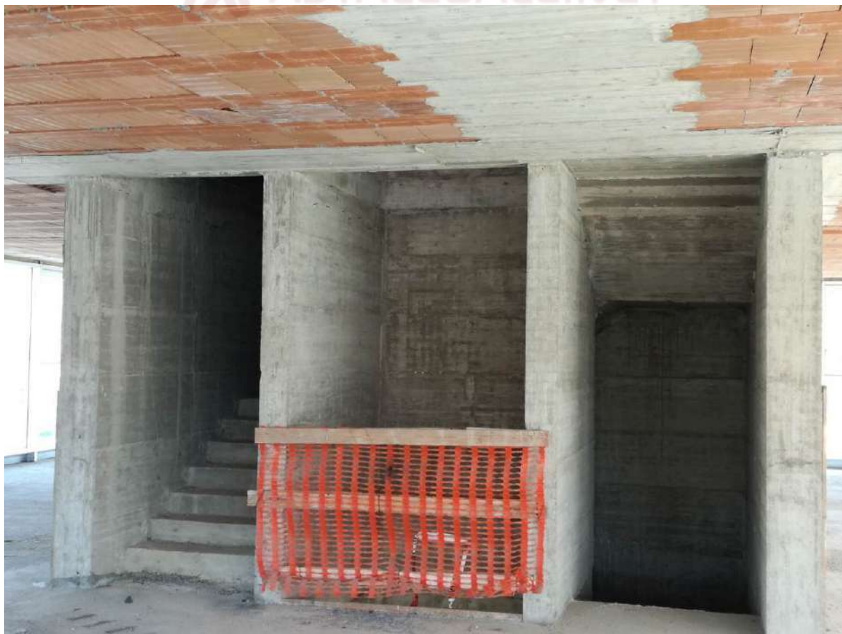
Foto 7 foto interni: blocco scale ed ascensore
