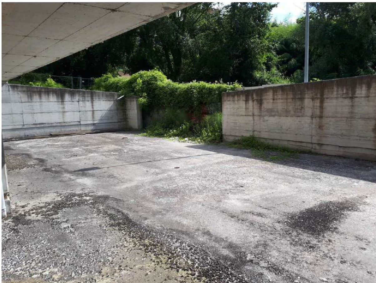
Foto 37 piano interrato S1 accesso alla strada pubblica
