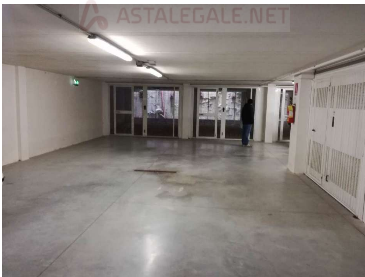
Foto 47 SPAZI DI MANOVRA P.1° INTERRATO
