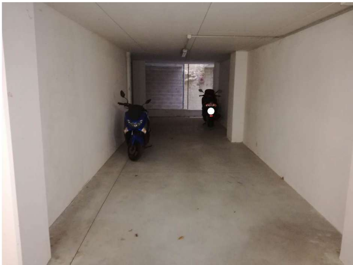
Foto 54 GARAGE n.14 P.1° INTERRATO – SUB57 (senza serranda)
