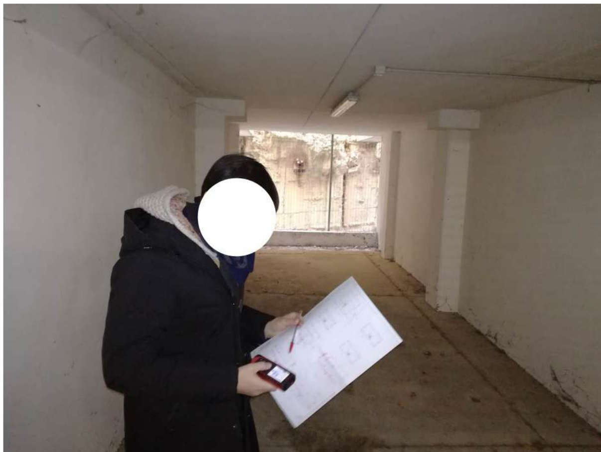
Foto 52 GARAGE n.12 P.1° INTERRATO – SUB59
