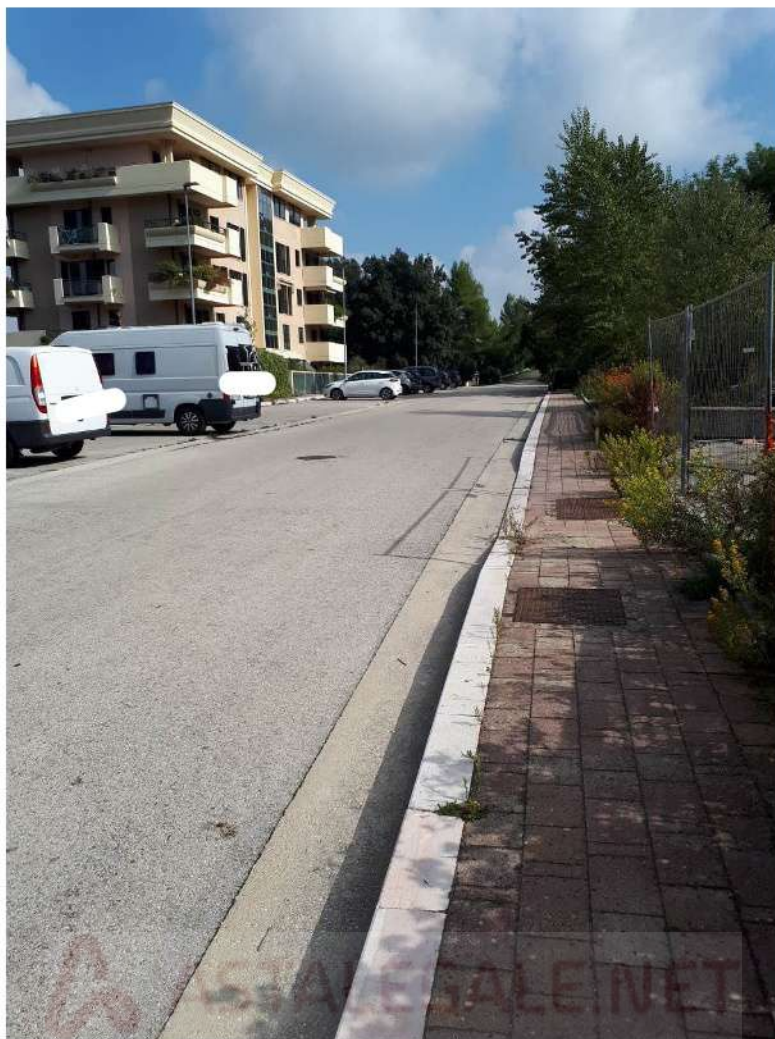
Foto 14 vista delle opere di urbanizzazione
