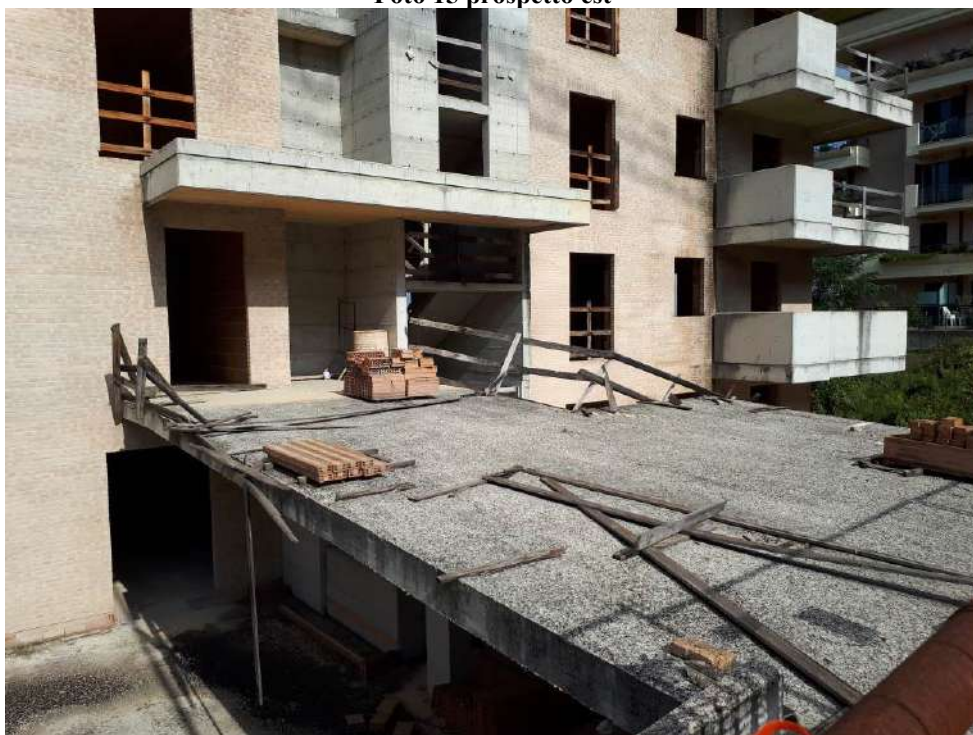
Foto 16 ingresso su prospetto sud
