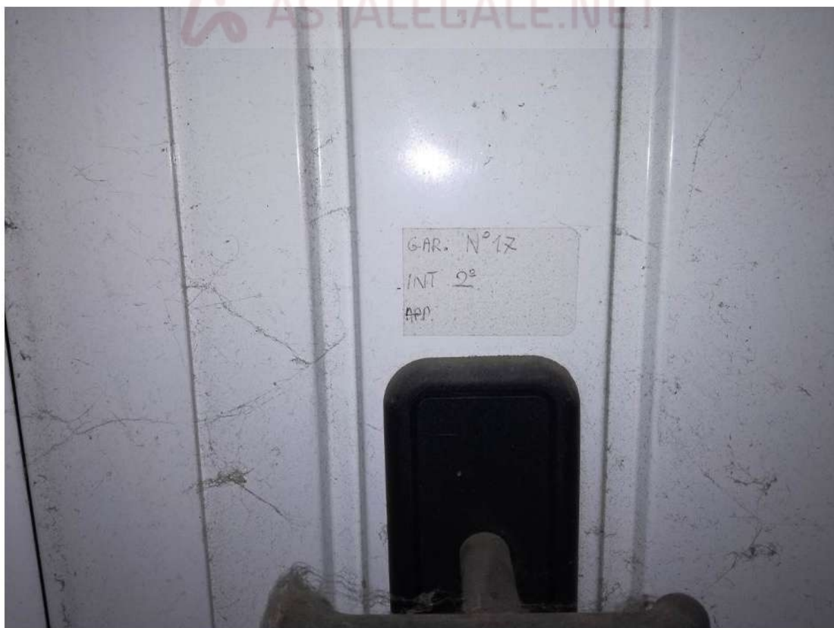
Foto 64 GARAGE n.17 P.2° INTERRATO – SUB65
