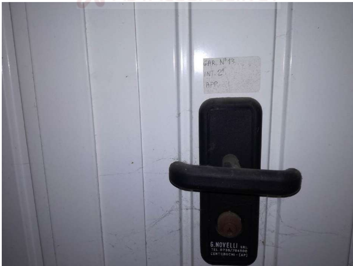
Foto 57 GARAGE n.13 P.2° INTERRATO – SUB69
