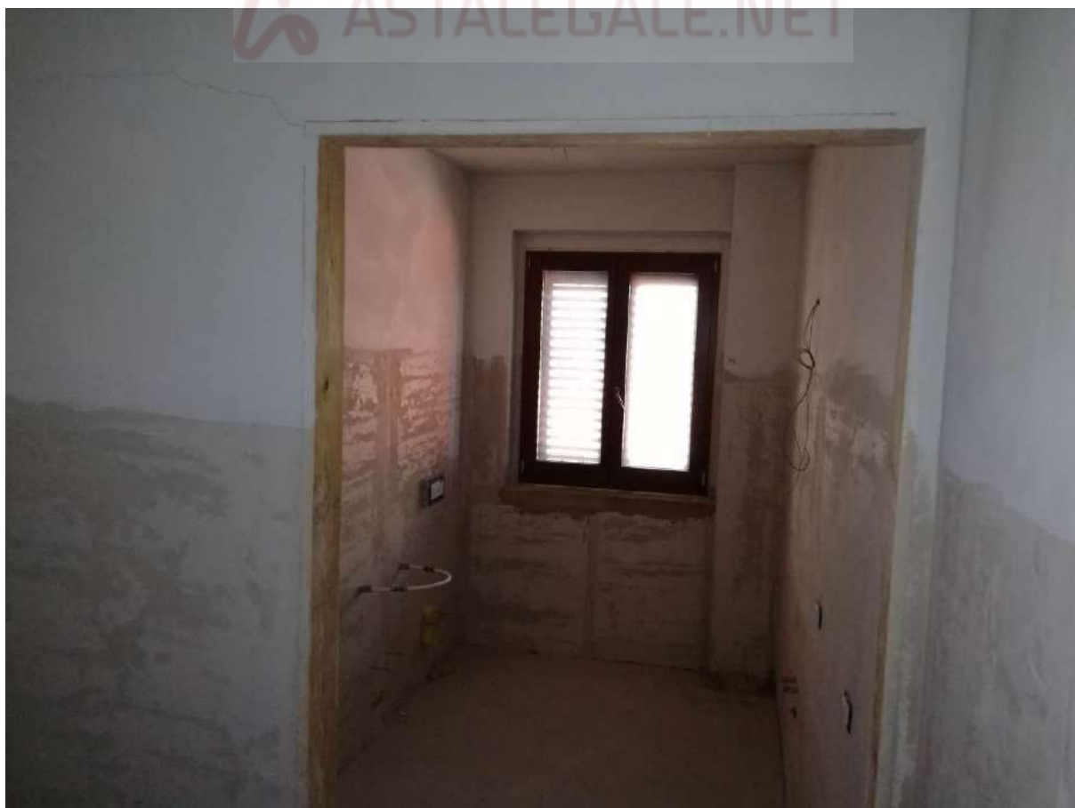
Foto 10 APPARTAMENTO n.2 P.2° SEMININTERRATO – SUB31 - BAGNO
