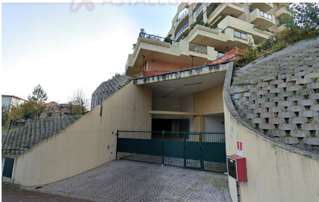
Foto 3 ingresso ai garage su prospetto nord
