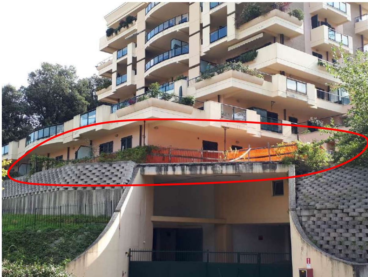
Foto 4 appartamenti al piano 2° seminterrato
