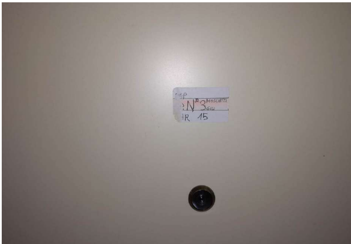
Foto 15 APPARTAMENTO n.3 P.2° SEMININTERRATO – SUB32 – INGRESSO
