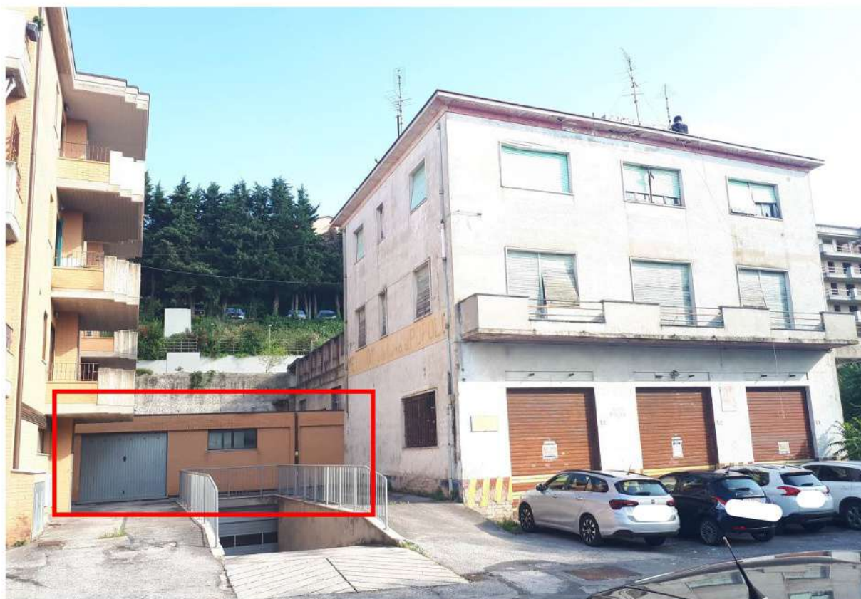
Foto 13 magazzino fg.65 part.100 sub 47
