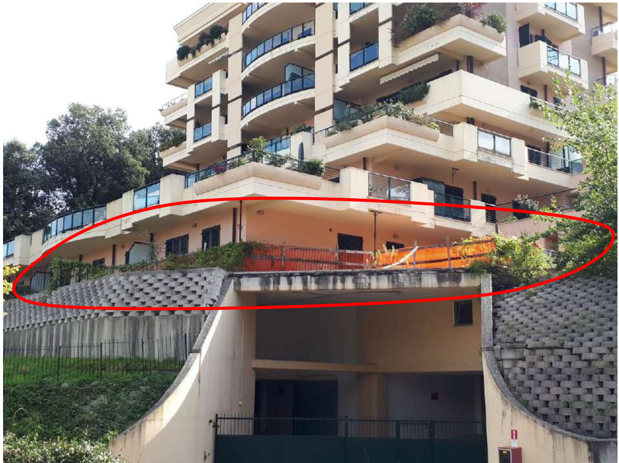
Foto 4 appartamenti al piano 2° seminterrato
