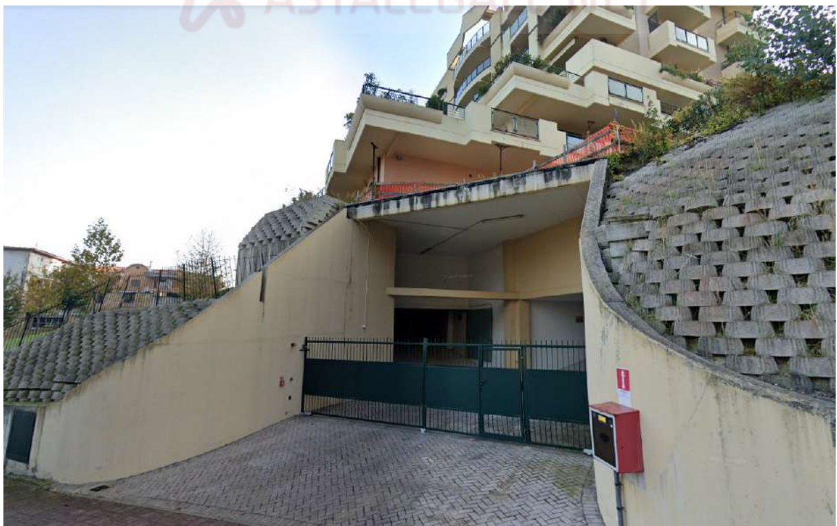
Foto 3 ingresso ai garage su prospetto nord
