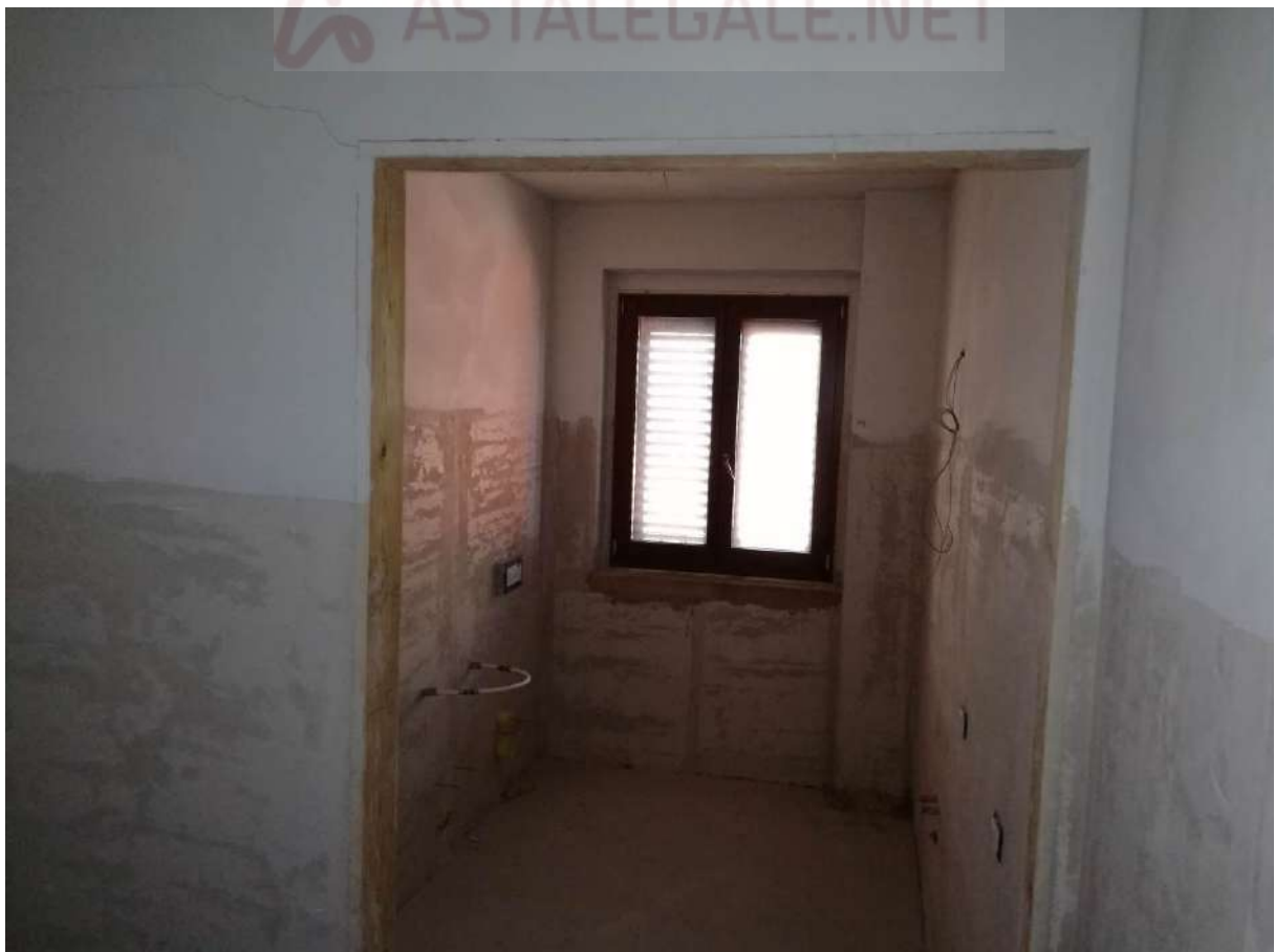
Foto 10 APPARTAMENTO n.2 P.2° SEMININTERRATO – SUB31 - BAGNO
