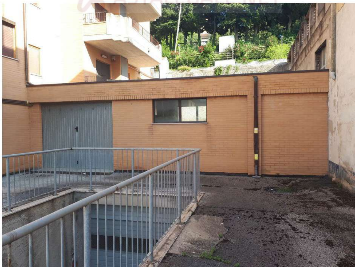
Foto 14 magazzino fg.65 part.100 sub 47
