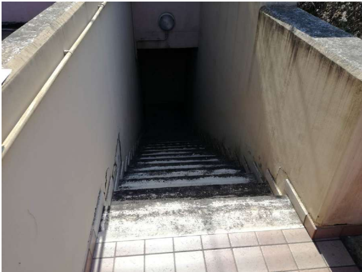
Foto 14 SCALE CONDOMINIALI ACCESSO AI GRAGE (SUB1) SU CORTE SUB31
