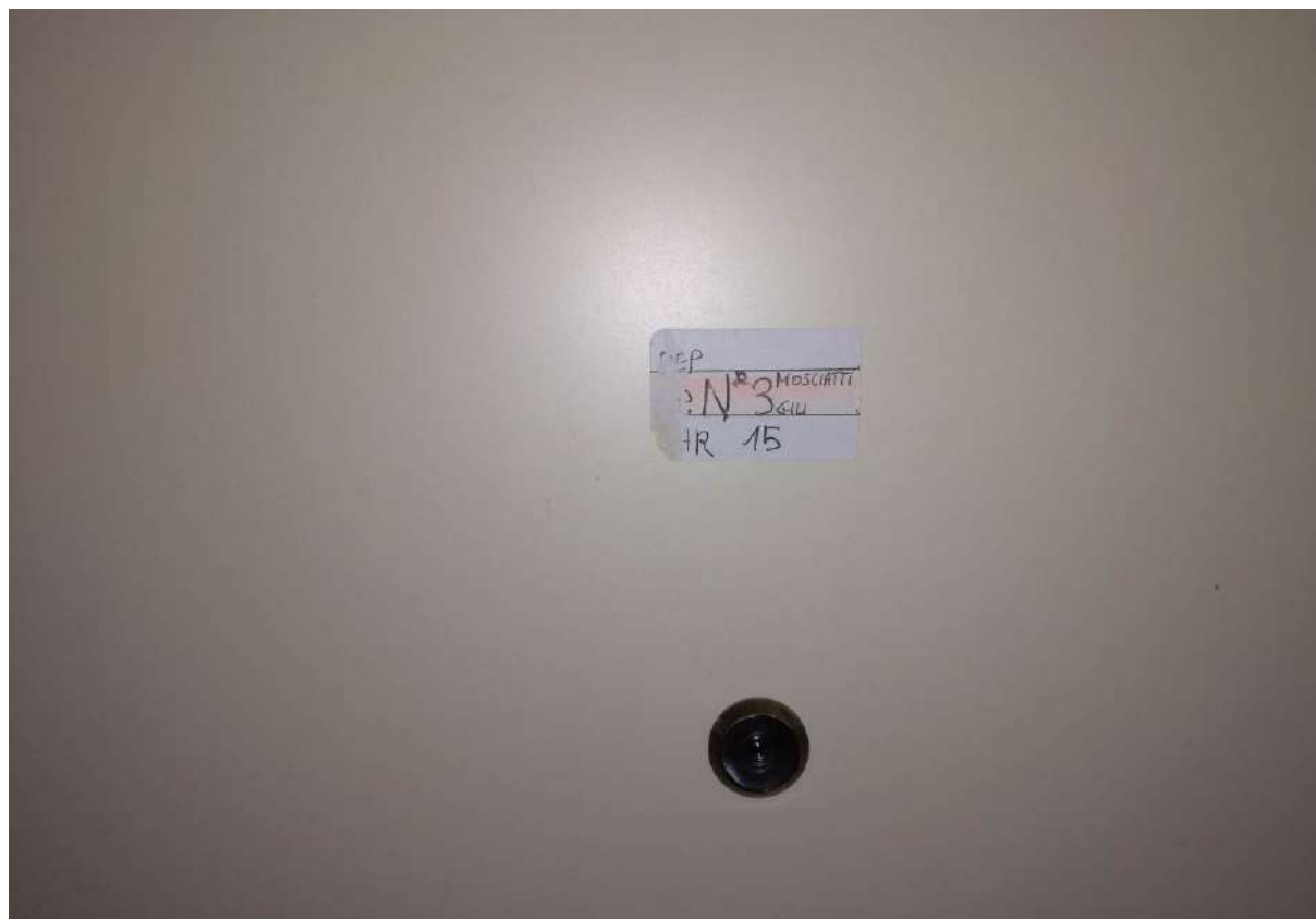
Foto 15 APPARTAMENTO n.3 P.2° SEMININTERRATO – SUB32 – INGRESSO
