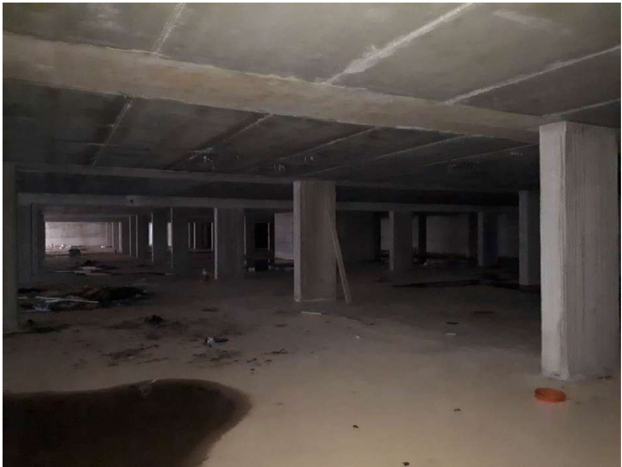
Foto 34 piano secondo interrato
