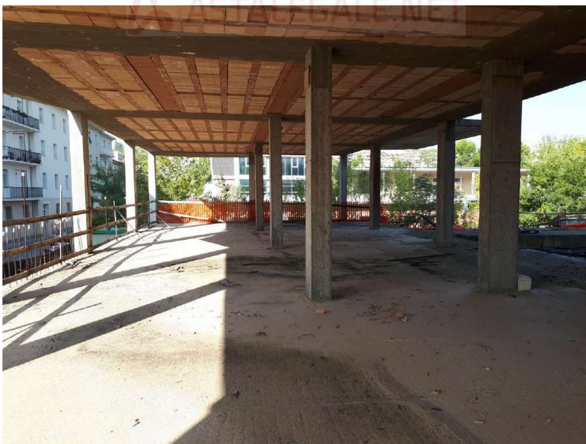
Foto 29 piano terra porzione di edificio su via Emanuele Filiberto
