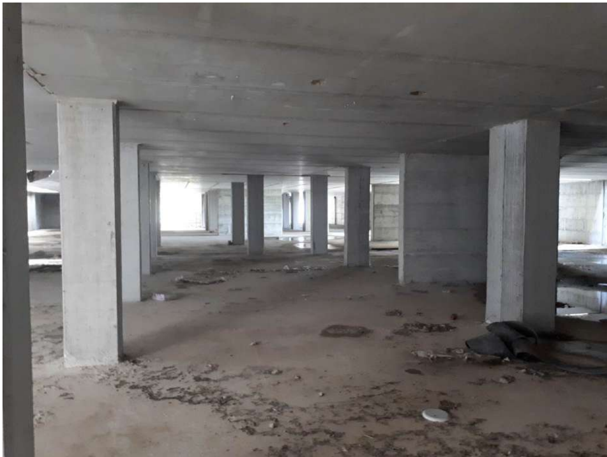
Foto 33 piano interrato S1 allo stato grezzo
