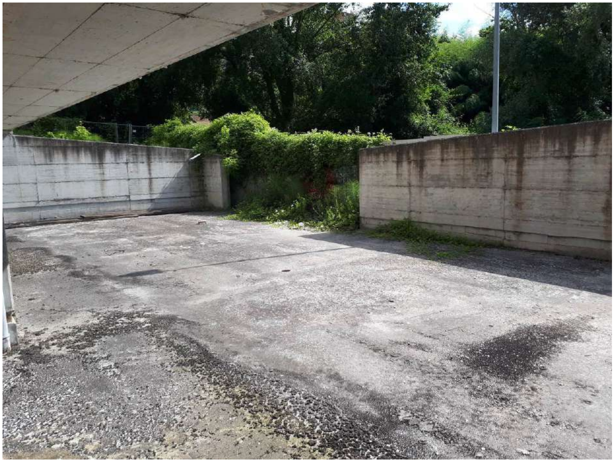
Foto 37 piano interrato S1 accesso alla strada pubblica
