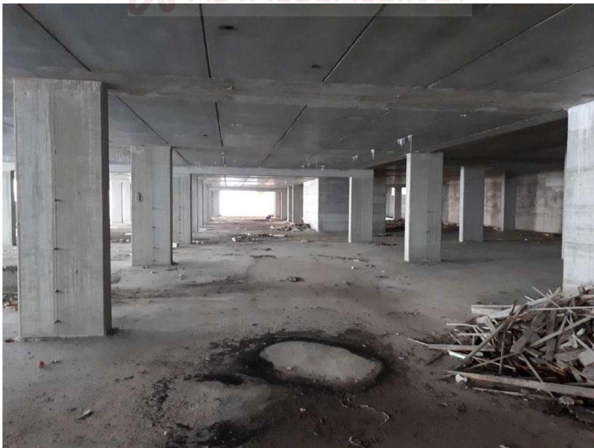
Foto 31 piano primo interrato
