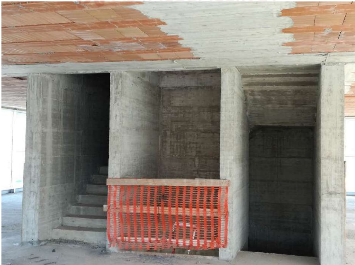
Foto 7 foto interni: blocco scale ed ascensore
