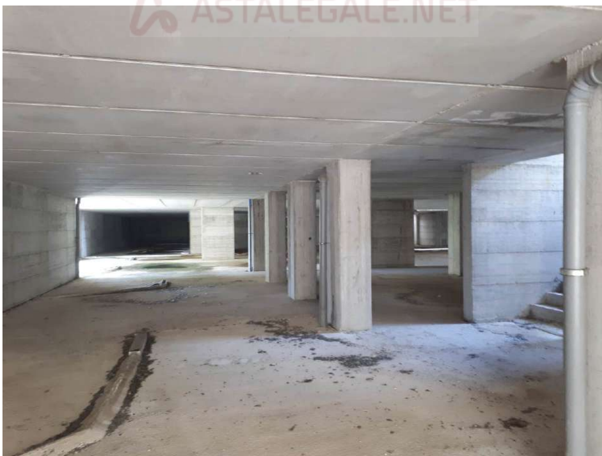
Foto 34 piano interrato S1 allo stato grezzo
