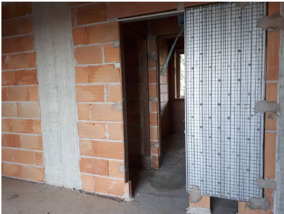
Foto 27 interno allo stato grezzo nei due edifici, porzioni con tamponature e divisori interni realizzati
