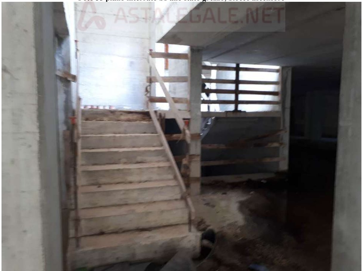
Foto 36 piano interrato S1 allo stato grezzo, blocco scala
