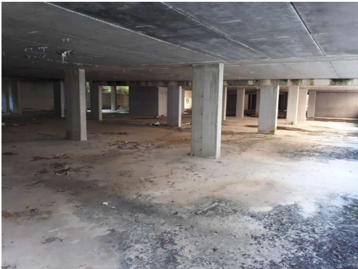
Foto 30 piano primo interrato
