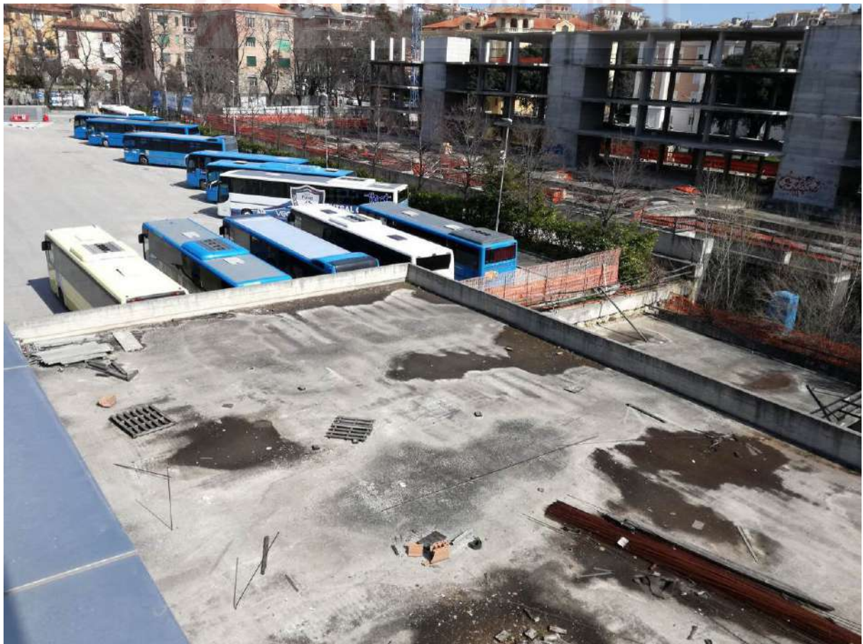
Foto 15 lastrico solare (sub3)
