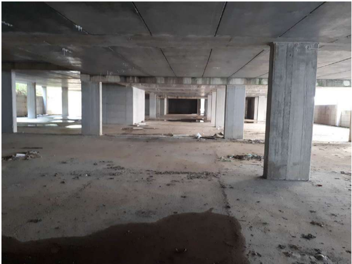
Foto 32 piano primo interrato
