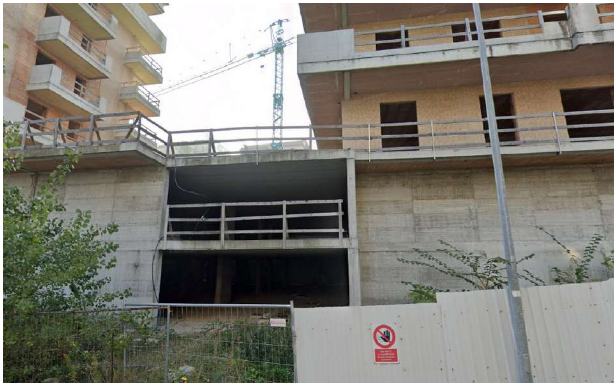
Foto 7 prospetto nord, ingresso garage piano interrato 2 comune ai due edifici
