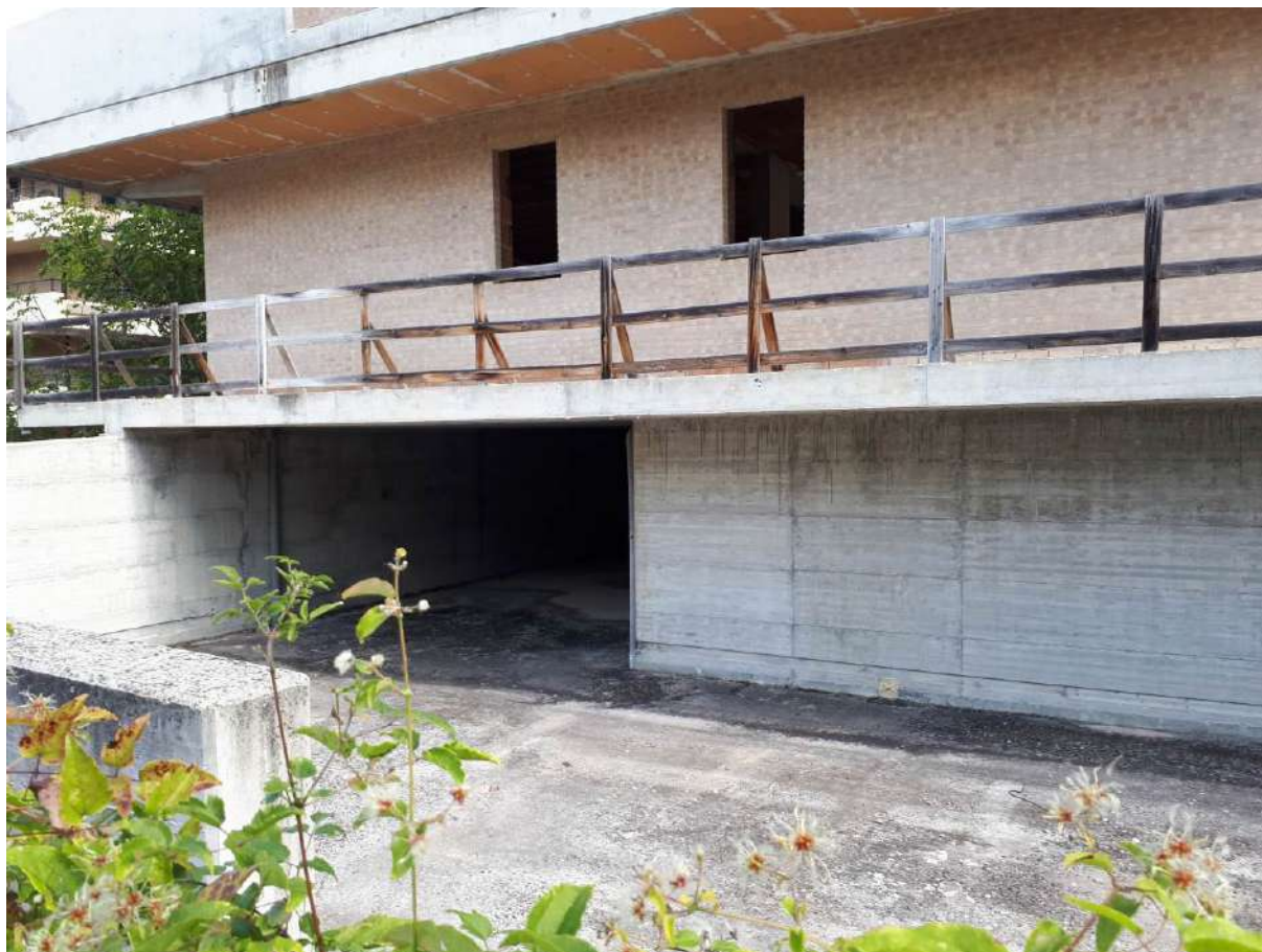
Foto 5 prospetto ovest, ingresso garage piano interrato 1 comune ai due edifici
