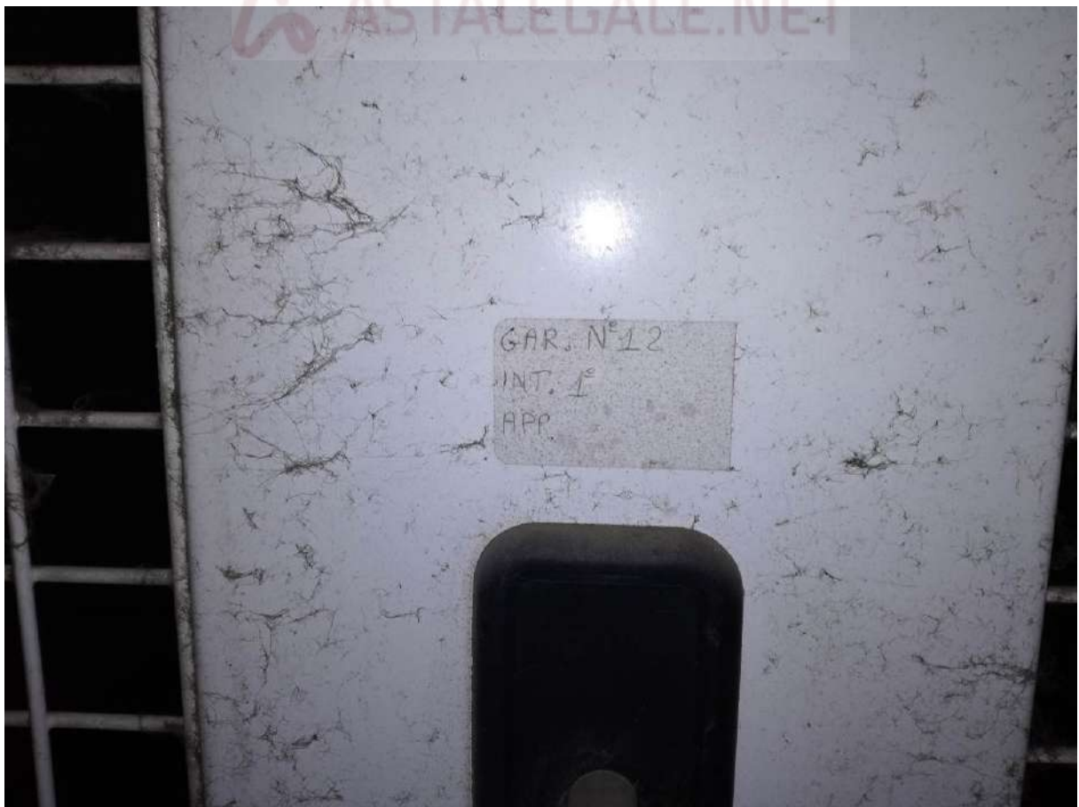
Foto 51 GARAGE n.12 P.1° INTERRATO – SUB59
