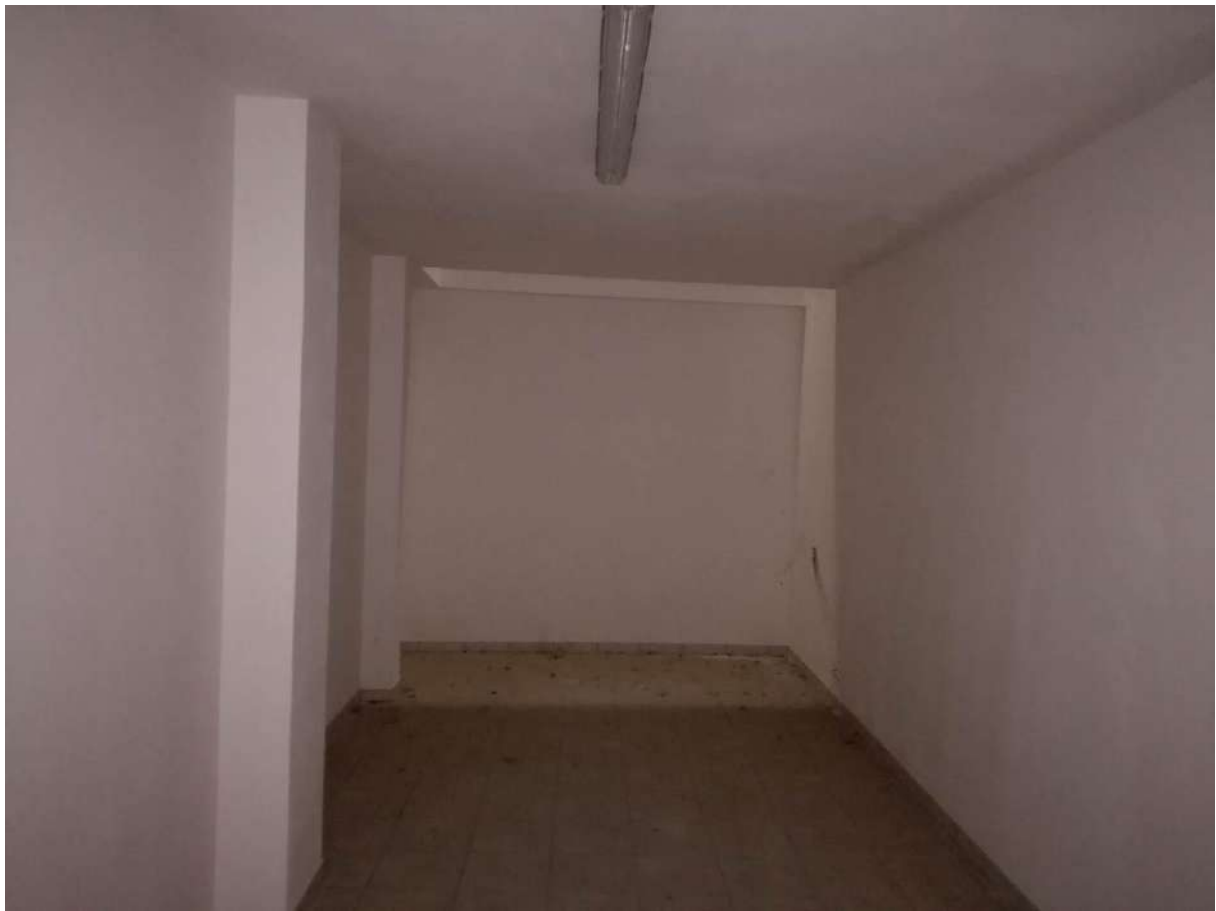
Foto 37 DEPOSITO n.5 P.2° SEMININTERRATO – SUB42
