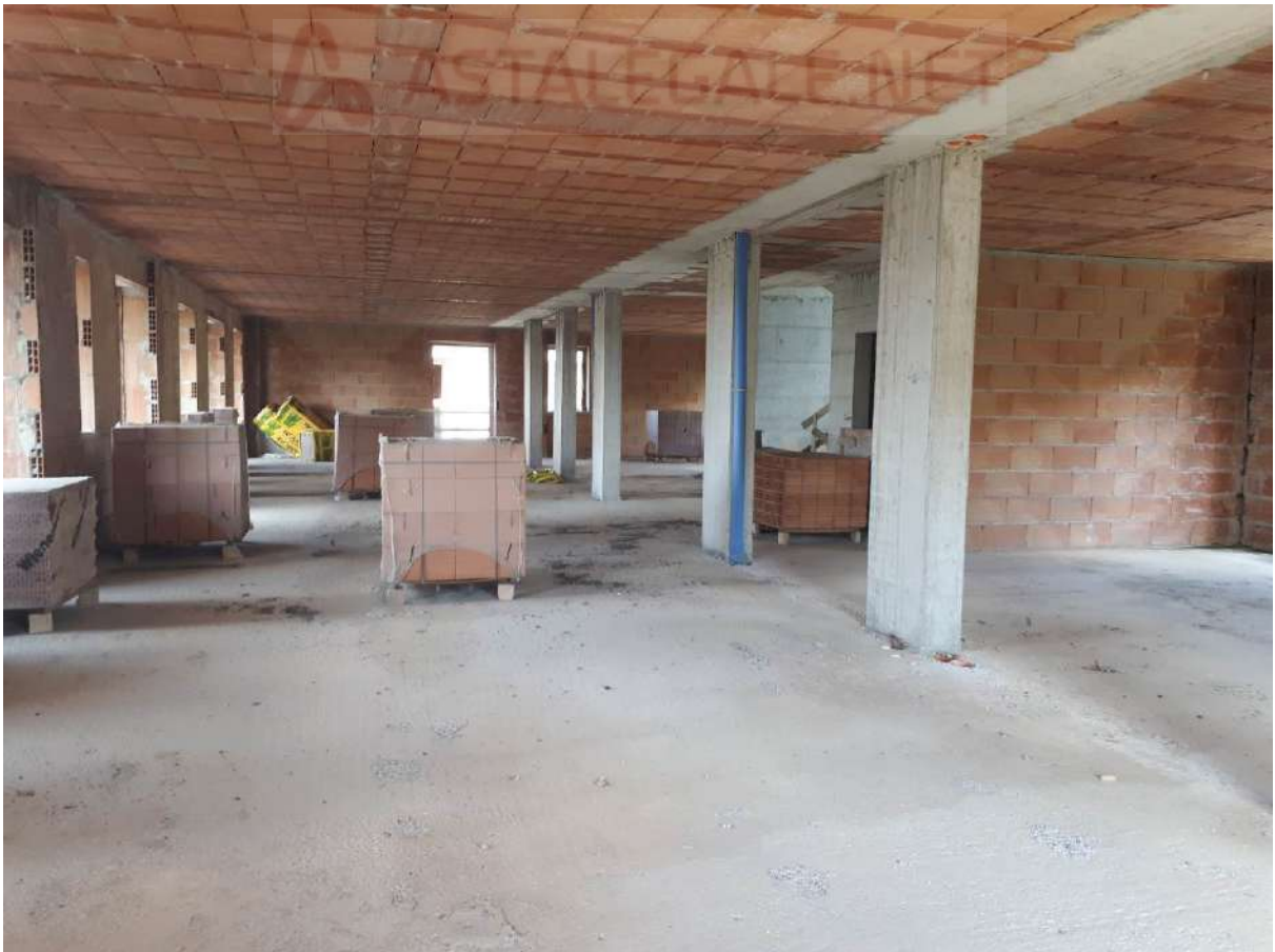
Foto 26 interno allo stato grezzo nei due edifici, porzioni con tamponature e divisori interni realizzati
