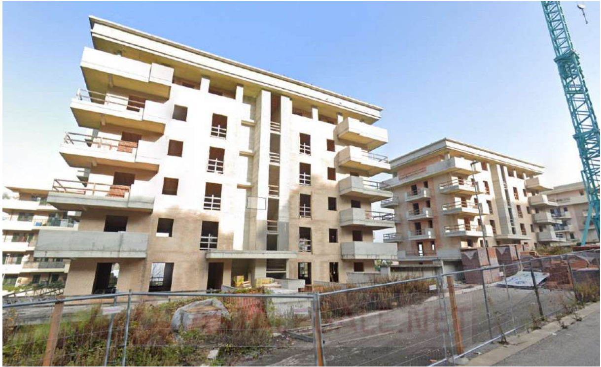
Foto 1 vista d'insieme prospetto sud
