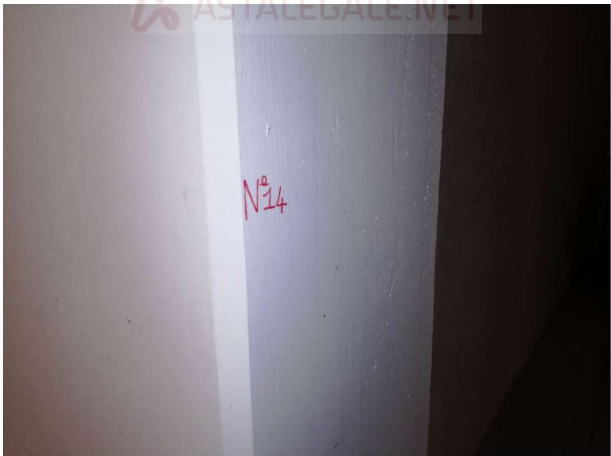
Foto 53 GARAGE n.14 P.1° INTERRATO – SUB57 (senza serranda)
