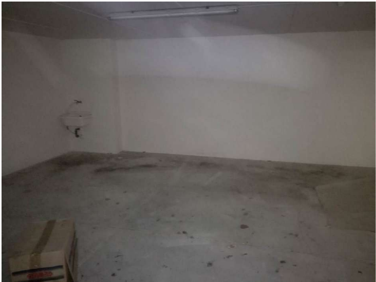
Foto 65 GARAGE n.17 P.2° INTERRATO – SUB65
