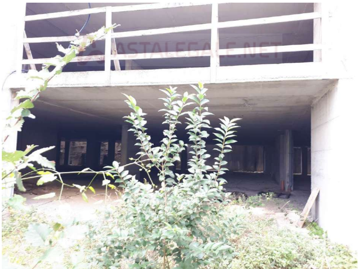
Foto 8 prospetto nord, ingresso garage piano interrato 2 comune ai due edifici
