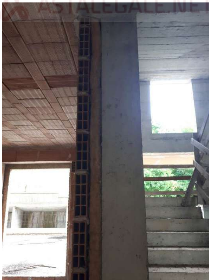
Foto 24 tamponatura interna realizzata con isolante termico
