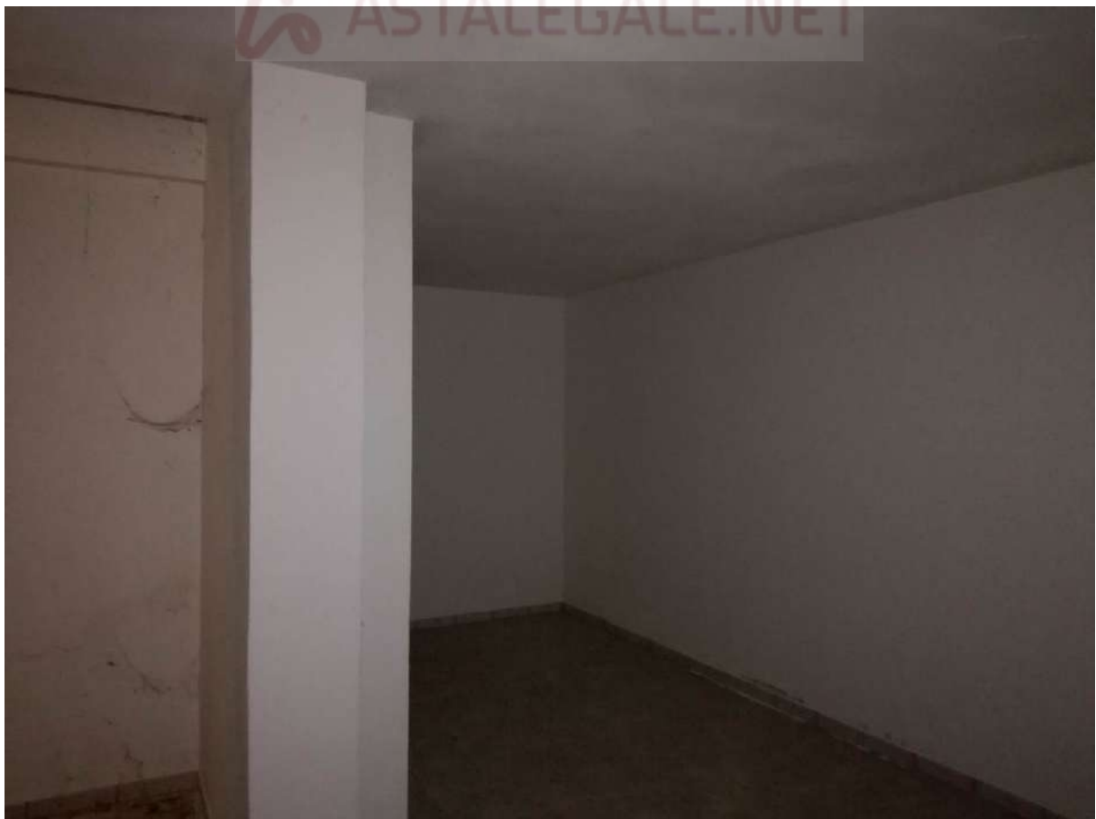
Foto 42 DEPOSITO n.7 P.2° SEMININTERRATO – SUB40
