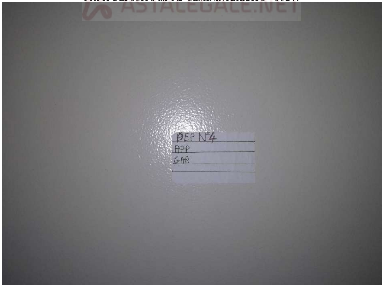
Foto 34 DEPOSITO n.4 P.2° SEMININTERRATO – SUB43
