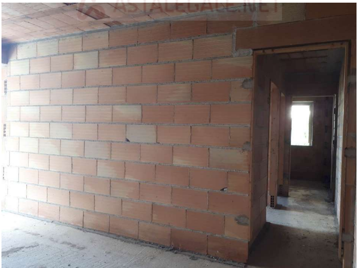
Foto 20 interno allo stato grezzo nei due edifici, porzioni con tamponature e divisori interni realizzati
