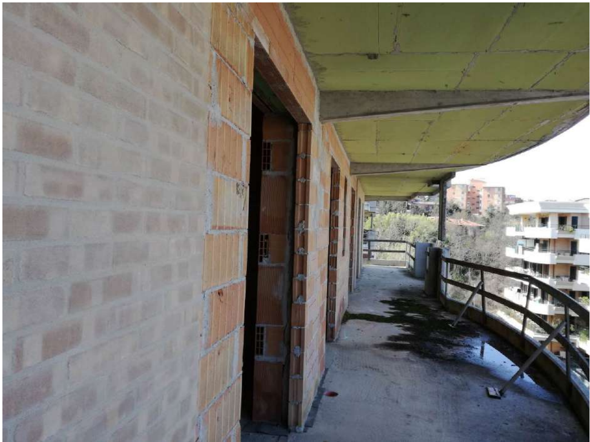
Foto 19 balconi allo stato grezzo nei due edifici
