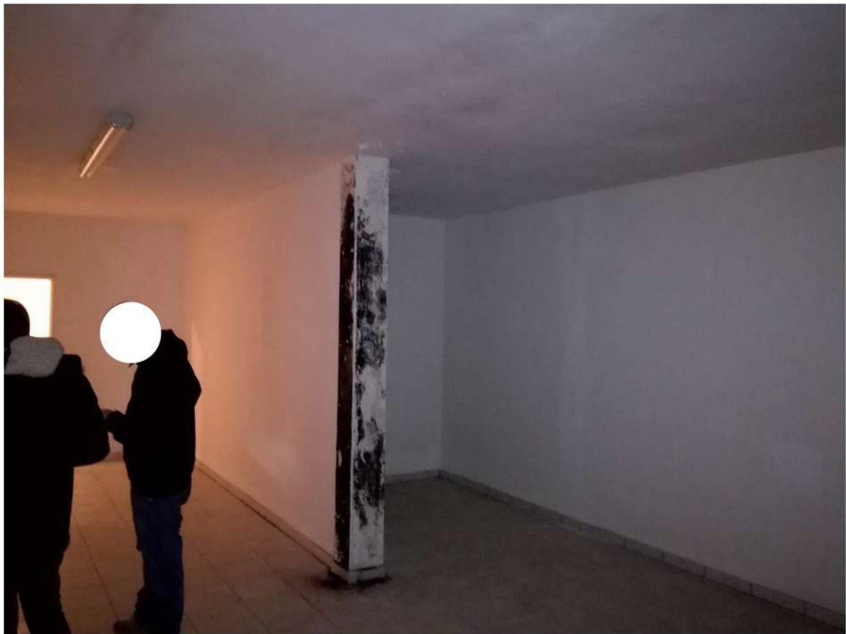
Foto 45 DEPOSITO n.8 P.2° SEMININTERRATO – SUB39
