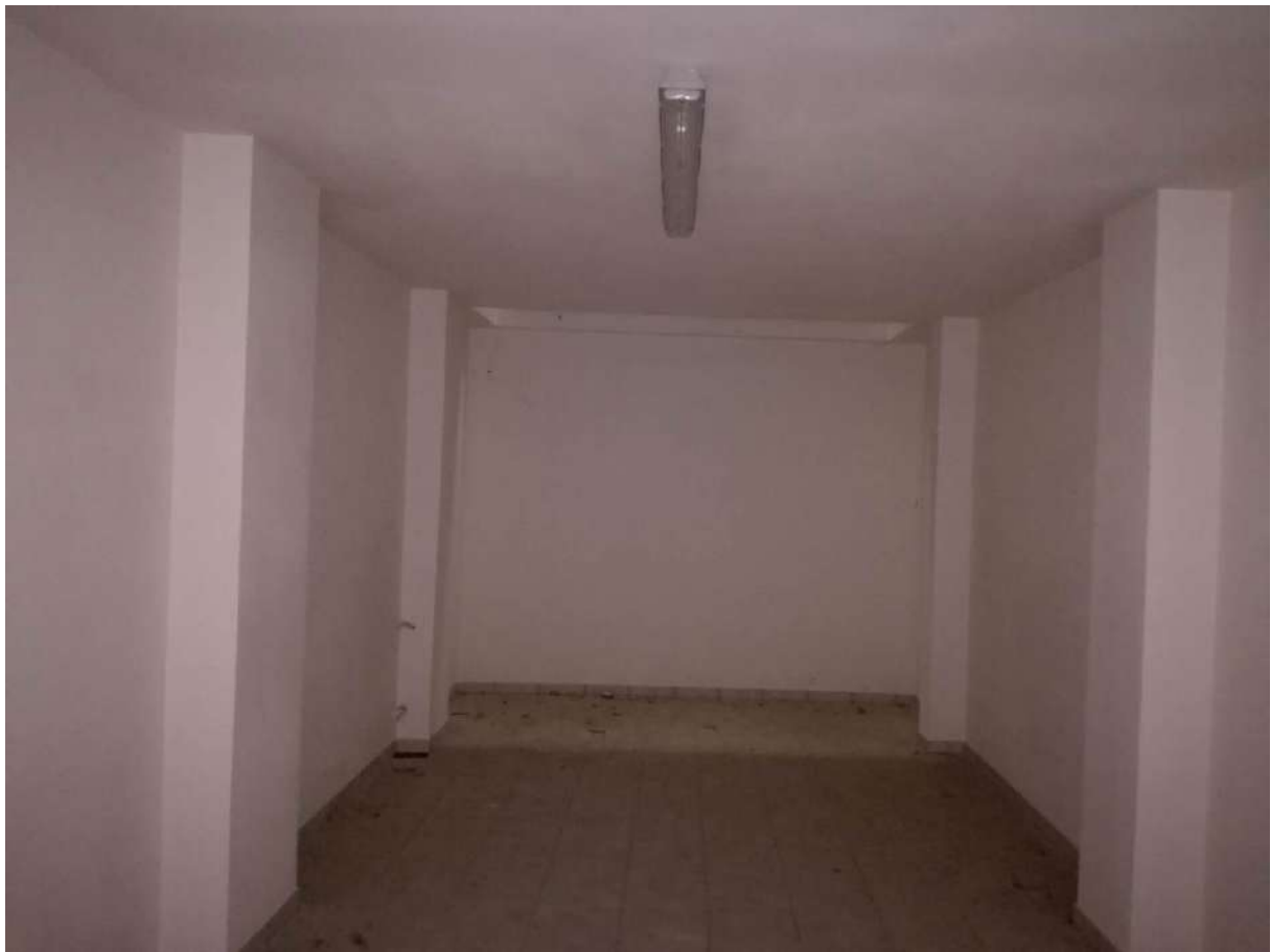
Foto 35 DEPOSITO n.4 P.2° SEMININTERRATO – SUB43
