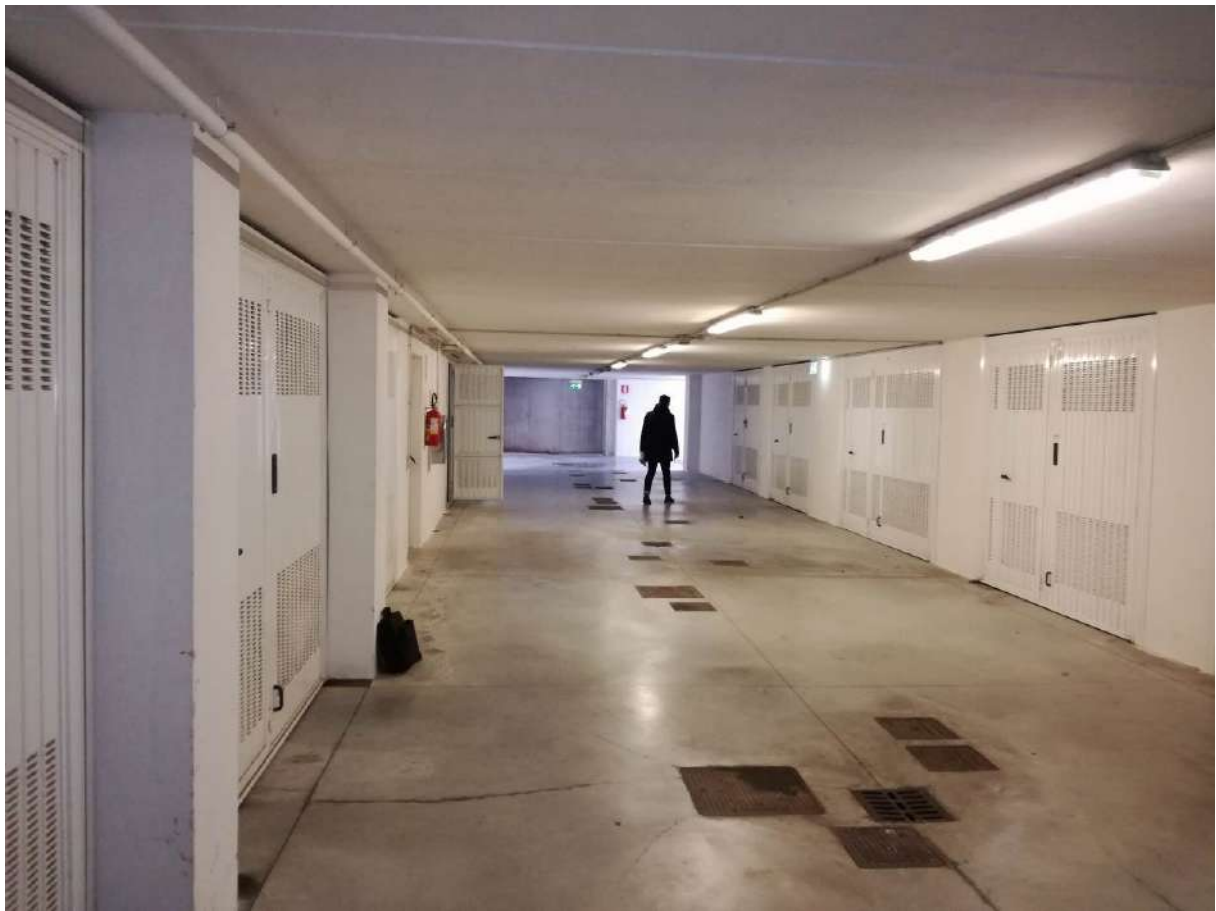
Foto 48 SPAZI DI MANOVRA P.1° INTERRATO
