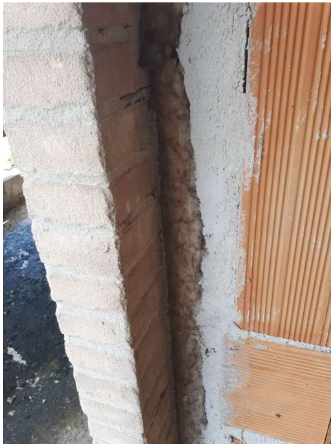
Foto 23 tamponatura esterna realizzata con isolante termico
