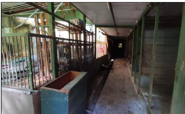
Canile lato est
