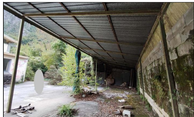
Tettoia confine nord-ovest
