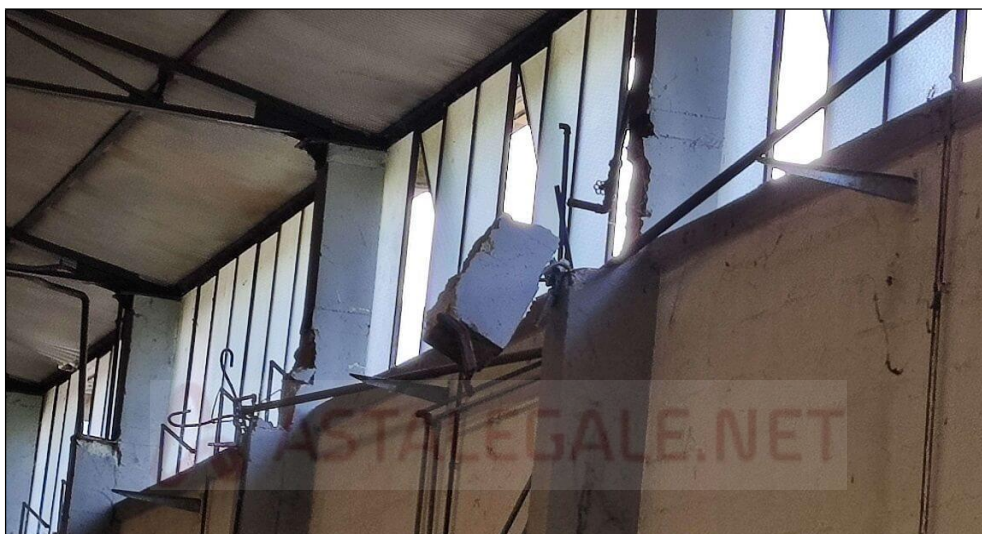
Pari dei pilastri demoliti per asportazione carroponete
