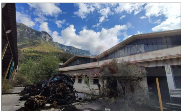
Vista lato nord
