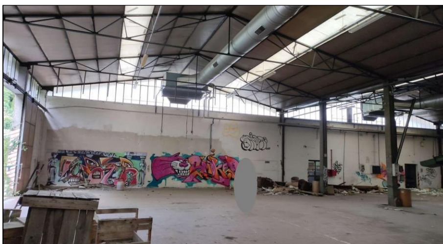
Vista interna capannone
