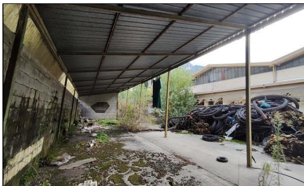
Tettoia confine nord-ovest
