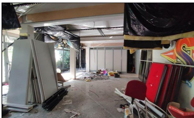
Vista interna degli uffici piano terra
