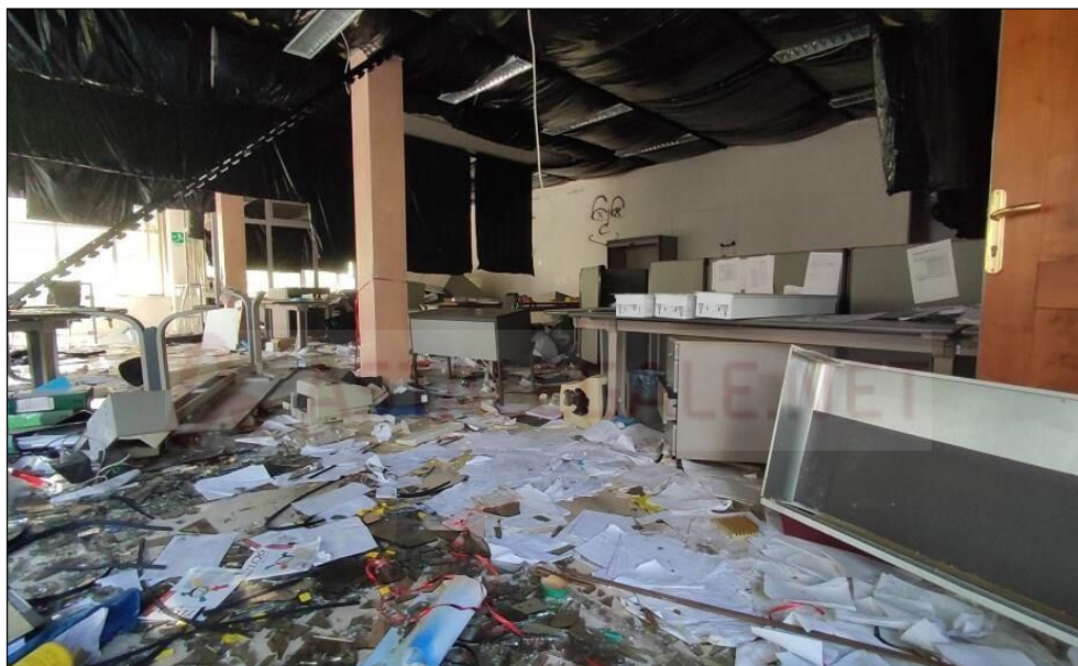
Vista interna degli uffici piano primo
