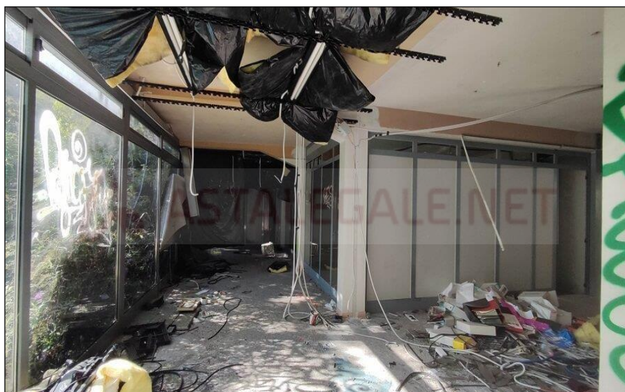
Vista interna degli uffici piano terra
