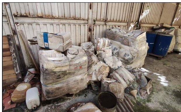
Vista interna immobile E – con rifiuti abbandonati
