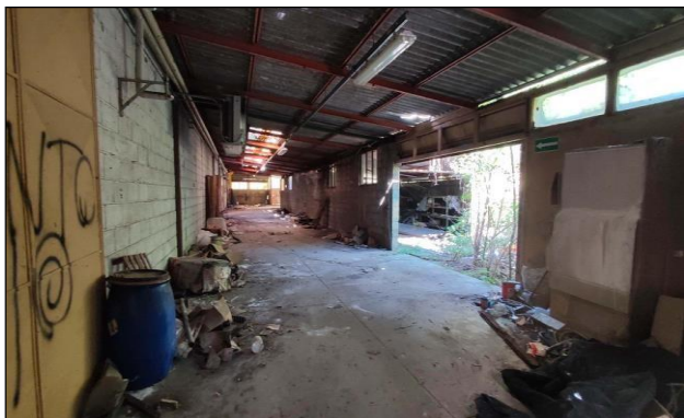
Vista immobile D – officina
