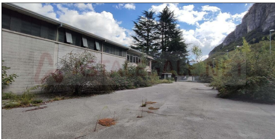
Vista facciata lato ovest
