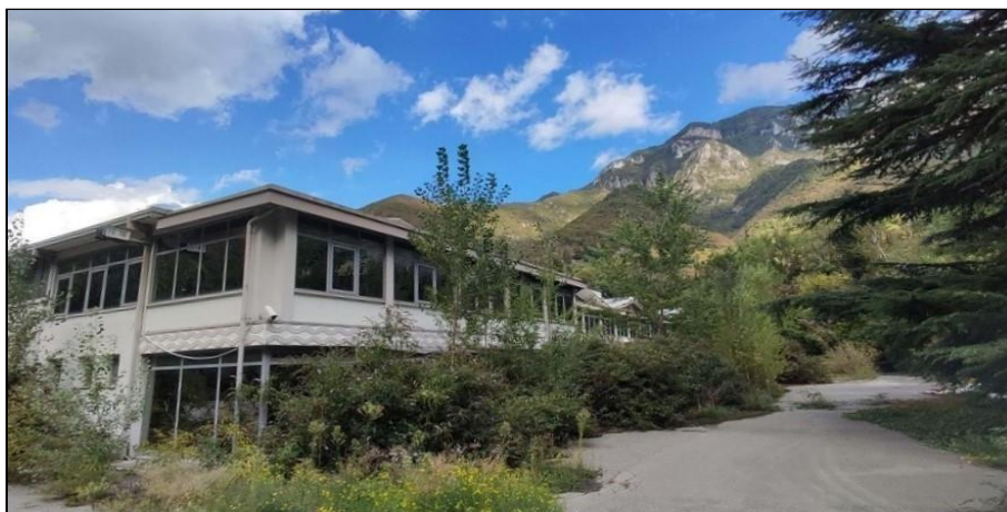
Vista dalla zona ingresso - facciata sud con uffici
