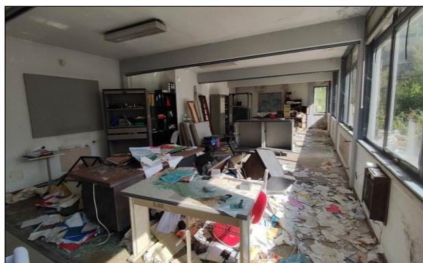
Vista interna degli uffici piano primo
