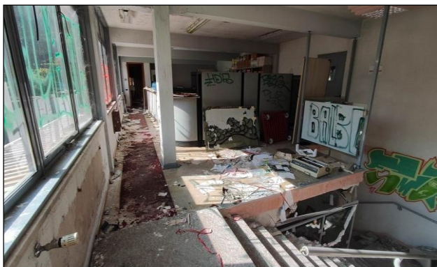
Vista interna degli uffici piano primo
