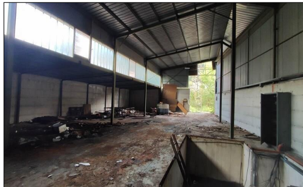
Vista interna immobile F
