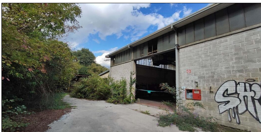
Lato ovest con ingresso al capannone
