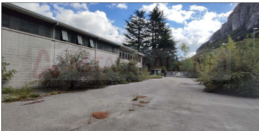
Vista facciata lato ovest
