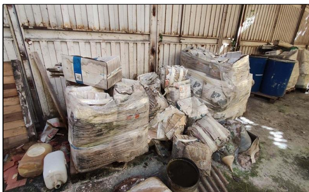
Vista interna immobile E – con rifiuti abbandonati
