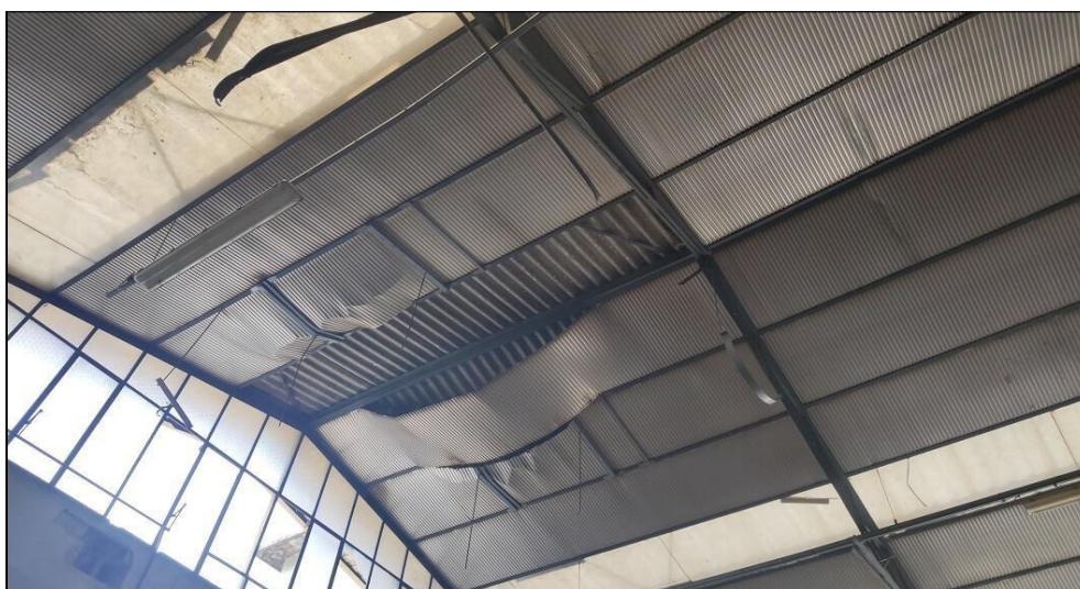
Copertura in cemento amianto – lana di roccia e lamiera
