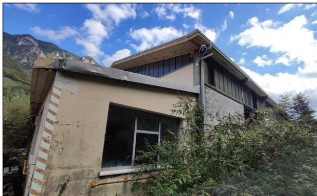
Vista angolo nord-ovest
