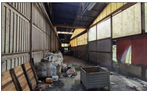
Vista interna immobile E – con rifiuti abbandonati
