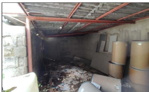
Vista deposito a confine nord-est
