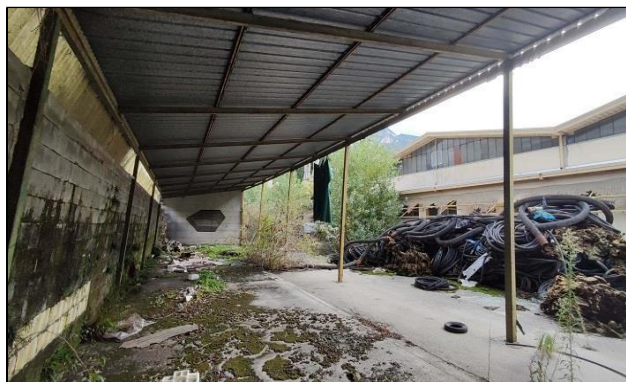
Tettoia confine nord-ovest
