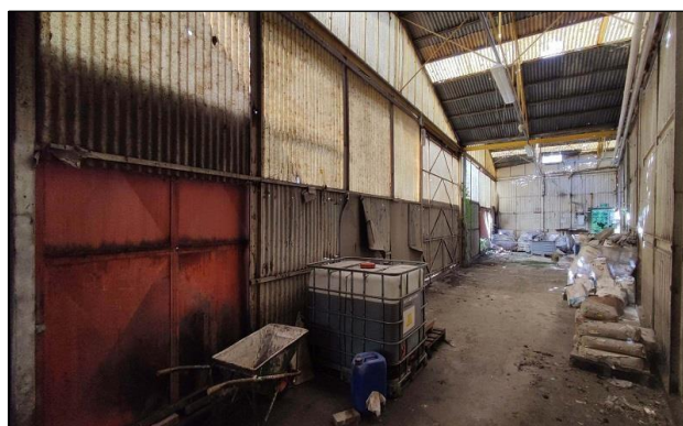
Vista interna immobile E – con rifiuti abbandonati
