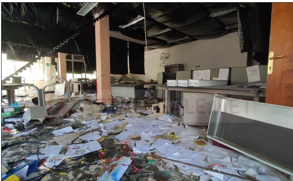
Vista interna degli uffici piano primo
