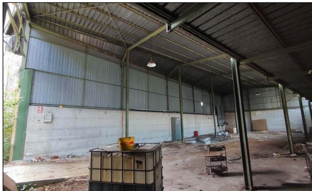
Vista interna immobile F
