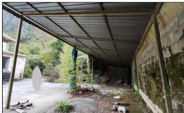
Tettoia confine nord-ovest
