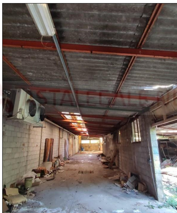
Vista immobile D – officina
