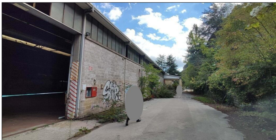
Lato ovest con ingresso al capannone
