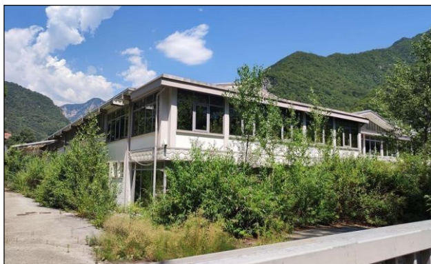
Vista esterna degli uffici – lato sud
