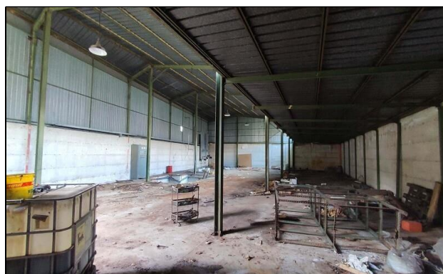
Vista parte di immobile bassa a confine nord
