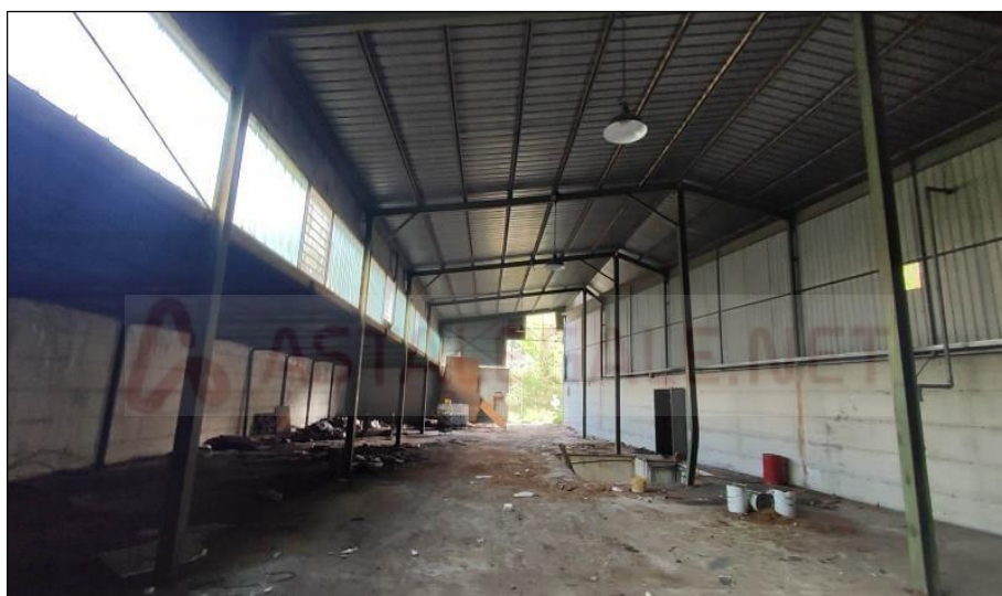
Vista interna parte principale dell'immobile F
