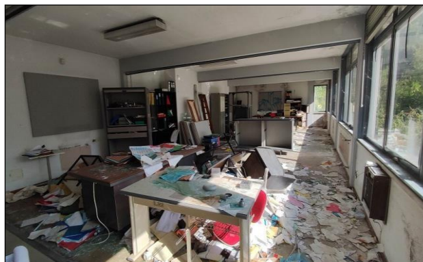
Vista interna degli uffici piano primo
