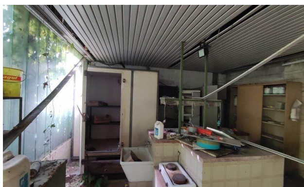
Tettoia precaria lato sud-est
