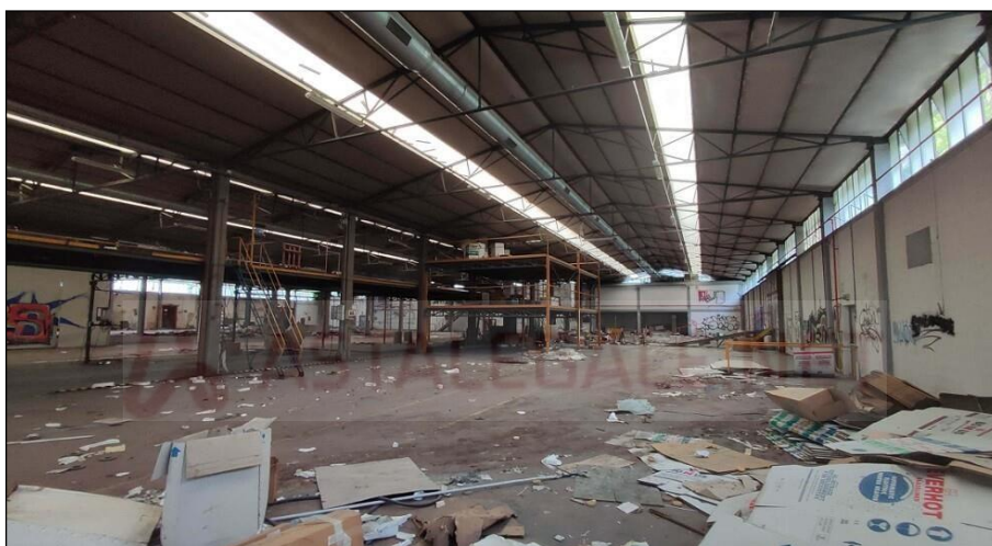
Vista interna capannone - soppalco
