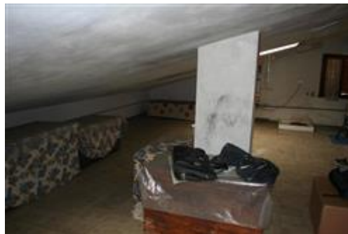
Soffitta vista verso est
