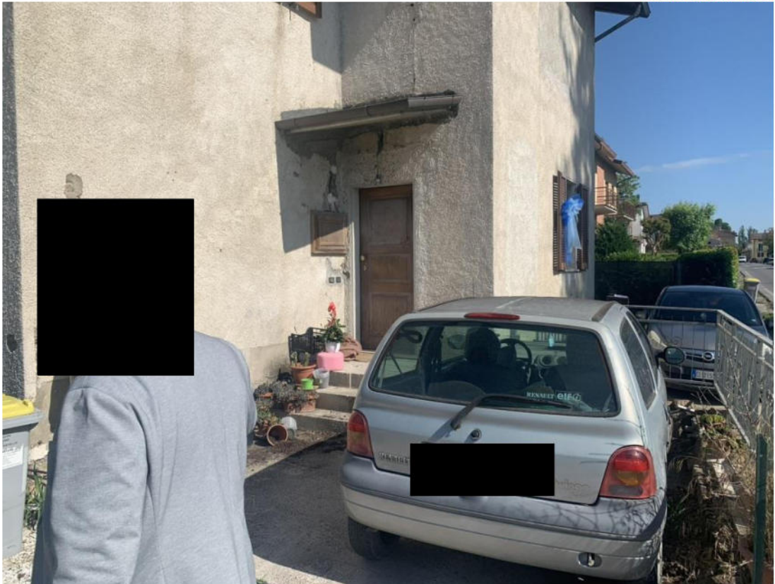
Foto n° 3 – ingresso della palazzina
