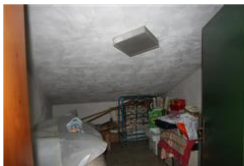
Porzione di soffitta - falda sud - ingresso sul pianerottolo
