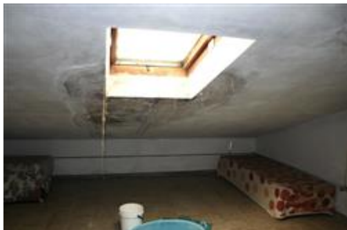
Soffitta con lucernaio
