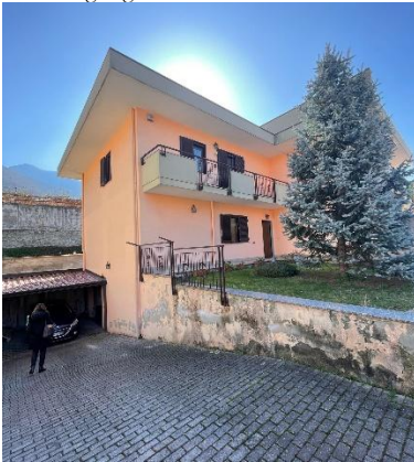
Foto 13: esterna- rampa d'accesso
