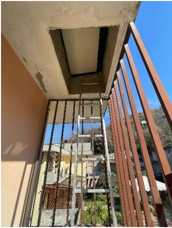
Foto 7: scala d'accesso al tetto
