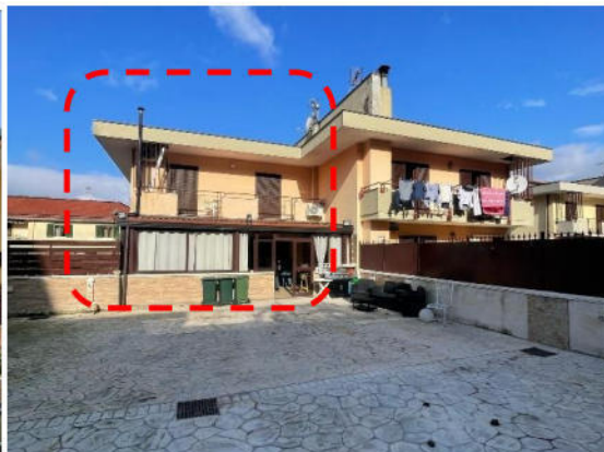
Foto: prospetto posteriore lato giardino [ sud est]
