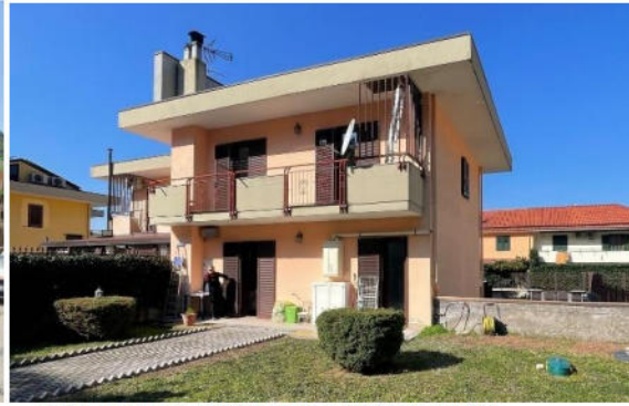
Foto: prospetto posteriore lato giardino [ sud est]
