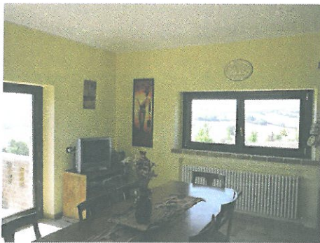
Fig. 27 - Immagine della cucina; si noti la porta finestra di accesso al terrazzo sulla sinistra, la pavimentazione in cotto della dimensione di 30x30cmq con inserti di 5x5 cmq del colore beige; le pareti sono finteggiate di colore giallo;
