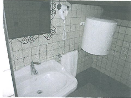
Fig. 53: Immagine relativa al bagno della camera di cui alla fig. 52; si noti lo scaldabagno elettrico per l'acqua calda sanitaria, i rivestimenti alle pareti con mattonelle delle dimensioni 10x10 di ordinaria fattura, la presenza di un box doccia
