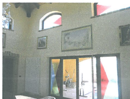
Fig. 25 - Immagine del vano soggiorno, si notino le vetrate decorate e la porta finestra di accesso al balcone, coperto con tavolato in difformità al permesso di costruire.
