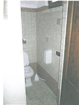
Fig. 45 - Bagno ricavato al piano terra, al di sotto della scala che conduce al piano primo, tra i due portoni di ingresso alla sala ristorazione
