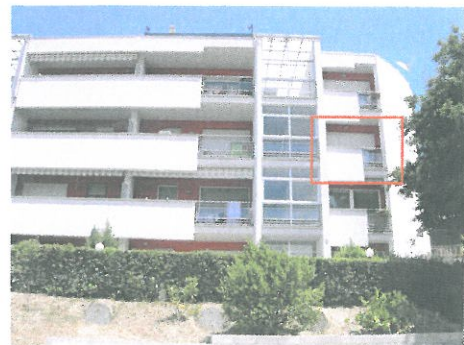
Foto 3-4: Viste del prospetto Ovest- si noti il vano scala condominiale, in corrispondenza del quale a piano terra è ubicato l'ingresso condominiale pedonale; si noti la corte condominiale a verde, si noti l'ingresso al vano garage, situato sul medesimo prospetto; si noti altresì la scelta architettonica di alleggerire i parapetti dei balconi, con porzioni in metallo verniciato di colore chiaro e vetro (si noti l'individuazione dell'immobile A- Appartamento). Si evidenzia l'ottimo stato di conservazione del fabbricato
