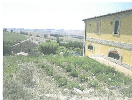
Fig. 9 - Porzione di particella adibita ad orto; da tale scorcio si nota la country house di cui al Lotto 2 corpo C, comunicante con la villa residenziale per mezzo di una scalinata in legno in seguito illustrata
