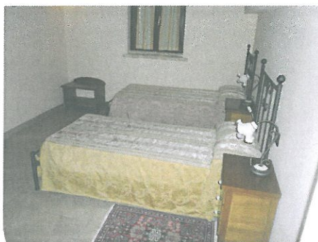
Fig. 60 - Immagine relativa ad una camera doppia situata al piano primo (si noti l'ottimo stato di conservazione e l'assenza di tracce di umidità)
