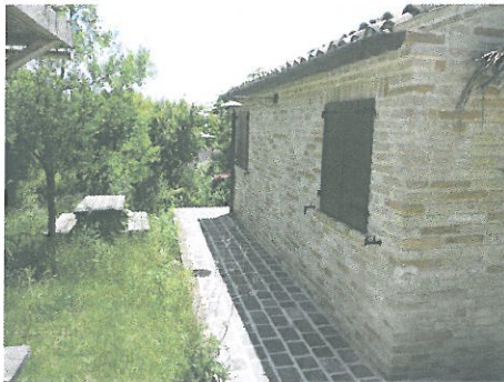
Fig. 26: Annesso C prospetto Est
