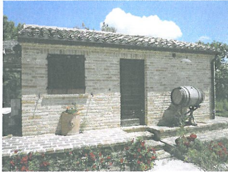
Fig. 25 - Annesso C (prospetto Est)
