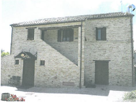
Fig. 16: Immagine relativa al prospetto Est, ove si può apprezzare la peculiarità tipica delle case coloniche del maceratese, quale la scala ad una rampa per accedere al piano superiore. Si noti la presenza al piano terra in sinistra dell'accesso alla zona pranzo/ristorazione del fabbricato, con portone in legno e tettoia in ferro lavorato. Al piano superiore invece, per tramite della scala, si accede alla zona notte con camere per ospiti del complesso turistico.
