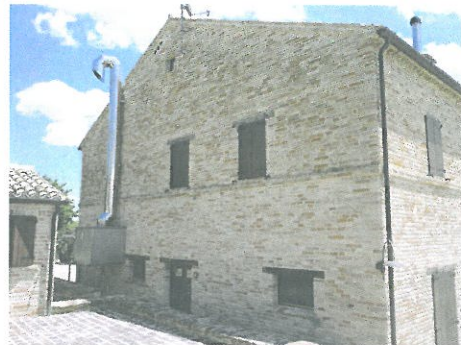
Fig. 15 - Immagine relativa al prospetto Nord del fabbricato adibito a country house, da cui si scorge la canna fumaria del forno professionale della cucina sita al piano terra del fabbricato. A sinistra nell'immagine si scorge una porzione dell'annesso B (adibito a spogliatoio e ripostiglio)
