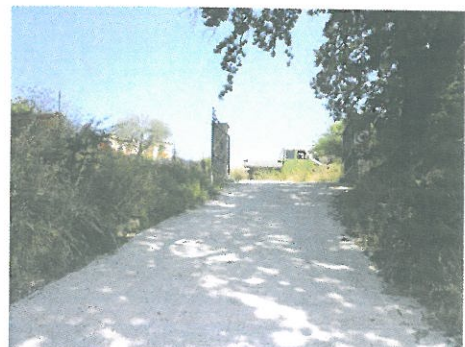
Fig. 2 - Ulteriore immagine relativa alla stradina d'accesso al lotto 4 e per tramite di esso al lotto 3
