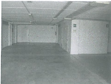
Fig. 25: Immagine relativa all'accesso comune che conduce alle singole autorimesse (si noti la pavimentazione in calcestruzzo (pavimentazione industriale), le pareti tintecciato di colore bianco in un ottimo stato di conservazione)
