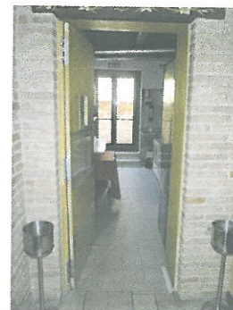
Fig. 39 - Porta di accesso alla cucina; si noti il diverso rivestimento a terra, realizzato in cucina con mattonelle in gres ceramica di colore grigio
