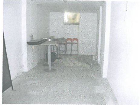
Fig. 27 - Box Auto (si noti la pavimentazione industriale, l'impianto di illuminazione e la bocca di lupo, ad illuminare ed aerare il vano)
