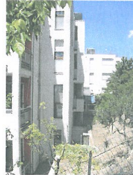
Foto 1-2: Prospetti Sud ed Est; sul prospetto sud si affaccia l'immobile di cui al corpo A (balcone); la seconda immagine mostra invece il prospetto est, separato per mezzo della corte condominiale dagli attigui edifici residenziali; si noti l'ottimo stato di conservazione delle finiture esterne (tinteggiatura di colore bianco e rosso, parapetti e solette dei balconi in cemento armato).
