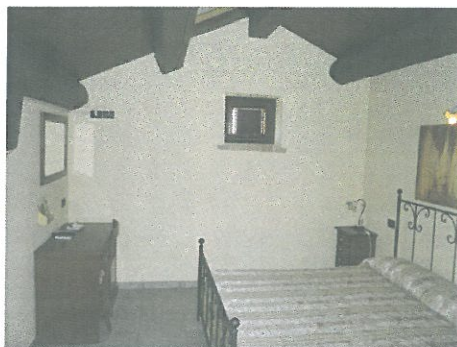
Fig. 52 - Camera doppia sita al piano secondo. Si noti la copertura con travi in legno e tavolato
