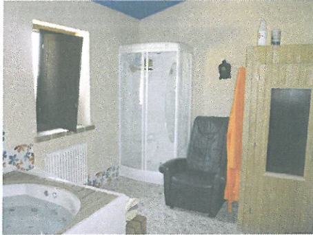
Fig. re 35-36: Bagno principale; presenta rivestimenti in gres porcellanato di colore blu delle dimensioni di 60x24, con inserti di altri colori e disegni; lo stesso risulta accessoriato con sauna, idromassaggio e doccia
