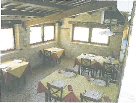
Fig. 32: - Immagine relativa al vano principale adibito a sala pranzo/ristorazione; porzione di sala su livello; si annota la presenza dello split dell'impianto di condizionamento; si notino le finestre in legno di douglas e le pareti in mattoni a faccia a vista
