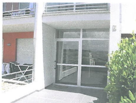
Foto 7: Particolare del prospetto Ovest in cui si trova il portone di ingresso al corpo condominiale per raggiungere l'immobile A (in vetro ed alluminio colore grigio chiaro); si noti la pavimentazione di colore grigio scuro ed in ottimo stato di conservazione.
