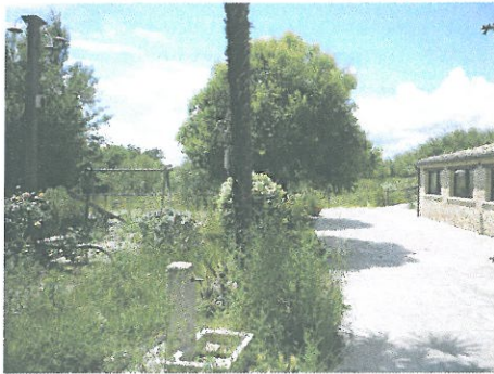
Fig. 9: Immagine relativa alla corte esclusiva della country house, nella zona attigua al prospetto Sud, ove è localizzata la corte pavimentata e la zona a verde attrezzata con giochi per bambini, con la presenza di una fontana
