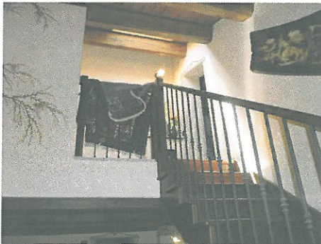
Fig. 51: Immagine relativa alla scala di accesso al piano secondo (corrimano in legno e ferro lavorato)
