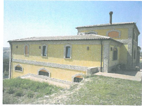
Fig. 15 - Immagine relativa al prospetto est della villa; si notino i discendenti e canali di gronda in rame, la copertura in coppi; si osservi altresì la presenza della canna fumaria del camino
