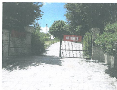
Fig. 5. Immagine relativa all'accesso carrabile e pedonale che consente di raggiungere la country house direttamente dalla Strada Provinciale 81 Montefano / Osteria Nuova; si nota la presenza di muri di cinta in mattoni a faccia a vista, nel medesimo stile architettonico della country house, la recinzione in ferro lavorato e la pavimentazione in piastrelle disposte secondo un preciso disegno geometrico.
