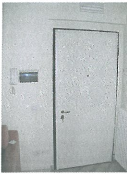
Fig.13: Portone blindato visto dall'interno dell'unità abitativa.
