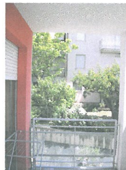
Fig. 21 - Ulteriore visuale dal balcone B1 in direzione Est (da cui si vede l'attiguo fabbricato residenziale); si notino le tapparelle in pvc bianco e il parapetto in metallo e ferro verniciato grigio chiaro.
