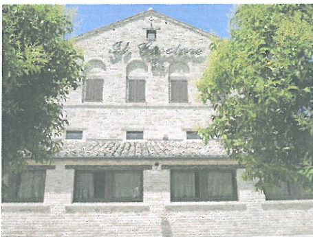
Fig. 10 - Vista del prospetto Sud della country house. Si noti la finitura a faccia a vista, le finestre e gli scuri in legno, l'ottimo stato di conservazione dell'immobile data anche la recente ristrutturazione (finita nel 2006) Si noti la copertura in coppi, per la gran parte originali e recuperati in occasione dell'intervento di ristrutturazione edilizia già richiamato
