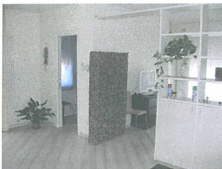
Fig. 15: Vista del soggiorno (si noti la pavimentazione flottante con listoni di parquet di dimensione 2x0,3mq di colore nocciola, di ordinaria fattura, e le pareti tinteggiate di colore bianco; si noti la presenza dei termo-arredo e la porta a scagno del bagno di legno tamburato di colore bianco)
