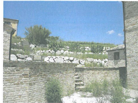
Fig. 14: Immagine relativa alla sistemazione della corte, nella zona contigua allo spigolo Nord Ovest del corpo rurale principale
