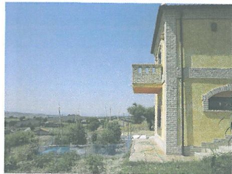
Fig. 17 - Immagine relativa allo spigolo sud-ovest della villa; si noti come in tale prospetto l'edificio presenti due piani complessivi fuori terra. Si notino i parapetti dei balconi rivestiti in mattoni a faccia a vista e la pavimentazione del marciapiede realizzato in contiguità al prospetto, su tutti i lati dell'edificio. Si osservi l'ottima visuale percepita dalla zona, che ne connota la valenza vedutistica e paesaggistica.
