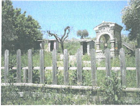
Fig. 7: Immagine relativa alla porzione di corte sede del pozzo per uso irriguo (sulla destra) anche esso oggetto della recente ristrutturazione
