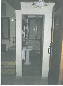
Fig. 57: Immagine relativa al bagno della camera di cui alla fig. 56; si noti lo scaldabagno elettrico per l'acqua calda sanitaria, i rivestimenti alle pareti con mattonelline delle dimensioni 10x10 di ordinaria fattura, la presenza di un box doccia
