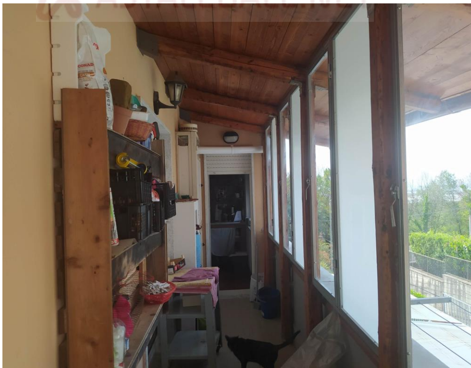
Foto n.11: Vista del balcone chiuso dall'interno
