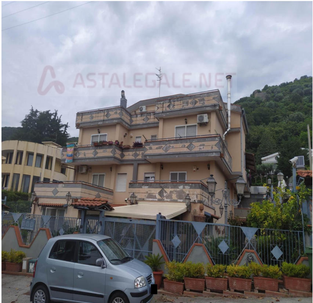
Foto n.1: Vista del prospetto principale dell'intero fabbricato dove a sinistra in alto c'è l'immobile di cui alla procedura esecutiva.
