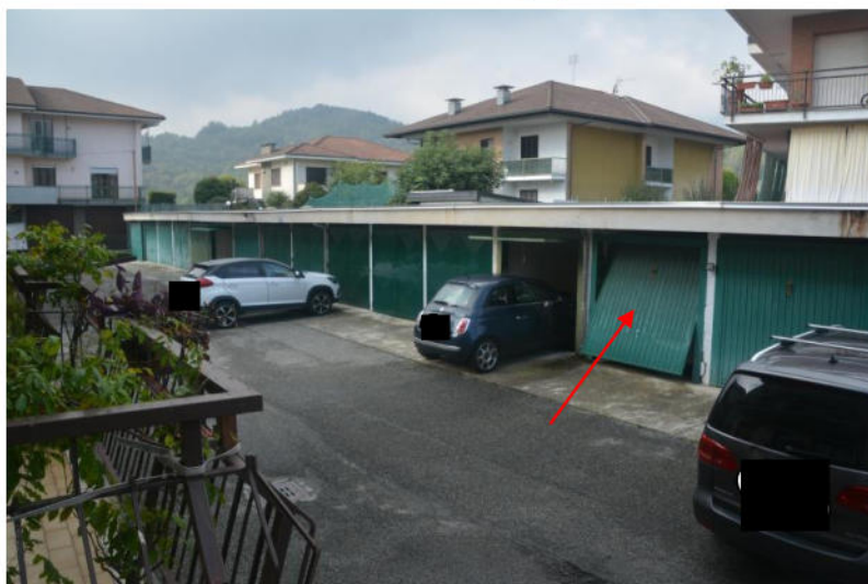
Bene n. 2 - Vista Garage piano T
