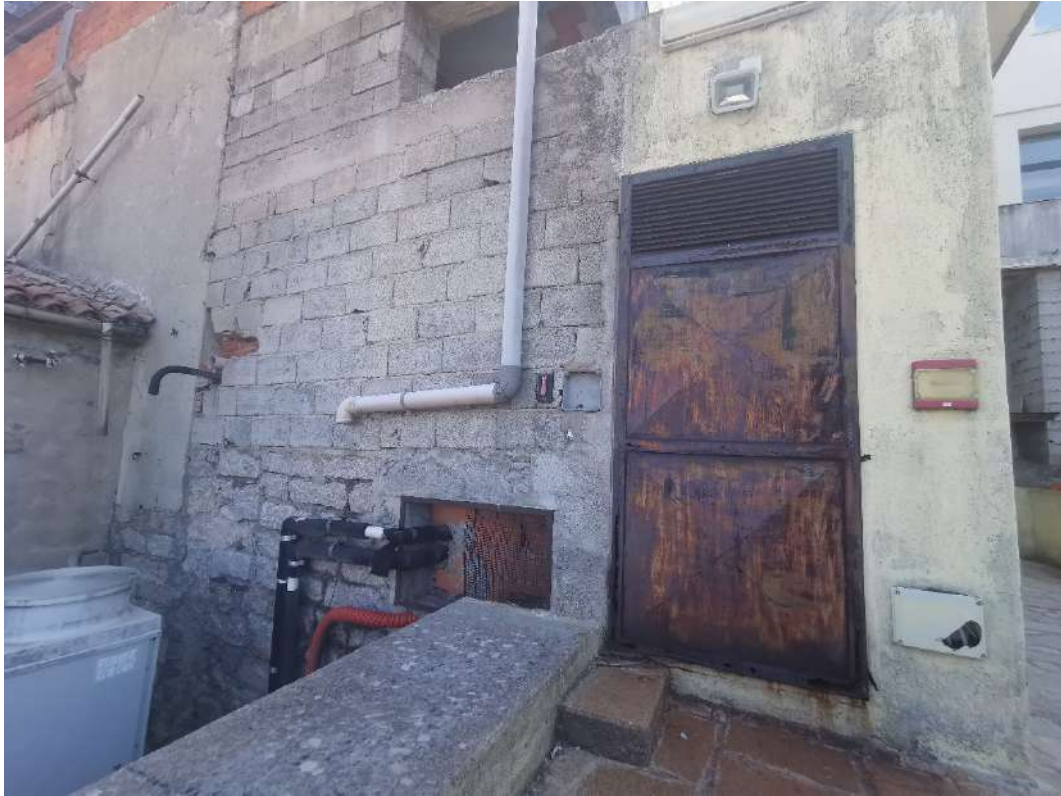
Foto 113 – Centrale Termica vista esterna
