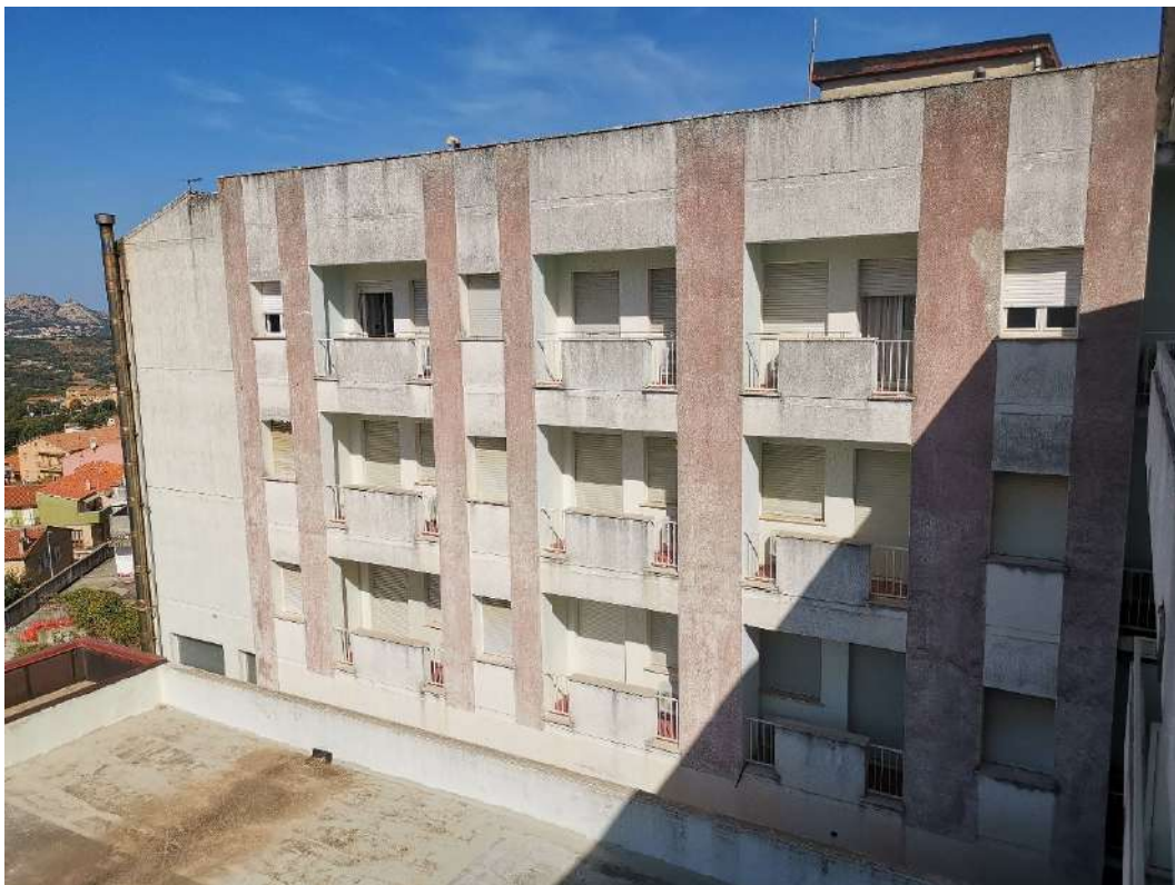
Foto 010 – Dettaglio facciata interna laterale
