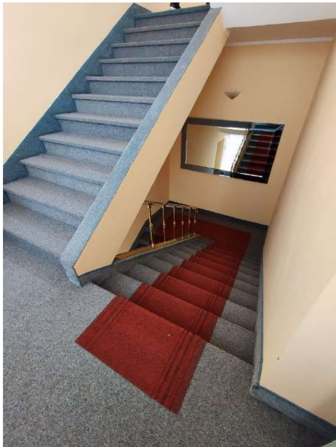
Foto 083 – Scala Interna di collegamento tra piano terzo e piano copertura
