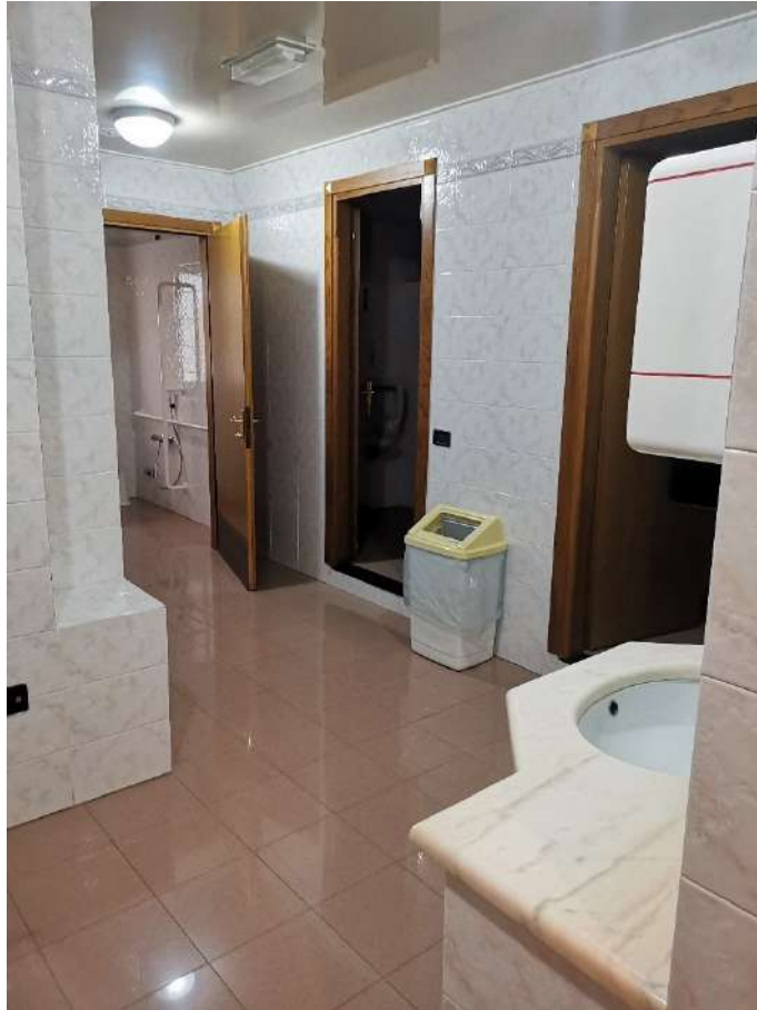
Foto 022 – Bagni di Servizio
