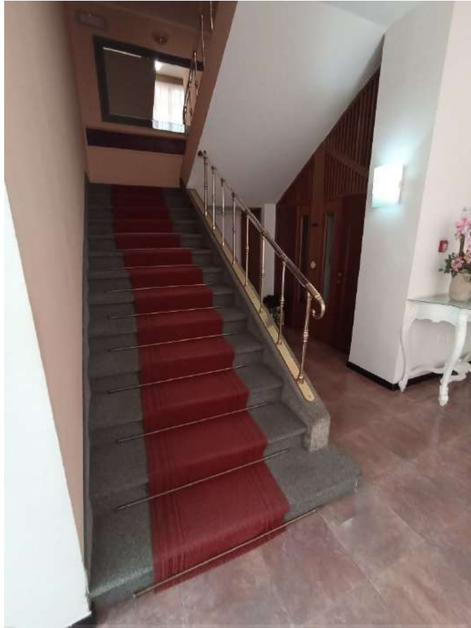
Foto 028 – Scala Interna di collegamento tra piano terra e piano primo
