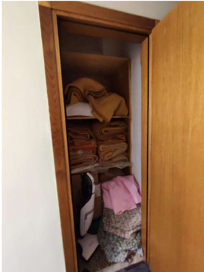
Foto 042 – Ripostiglio adiacente scale interne
