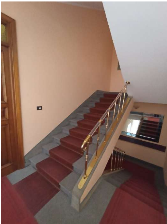
Foto 054 – Scala Interna di collegamento tra piano primo e piano secondo
