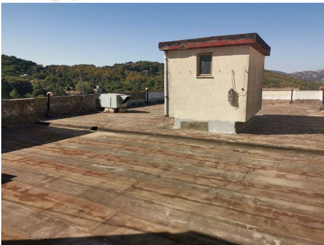
Foto 011 – Dettaglio copertura edificio
