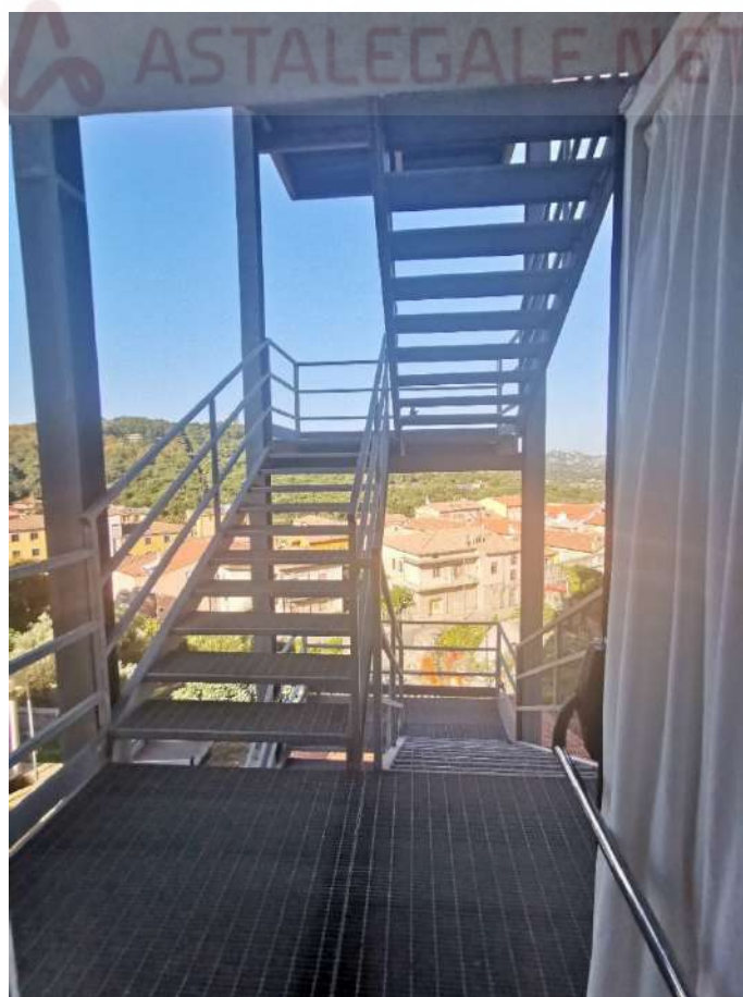
Foto 002 – Dettaglio scale di collegamento esterne
