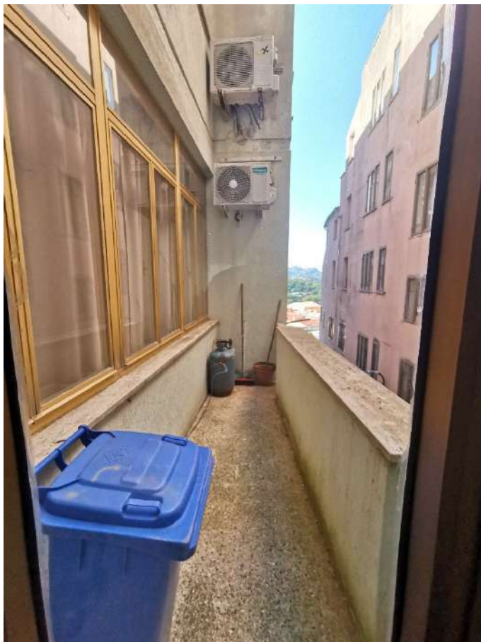
Foto 032 – Terrazzino Appartamento alloggio Gestore Hotel
