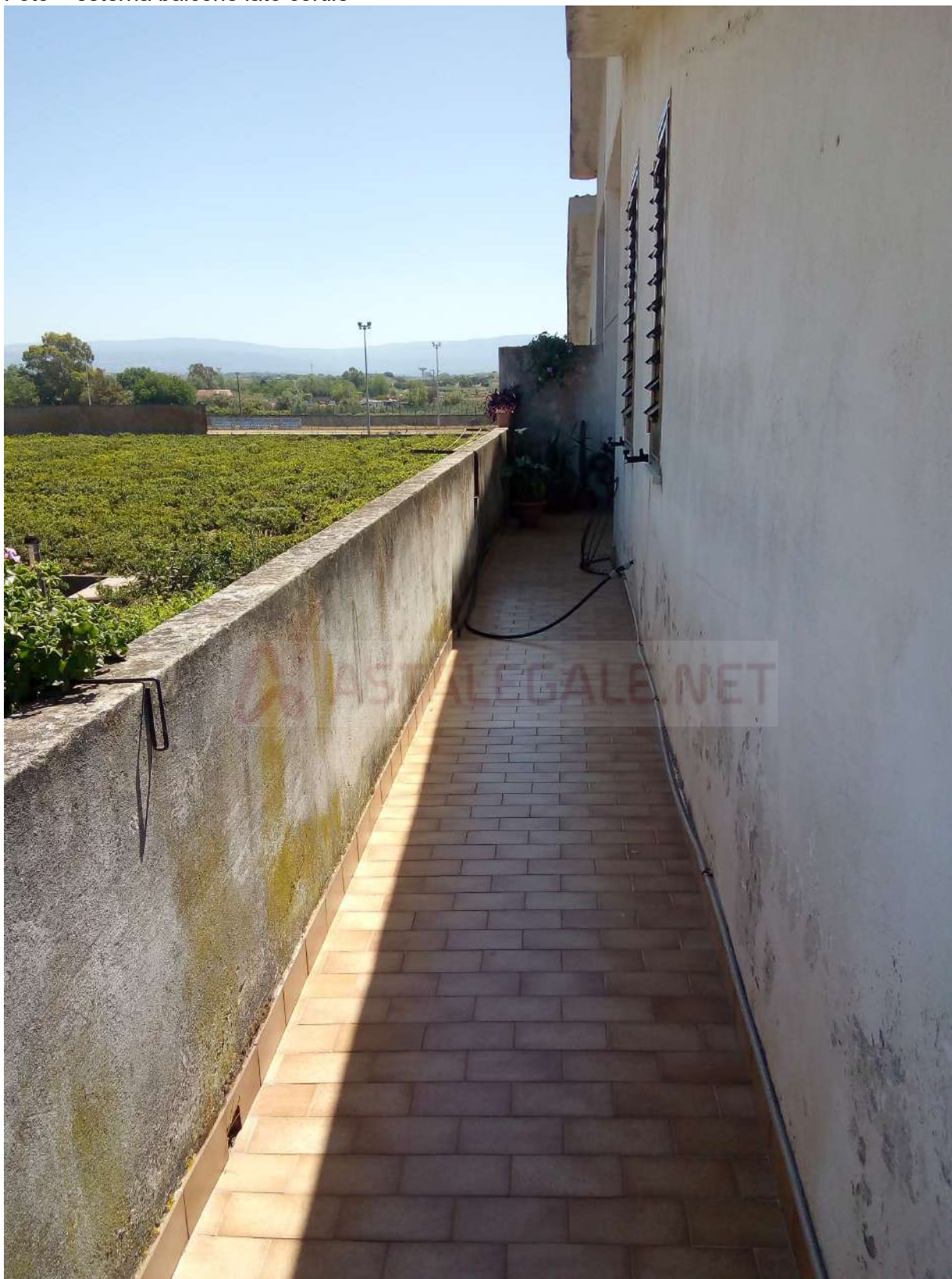
Foto – esterna balcone lato cortile
