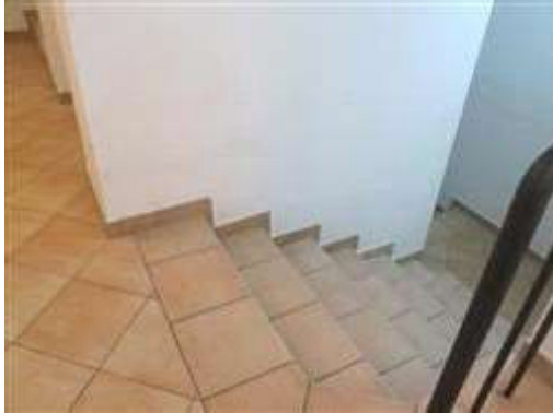
Scala interna condominiale -Fabbricato Cagli
