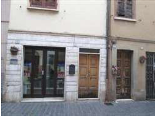
Prospetto su Corso Roma -Acqualagna
