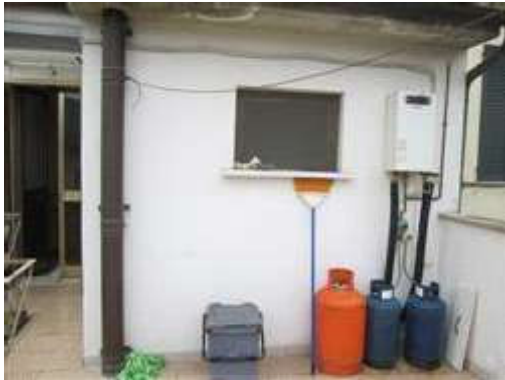
Balcone al piano primo sul retro - fabbricato Acqualagna
