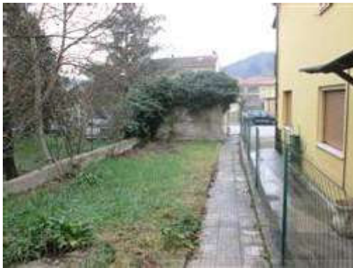
Scoperto esclusivo sul retro - Edificio Acaqualagna
