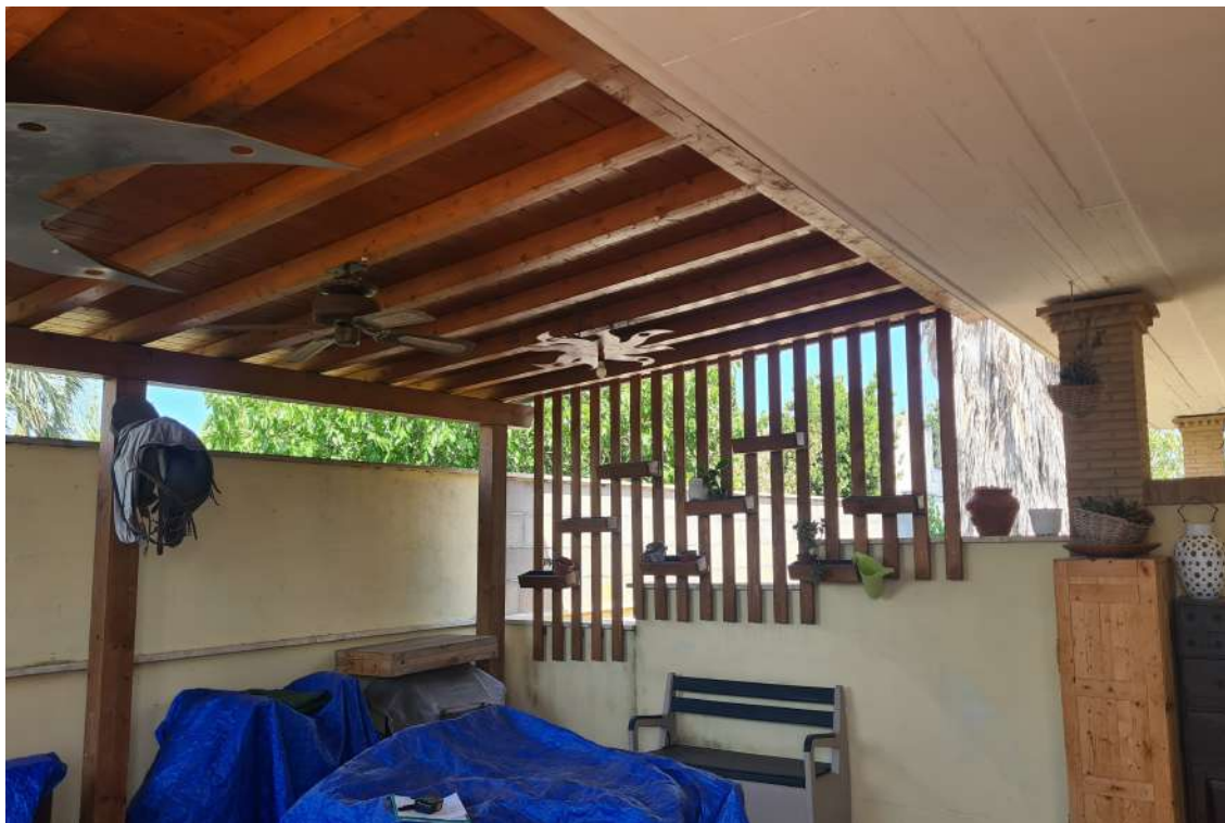
Foto 6- vista tettoia da rimuovere
