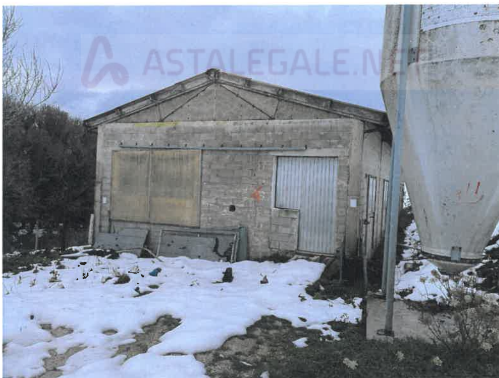
Foto 08 – stalla abusiva di demolire
