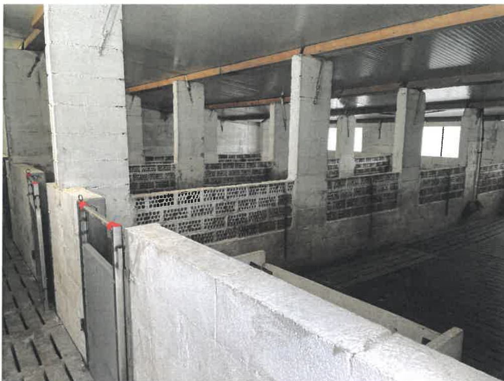
Foto 11 – stalla abusiva di demolire
