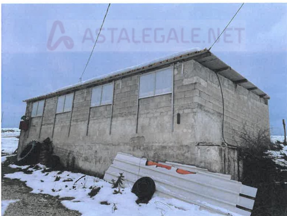
Foto 10 – stalla abusiva di demolire
