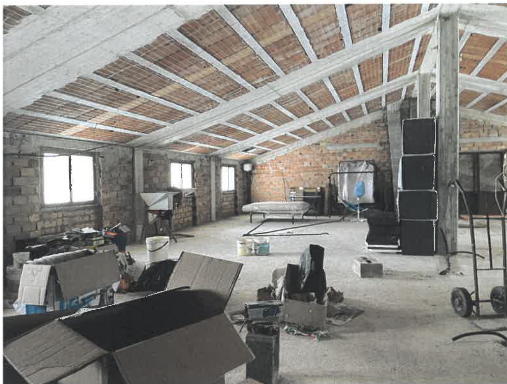
Foto 11 – magazzino al piano primo
