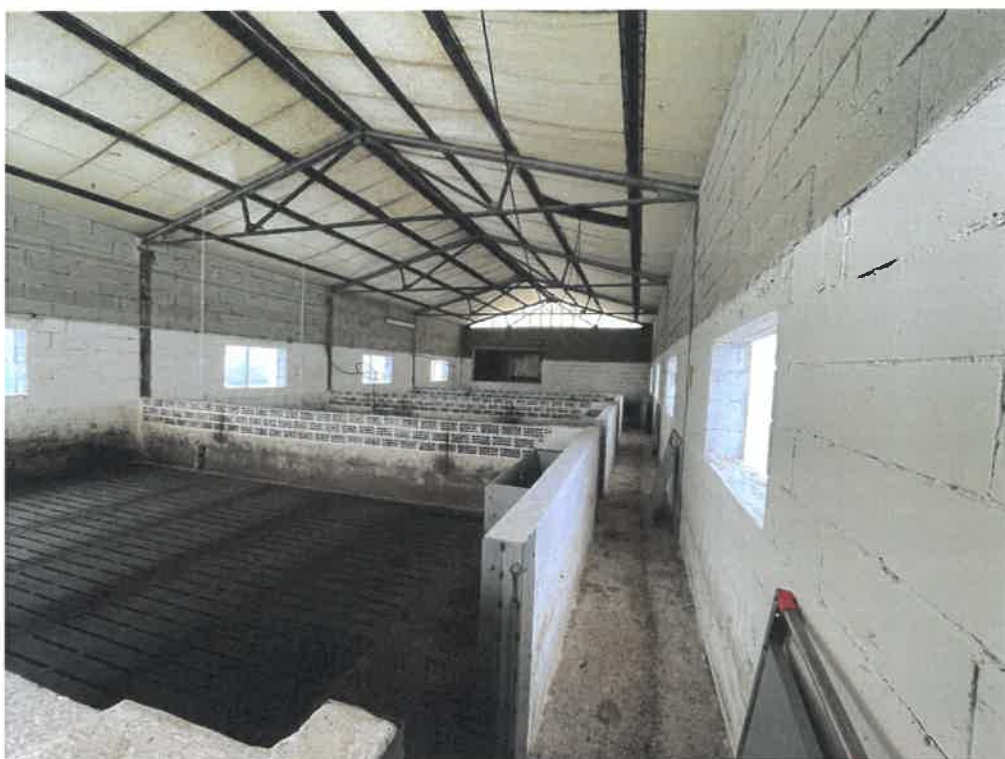
Foto 09 – stalla abusiva di demolire
