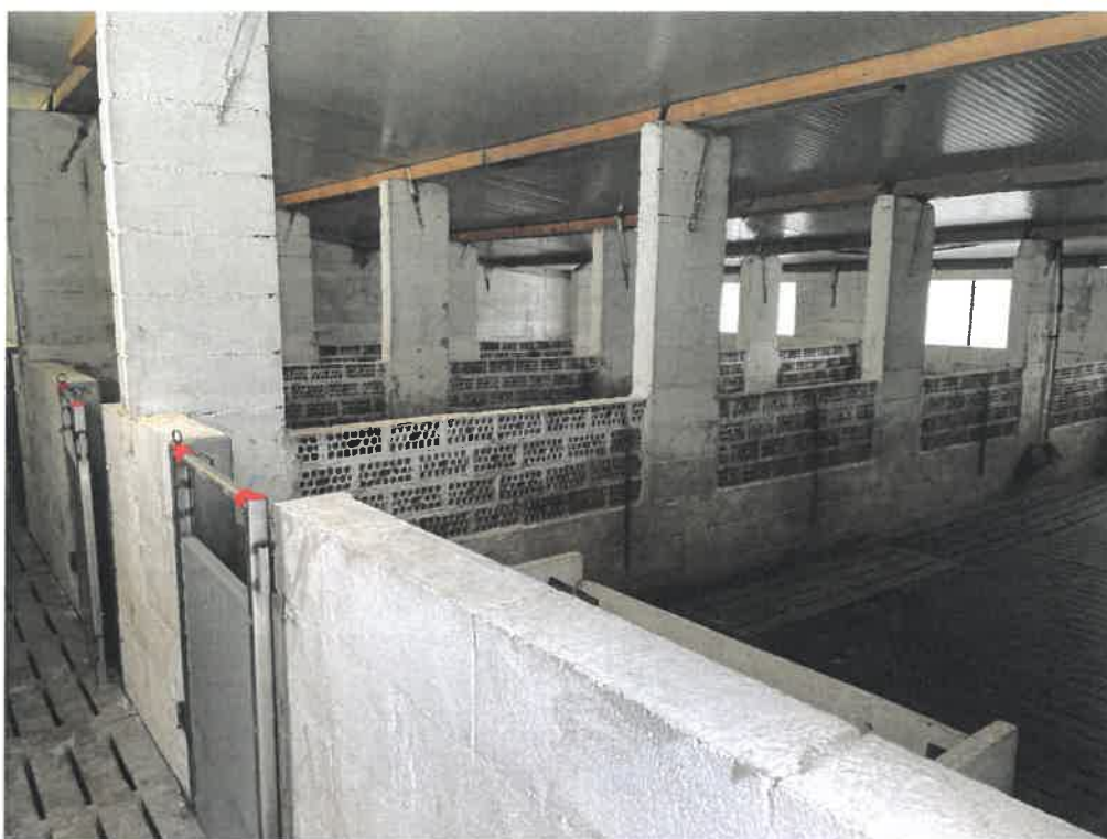
Foto 11 – stalla abusiva di demolire
