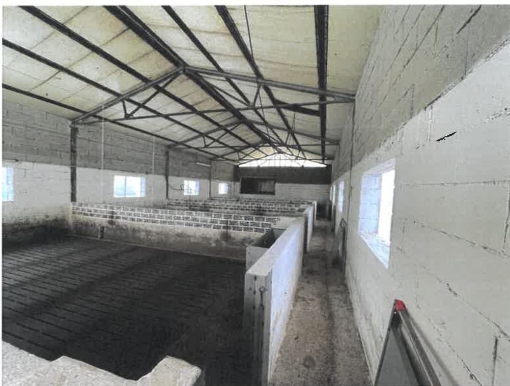
Foto 09 – stalla abusiva di demolire
