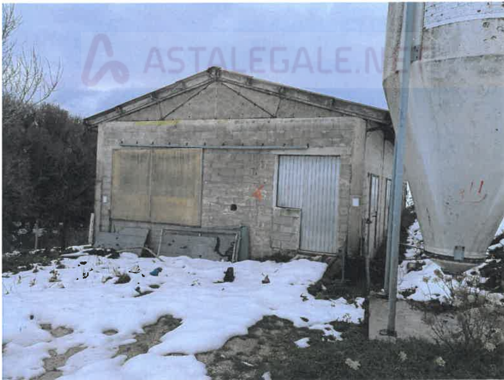
Foto 08 – stalla abusiva di demolire
