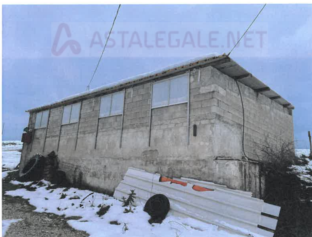
Foto 10 – stalla abusiva di demolire
