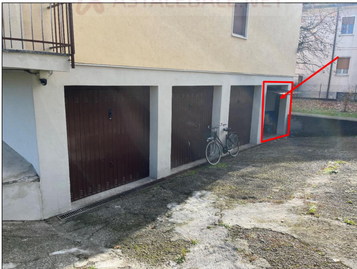
Foto n. 4 – Vista dai Box dal cortile condominiale
