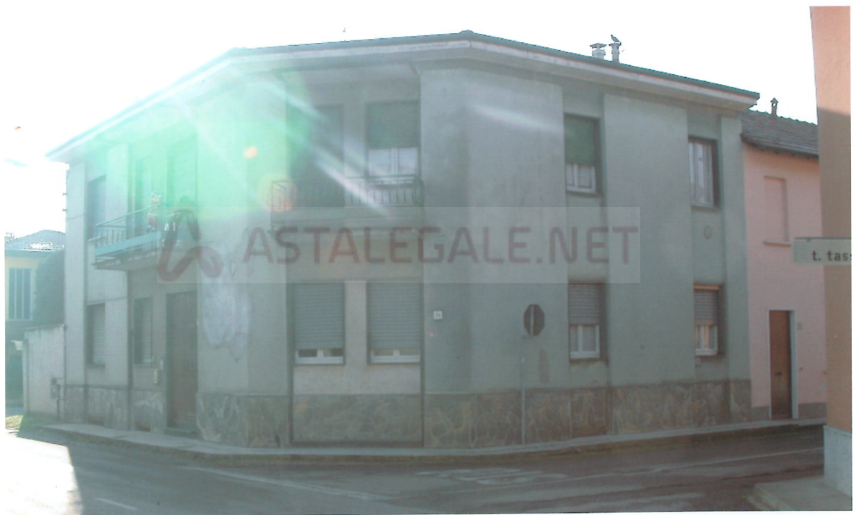
Foto n°11: Prospetti su strada del fabbricato di cui al mappale 169.
