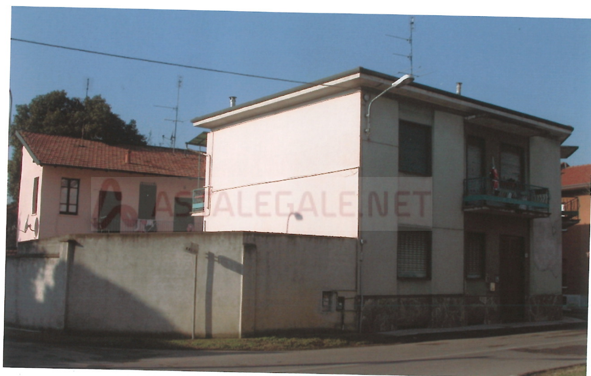
Foto n°10: Via XXV Maggio n°45 - Prospetto su Via S. Francesco dell'edificio di cui al mappale 169,
