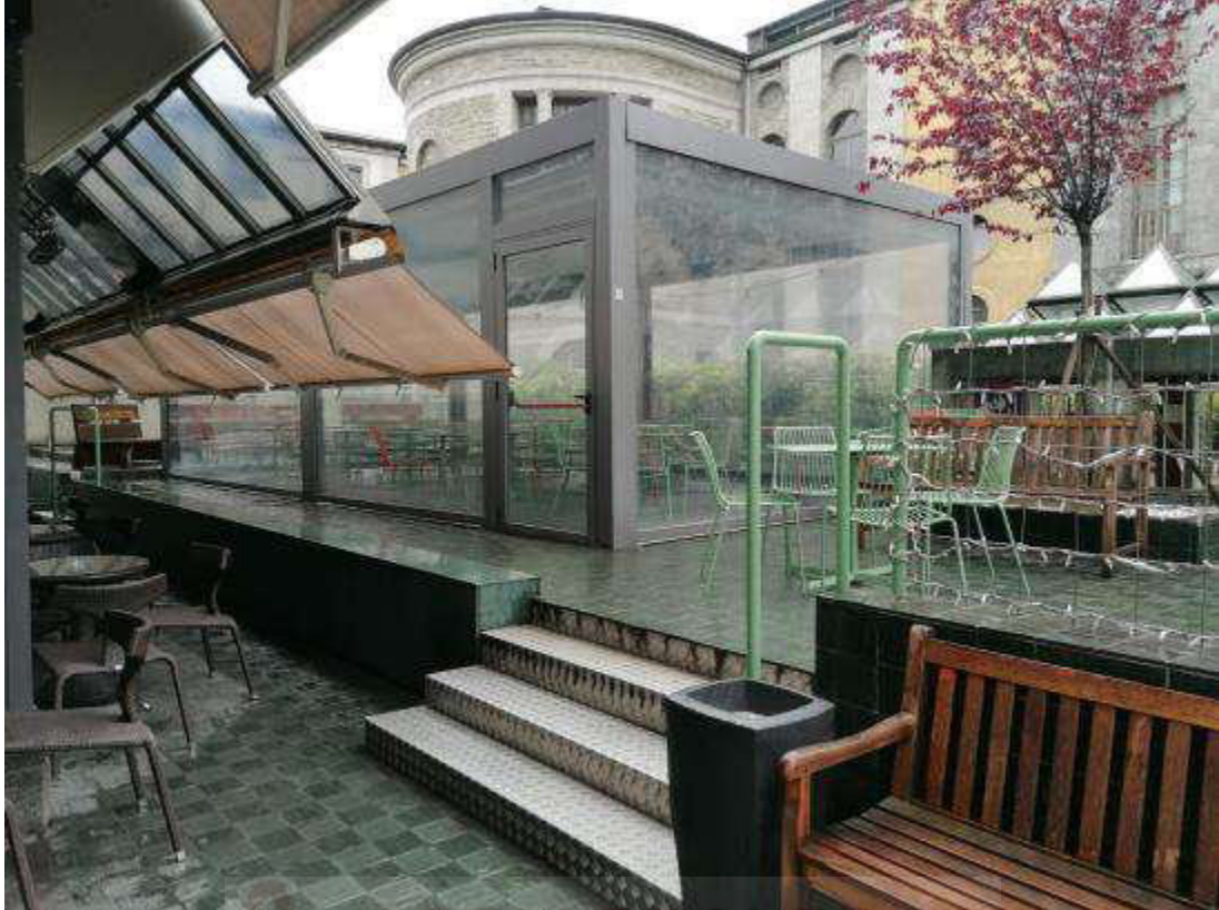
FOTO 21 – lastrico solare oggetto di locazione (dehor di proprietà della soc. locataria)
