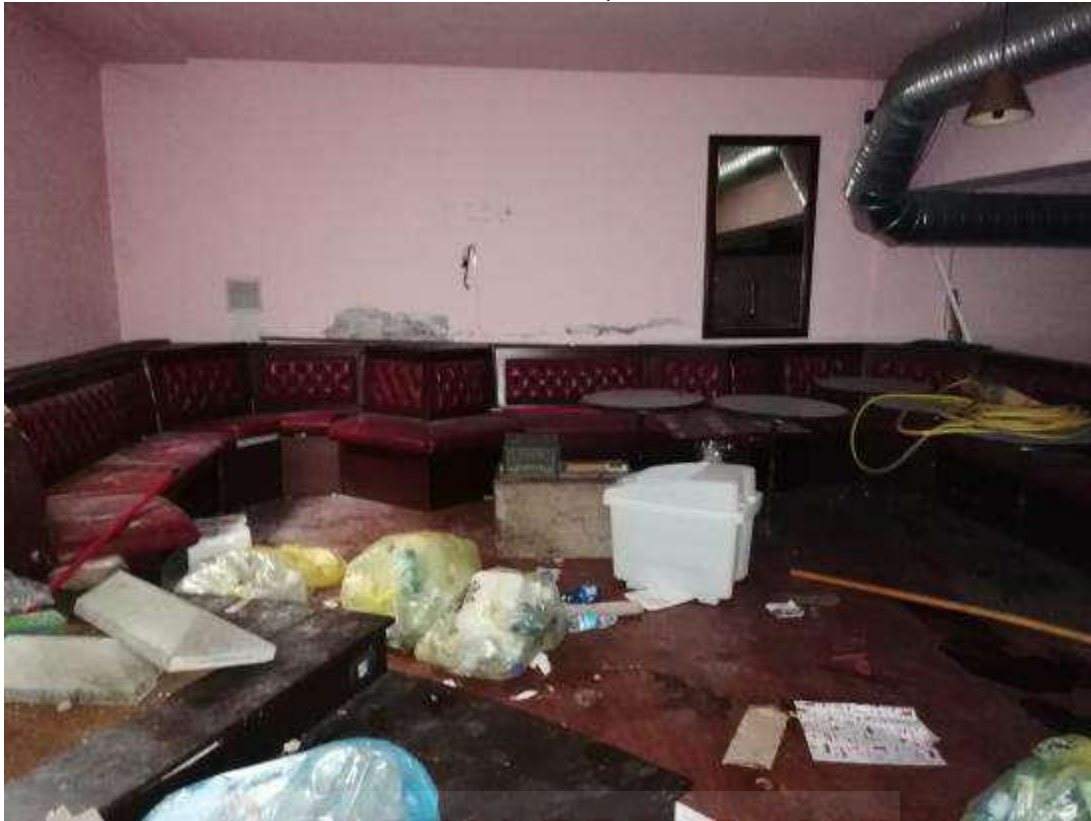
FOTO 23 – vista interna piano interrato
