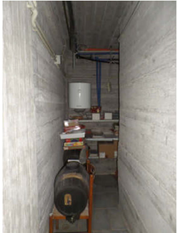
Foto n° 1.14. P. SI. Cavedio lato Est
