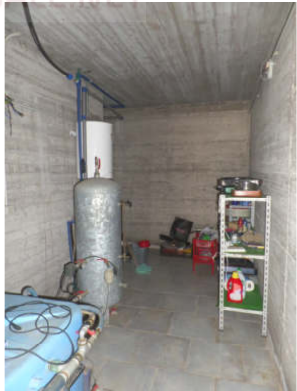
Foto n° 1.12. P. SI. Cavedio lato Sud
