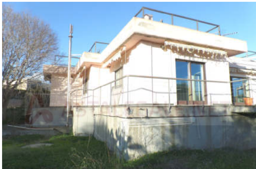
Foto n° 05. Villino: vista Sud-Ovest
