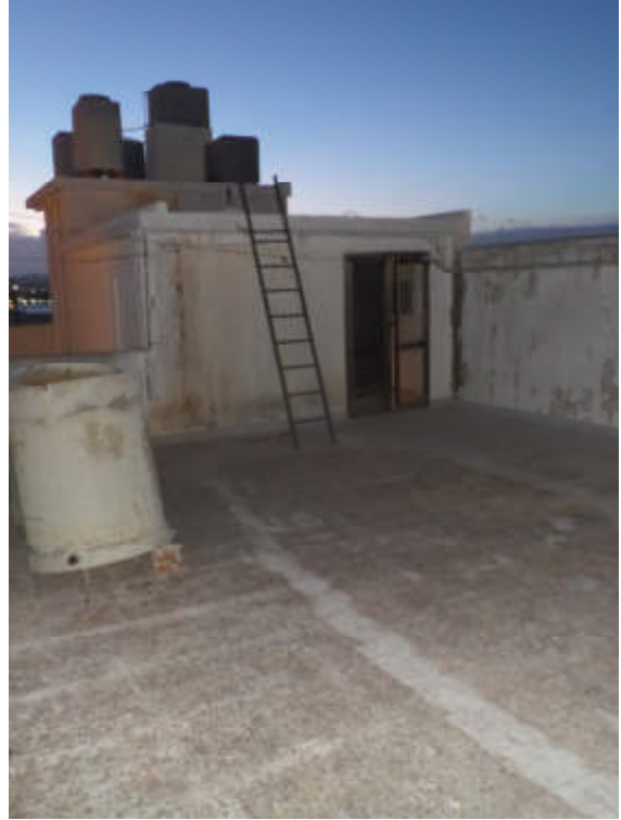
Foto n° 8.10. P. 6°: Terrazza anteriore
