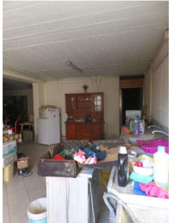
Foto n° 1.10. P. SI.: Cavedio lato Sud-Est
