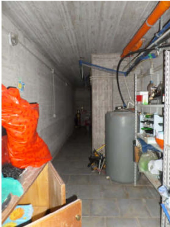
Foto n° 1.13. P. SI. Cavedio lato Est
