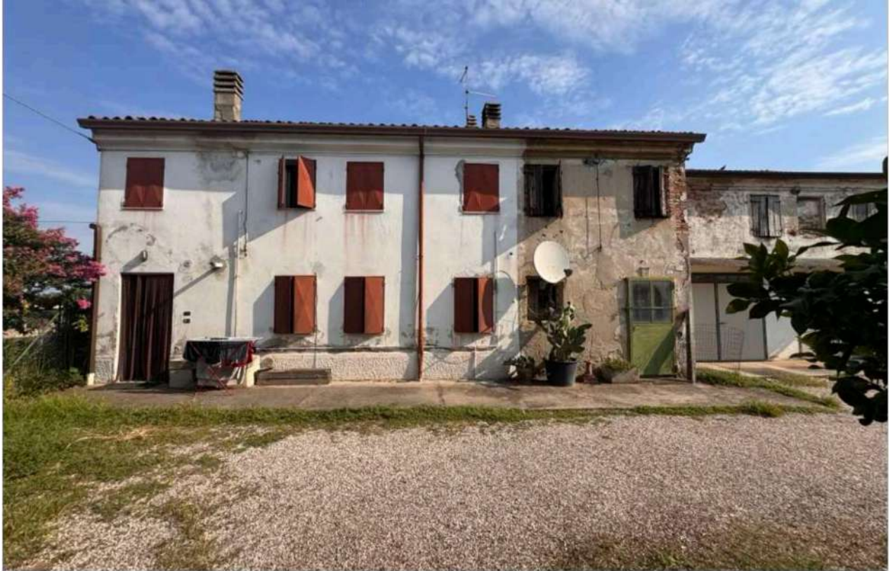
FOTO 3 - Fronte sud corpo abitazione
