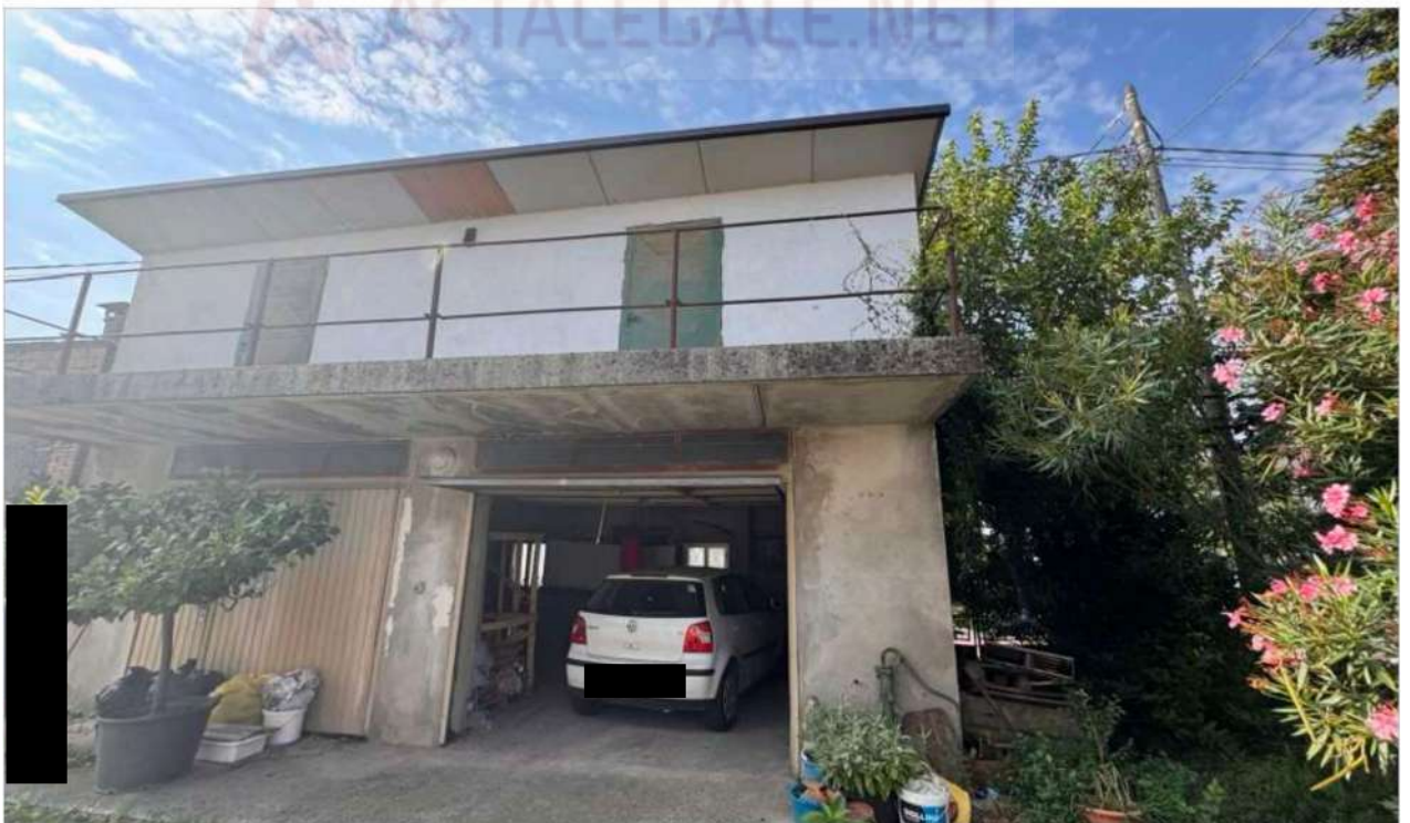
FOTO 4 - Fronte nord corpo autorimessa
