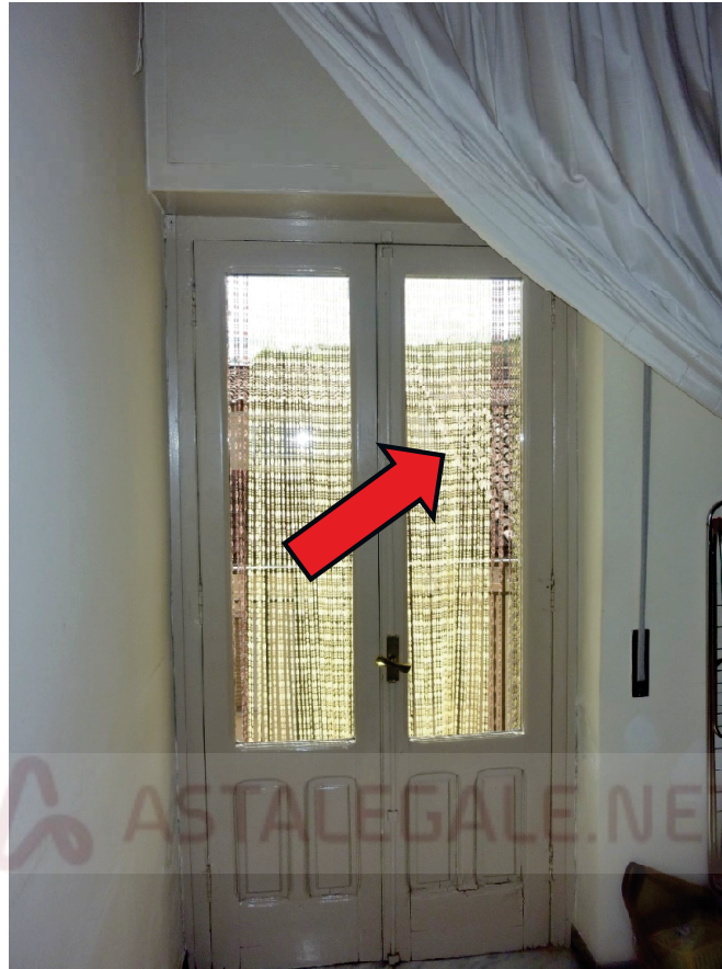
Foto N. 05 < Stanza da letto, con ingresso posizionato sulla sinistra del pianerottolo di riposo della rampa scale – Prospetta con balcone su Via Cavallerizza - Particolare infisso in legno - Alleg. N. 03 >
