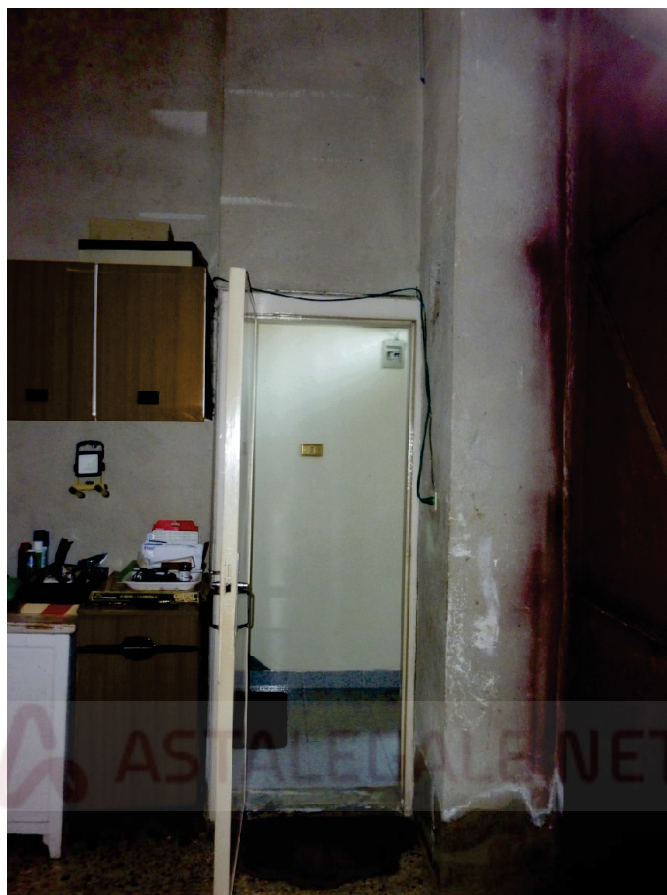
Foto N. 22 < Ingresso garage _deposito con accesso interno dal pianerottolo inizio/partenza rampa scala - Alleg. N. 03>
