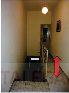
Foto N. 07 < Vano scala con pianerottolo di riposo - Sulla destra percorso di accesso al We dell' Unità abitativa - Alleg. N. 03 >
