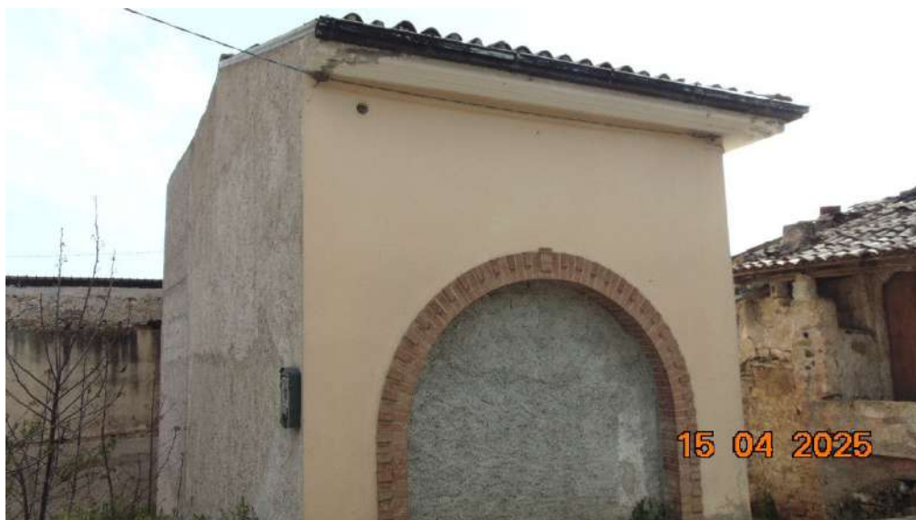
Prospetto su strada pubblica
