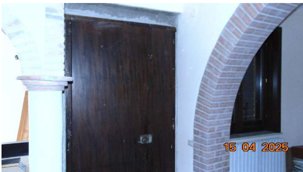
Portone ingresso Sogg./pranzo (vista interna)
