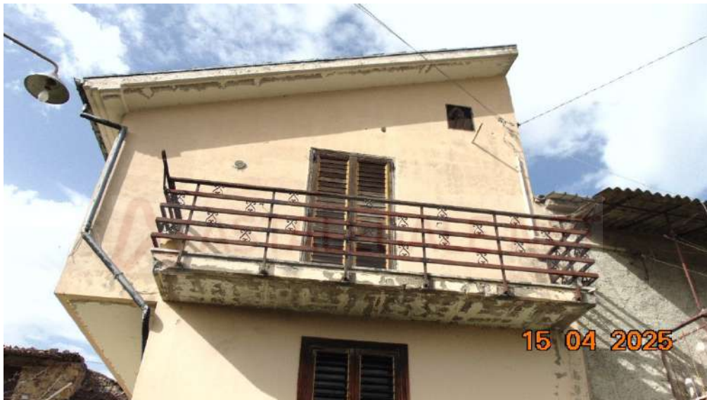
Particolare balcone e infisso esterno (soggiorno/pranzo)
