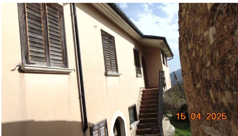
Scala esterna e portone di accesso al soggiorno/pranzo
