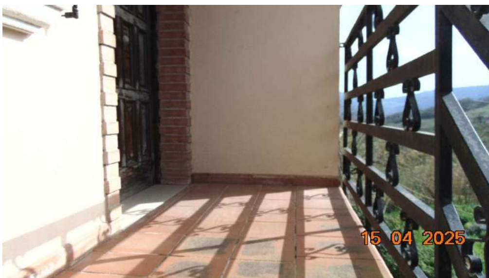
Particolare pavimento ballatoio ingresso (soggiorno/pranzo)
