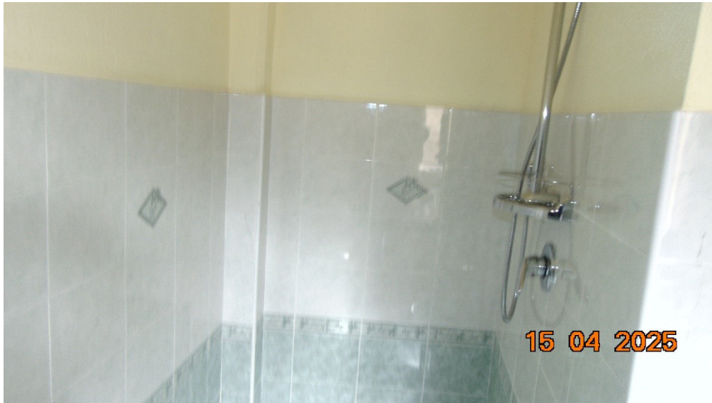
Bagno (Particolare doccia)
