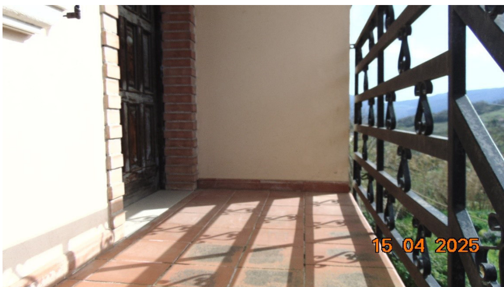
Particolare pavimento ballatoio ingresso (soggiorno/pranzo)
