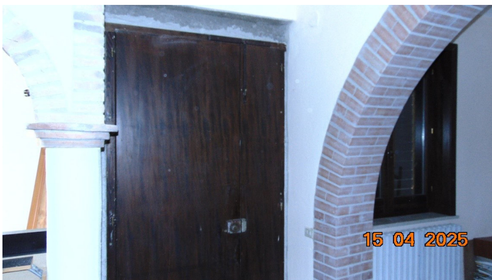
Portone ingresso Sogg./pranzo (vista interna)
