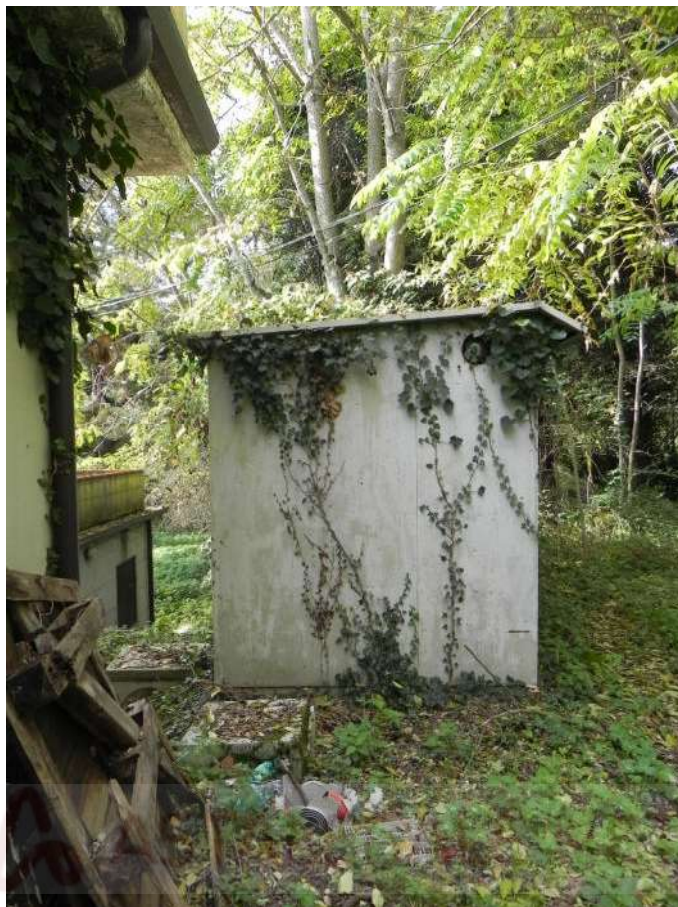
container con alloggiato all'interno un gruppo elettrogeno in disuso
