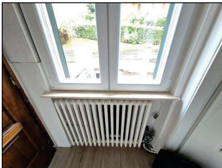
FOTO 12 U.I. MAPP. 4384 SUB. 502 VISTA PARTICOLARE RIPRESA VERSO FINESTRA DEL DISIMPEGNO.
