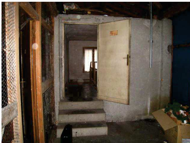
FOTO 37 U.I. MAPP. 4384 SUB. 502 VISTA PORZIONE COMUNE DEL SOTTOTETTO VERSO IL VANO SCALA COMUNE.
