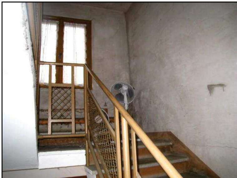
FOTO 31 ALTRA VISTA VANO SCALA COMUNE DI COLLEGAMENTO CON IL SOTTOTETTO.
