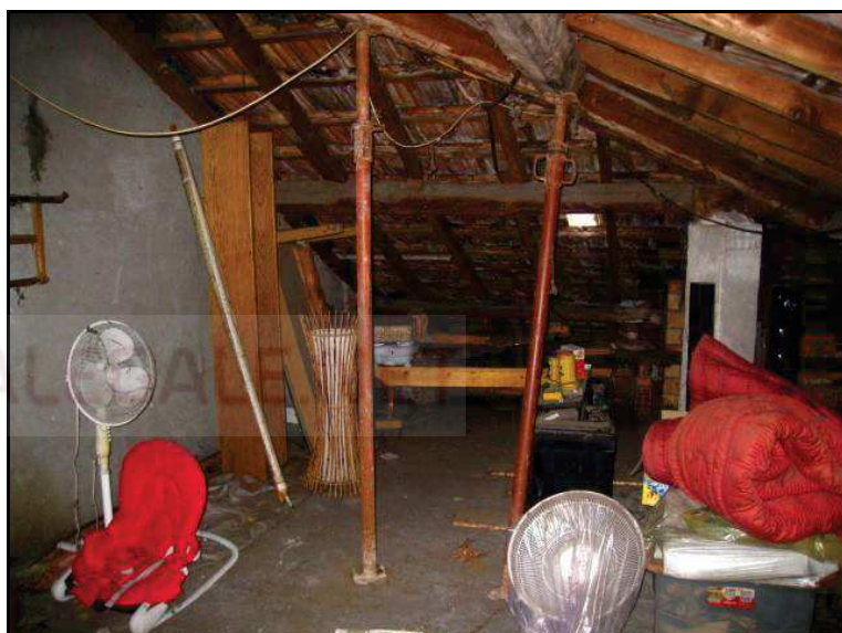
FOTO 35 U.I. MAPP. 4384 SUB. 502 ALTRA VISTA RIPRESA NEL SOTTOTETTO DELLA FOTO PRECEDENTE.
