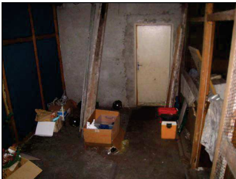
FOTO 33 VISTA PORZIONE COMUNE DEL SOTTOTETTO ENTRANDO.
