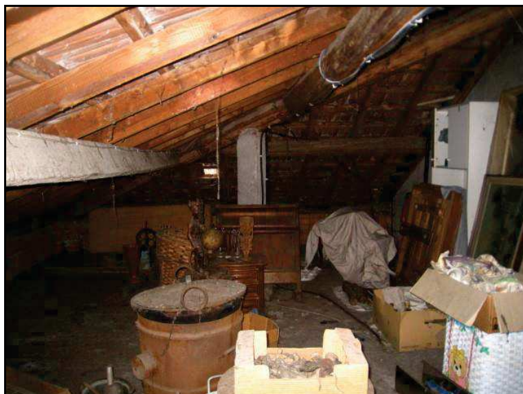
FOTO 34 U.I. MAPP. 4384 SUB. 502 VISTA RIPRESA NEL SOTTOTETTO DI PERTINENZA DELL'U.I. OGGETTO DI PROCEDURA.
