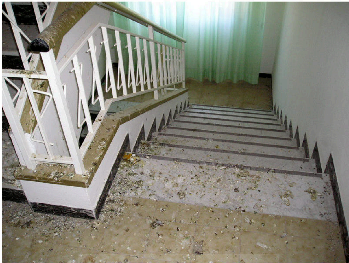
FOTOGRAFIA 55 - Piano Secondo / Vano Scala
