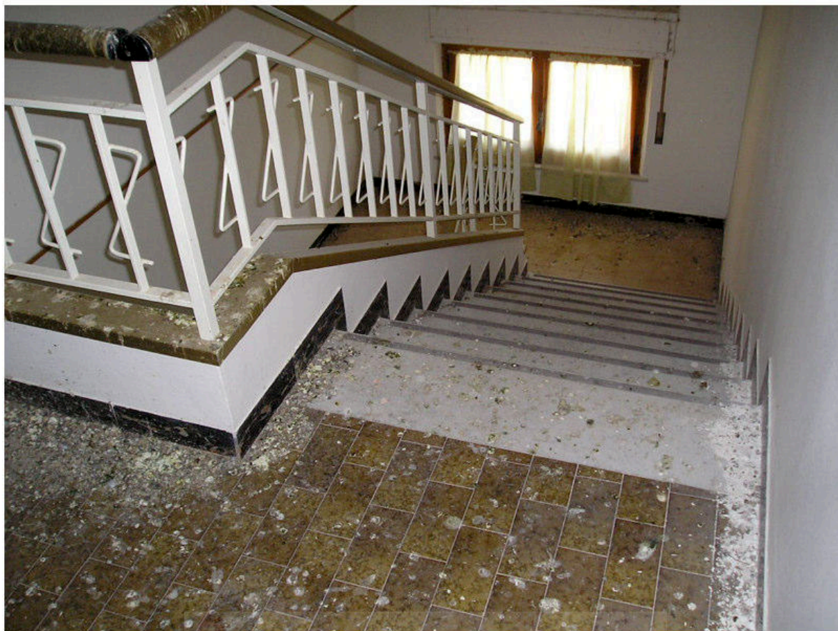
FOTOGRAFIA 59 - Piano Terzo / Vano Scala
