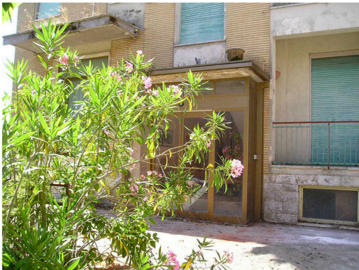
FOTOGRAFIA 02 - Esterno Fronte Ingresso
