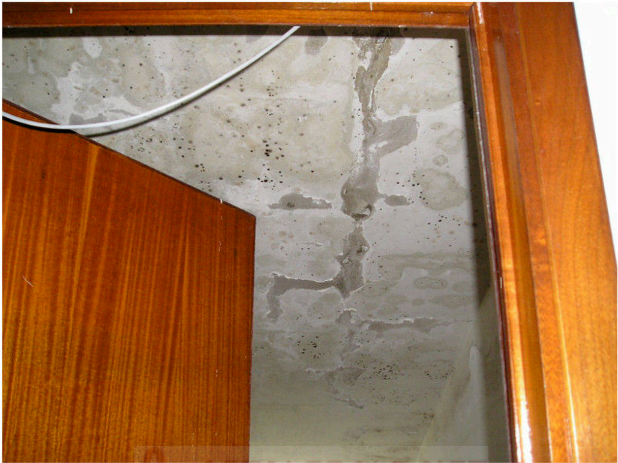
FOTOGRAFIA 63 - Piano Terzo / Solaio Copertura
