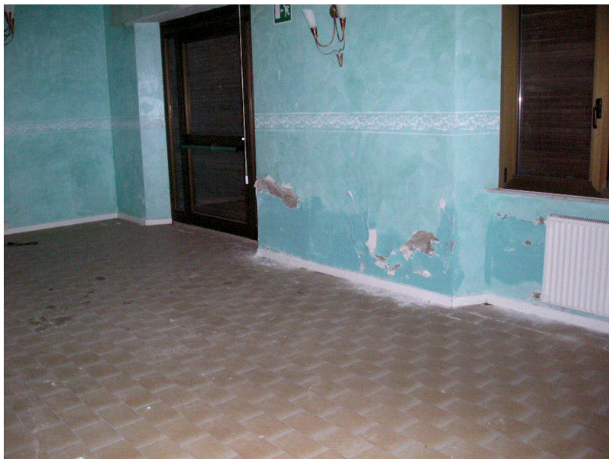
FOTOGRAFIA 32 - Piano Seminterrato / Sala da Pranzo
