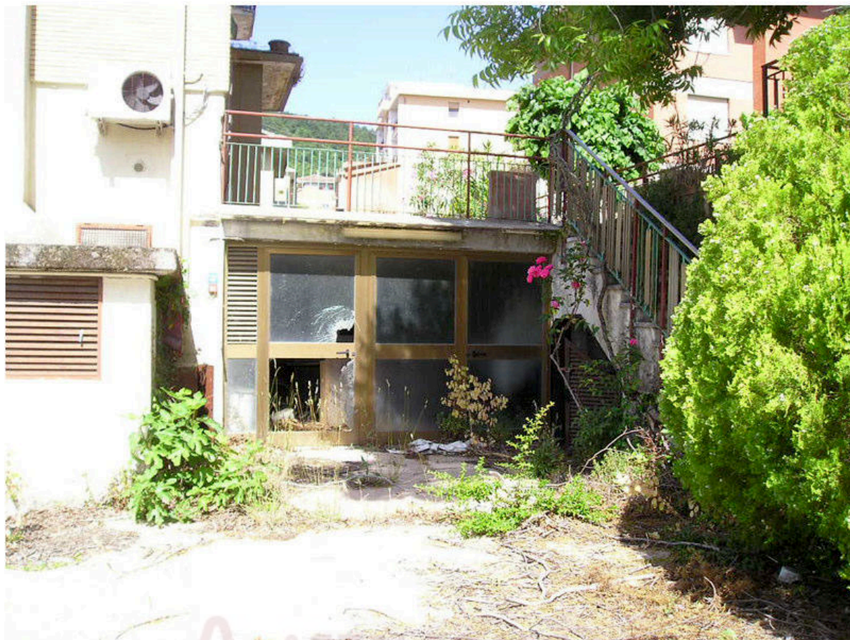
FOTOGRAFIA 07 - Esterno Edificio / Resede
