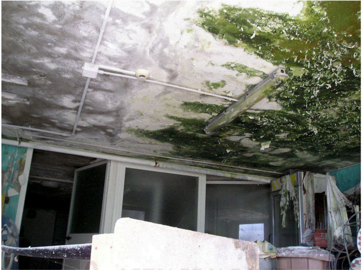
FOTOGRAFIA 41 - Piano Seminterrato / Servizi sottostanti Lastrico Ingresso
