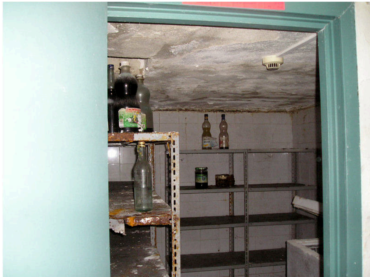
FOTOGRAFIA 44 - Piano Seminterrato / Servizi sottostanti Lastrico Ingresso
