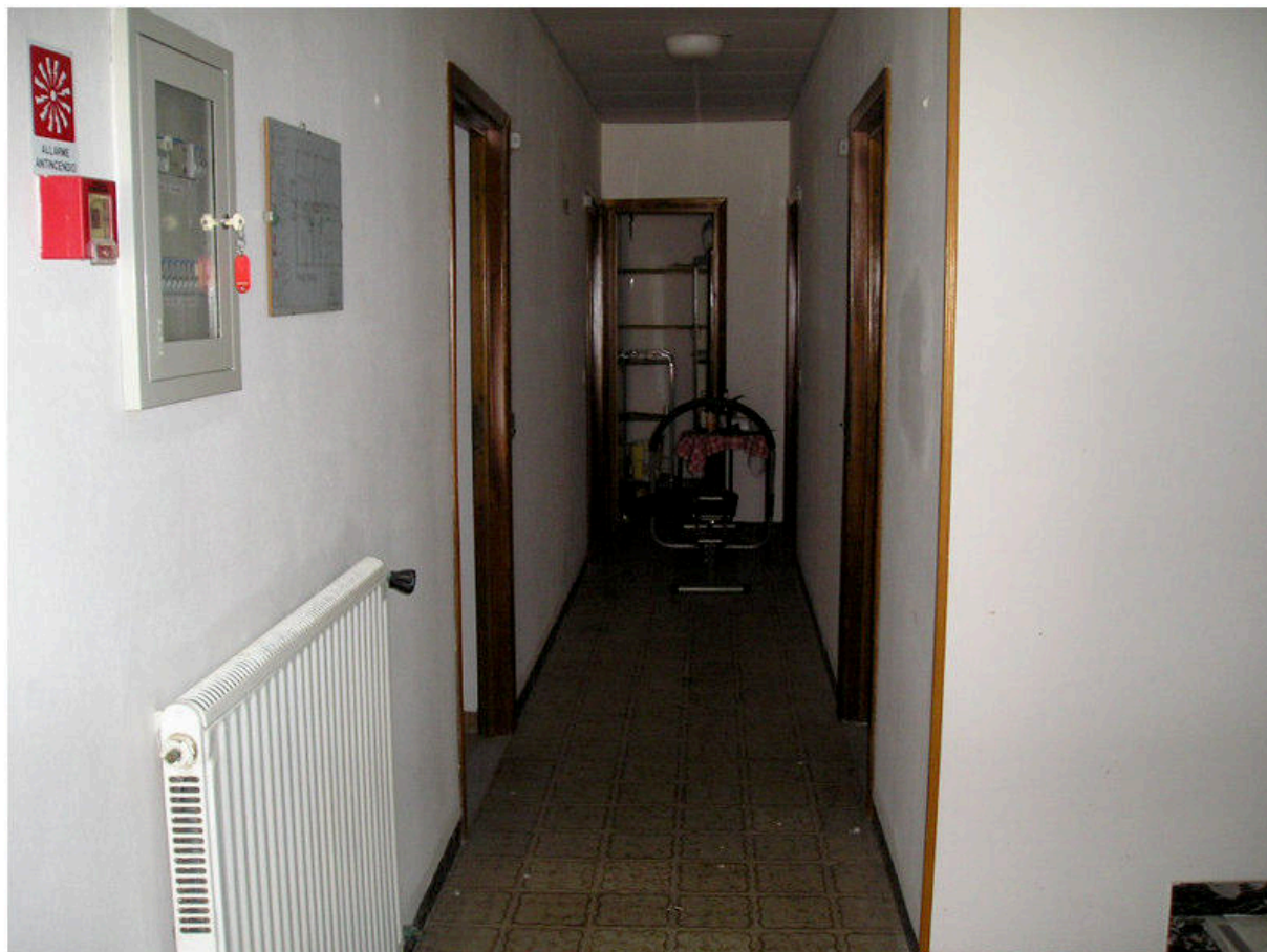
FOTOGRAFIA 52 - Piano Primo / Disimpegno
