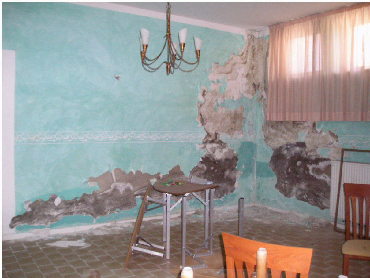
FOTOGRAFIA 31 - Piano Seminterrato / Sala da Pranzo
