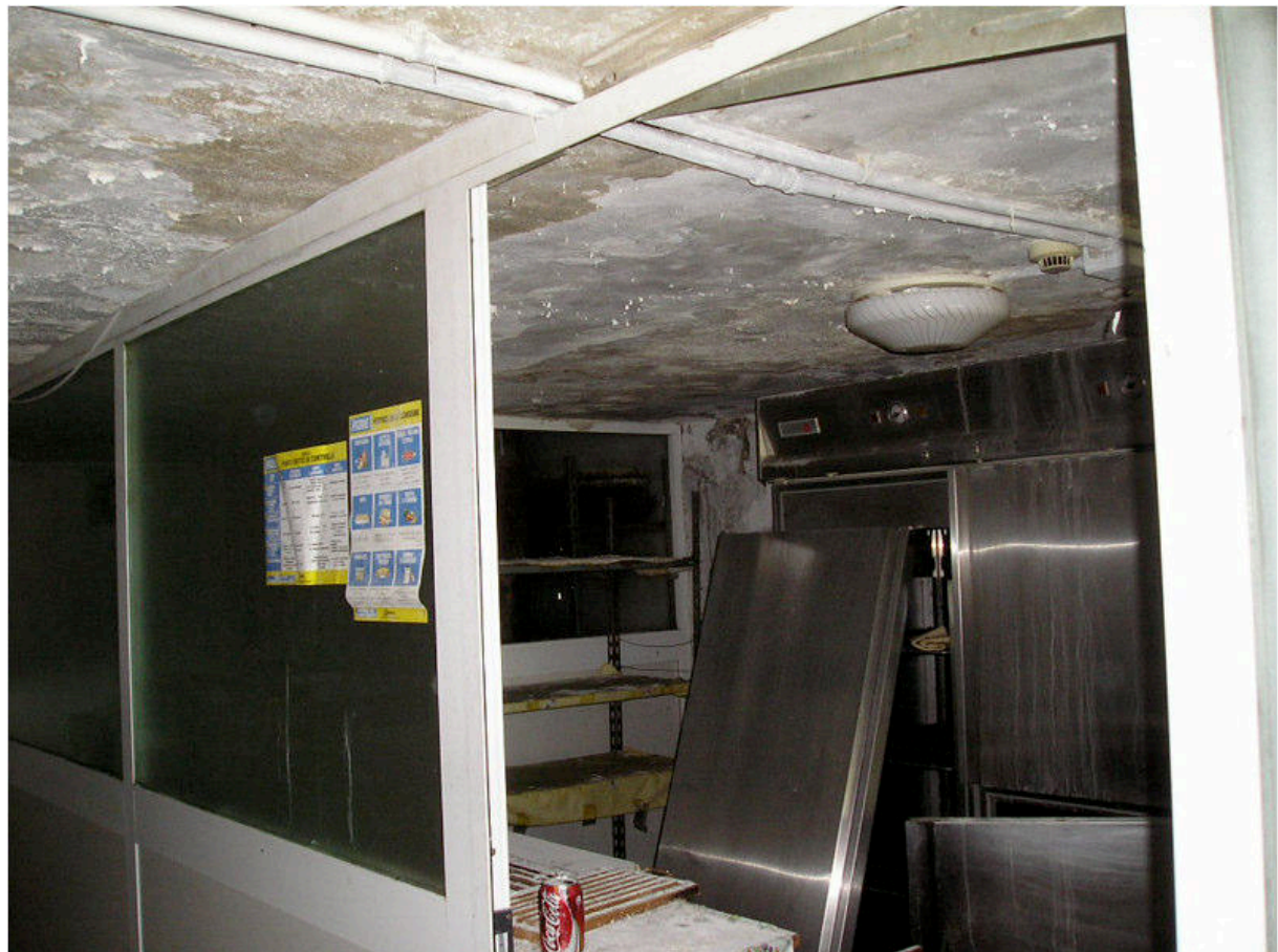
FOTOGRAFIA 42 - Piano Seminterrato / Servizi sottostanti Lastrico Ingresso
