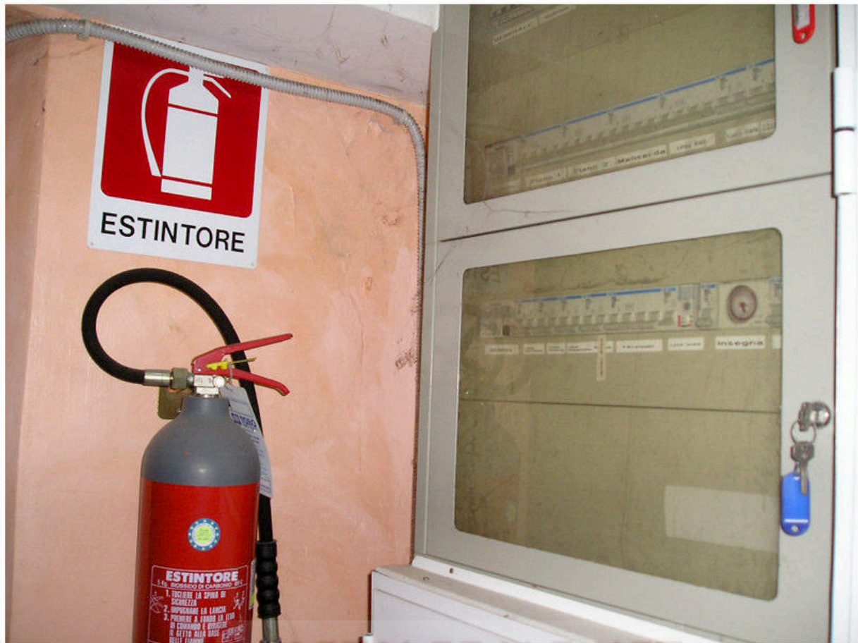
FOTOGRAFIA 37 - Piano Seminterrato / Area Quadri
