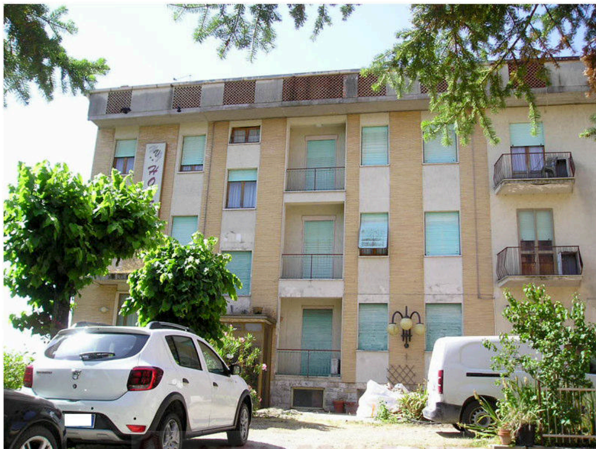
FOTOGRAFIA 01 - Esterno Fronte Edificio
