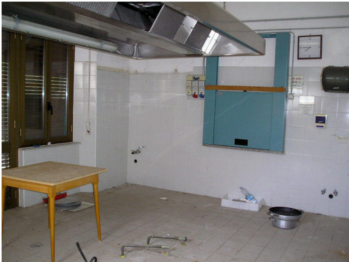
FOTOGRAFIA 34 - Piano Seminterrato / Cucina
