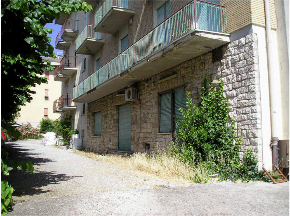
FOTOGRAFIA 09 - Esterno Edificio / Resede
