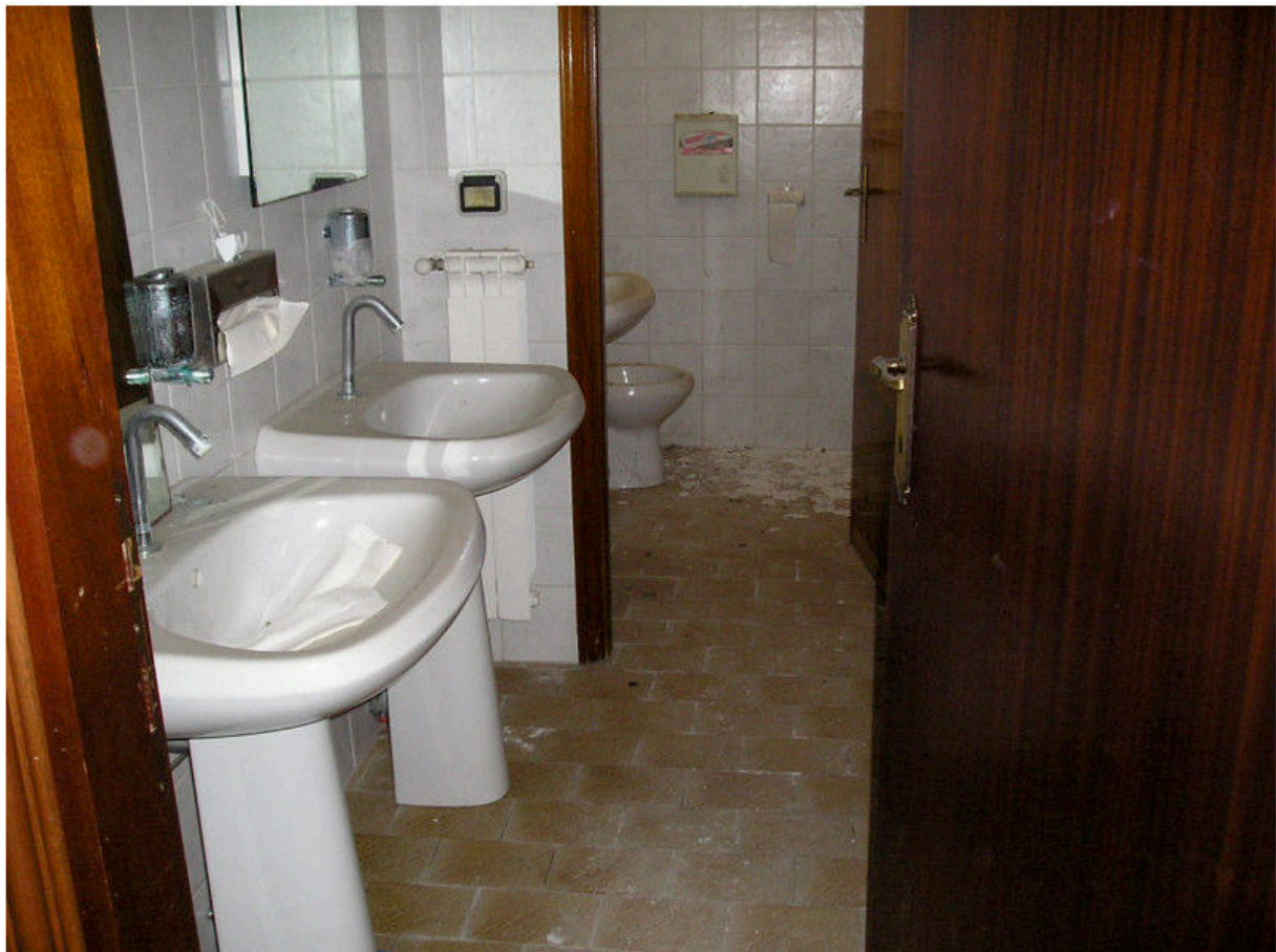
FOTOGRAFIA 36 - Piano Seminterrato / Servizio Igienico
