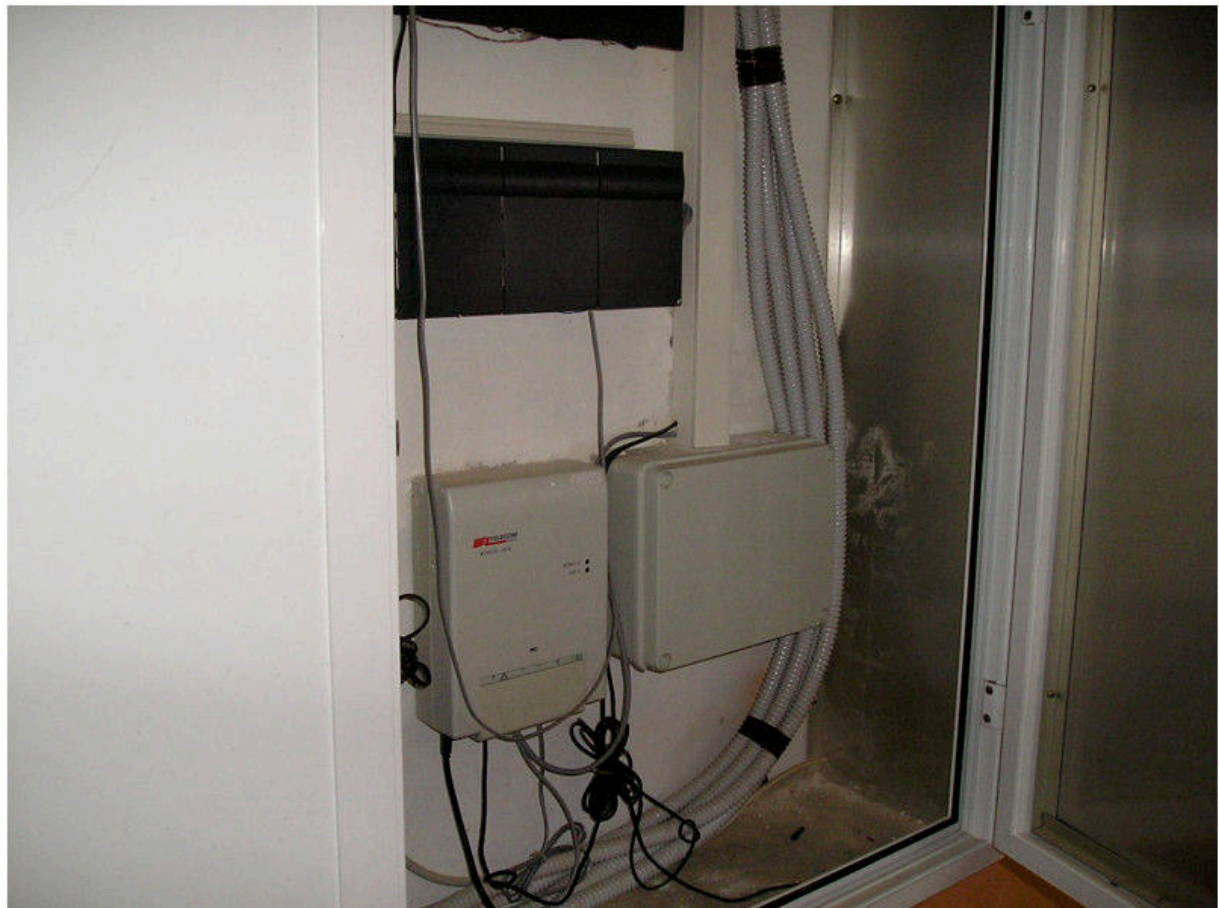
FOTOGRAFIA 38 - Piano Seminterrato / Area Quadri
