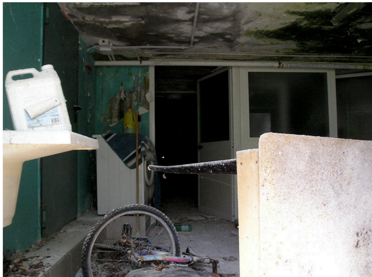
FOTOGRAFIA 40 - Piano Seminterrato / Servizi sottostanti Lastrico Ingresso
