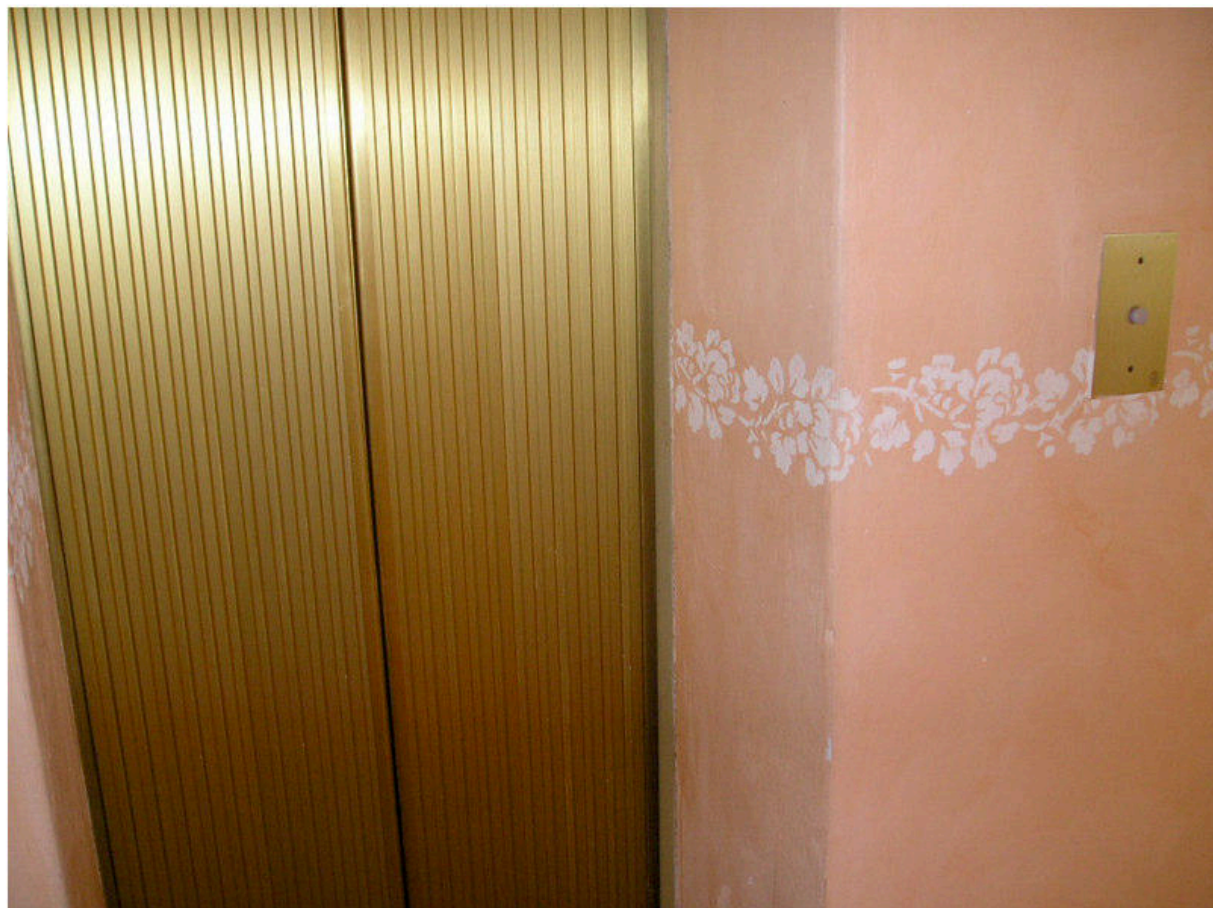
FOTOGRAFIA 26 - Piano Terreno / Arrivo Ascensore
