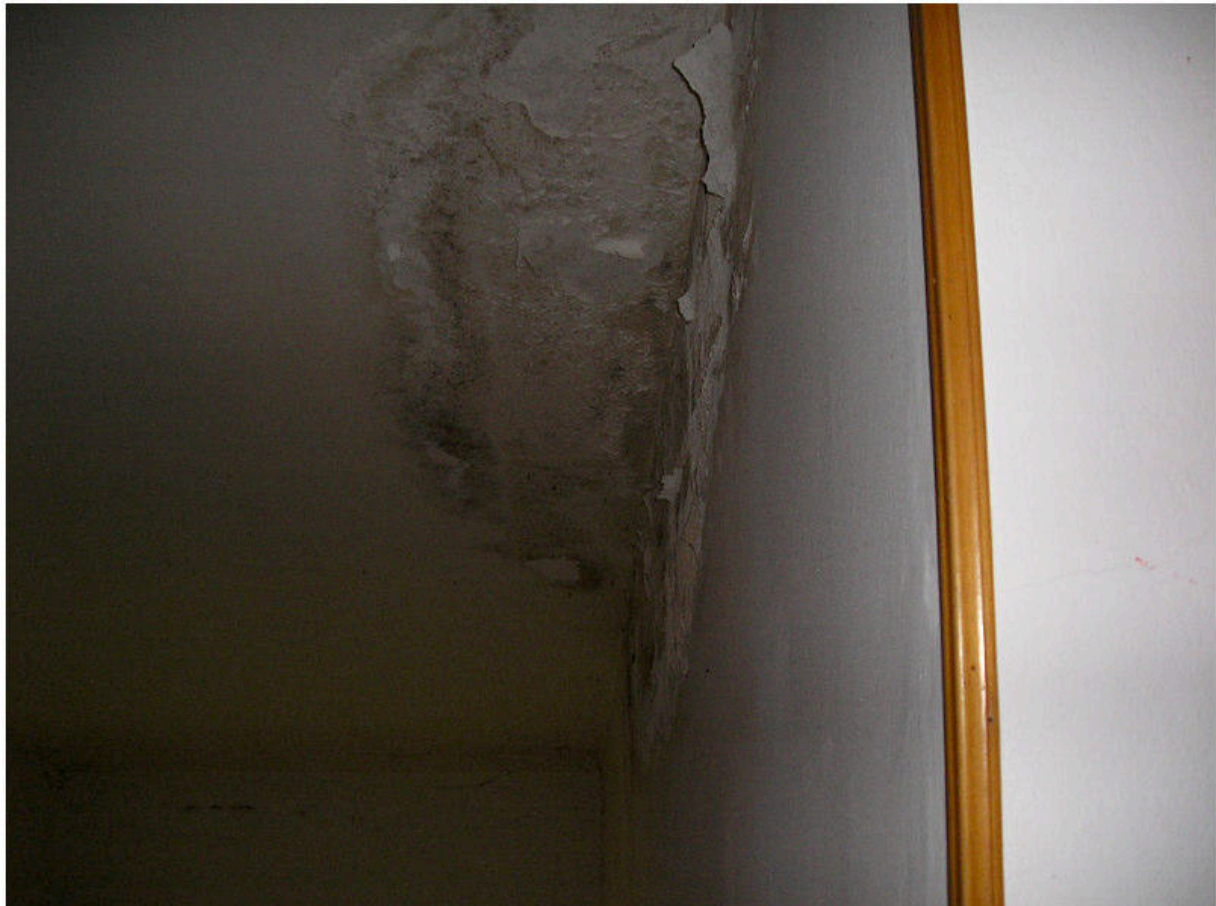
FOTOGRAFIA 64 - Piano Terzo / Solaio Copertura
