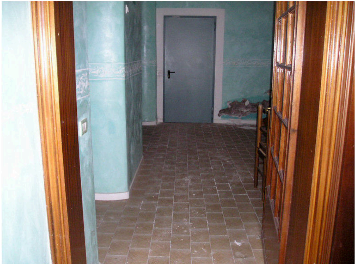
FOTOGRAFIA 30 - Piano Seminterrato / Ingresso Sala Pranzo - Porta REI
