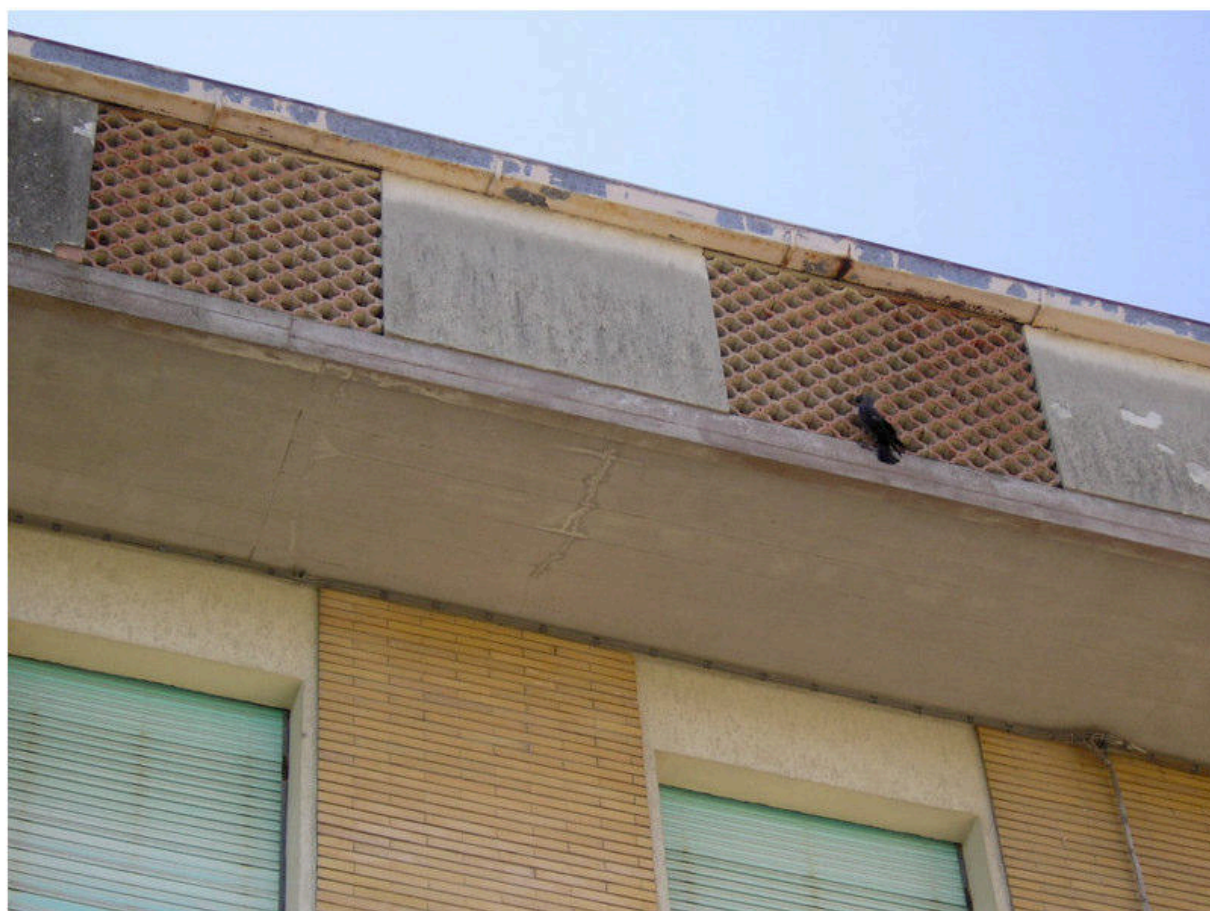
FOTOGRAFIA 08 - Esterno Edificio / Gronda
