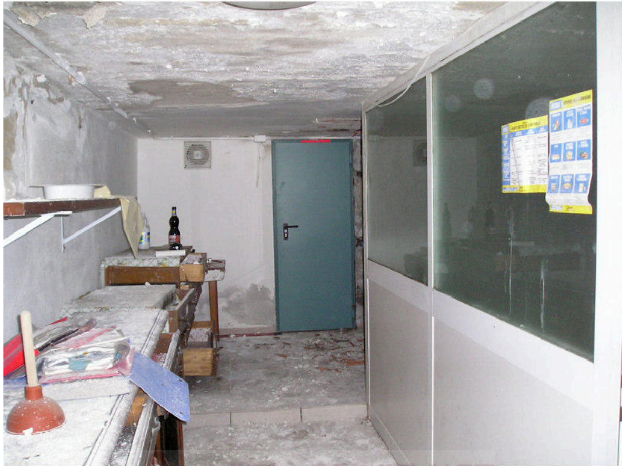
FOTOGRAFIA 43 - Piano Seminterrato / Servizi sottostanti Lastrico Ingresso
