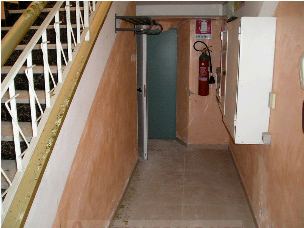
FOTOGRAFIA 35 - Piano Seminterrato / Vano Scala
