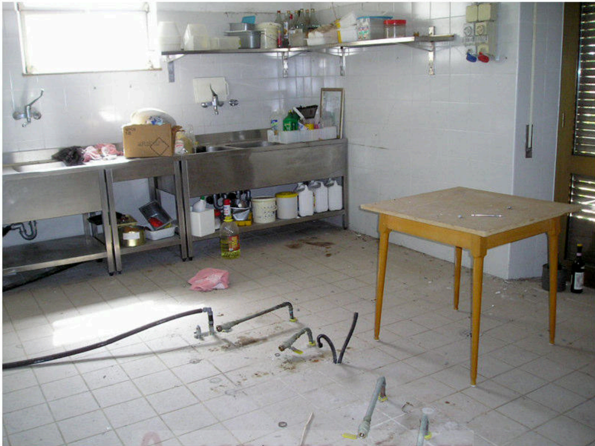
FOTOGRAFIA 33 - Piano Seminterrato / Cucina
