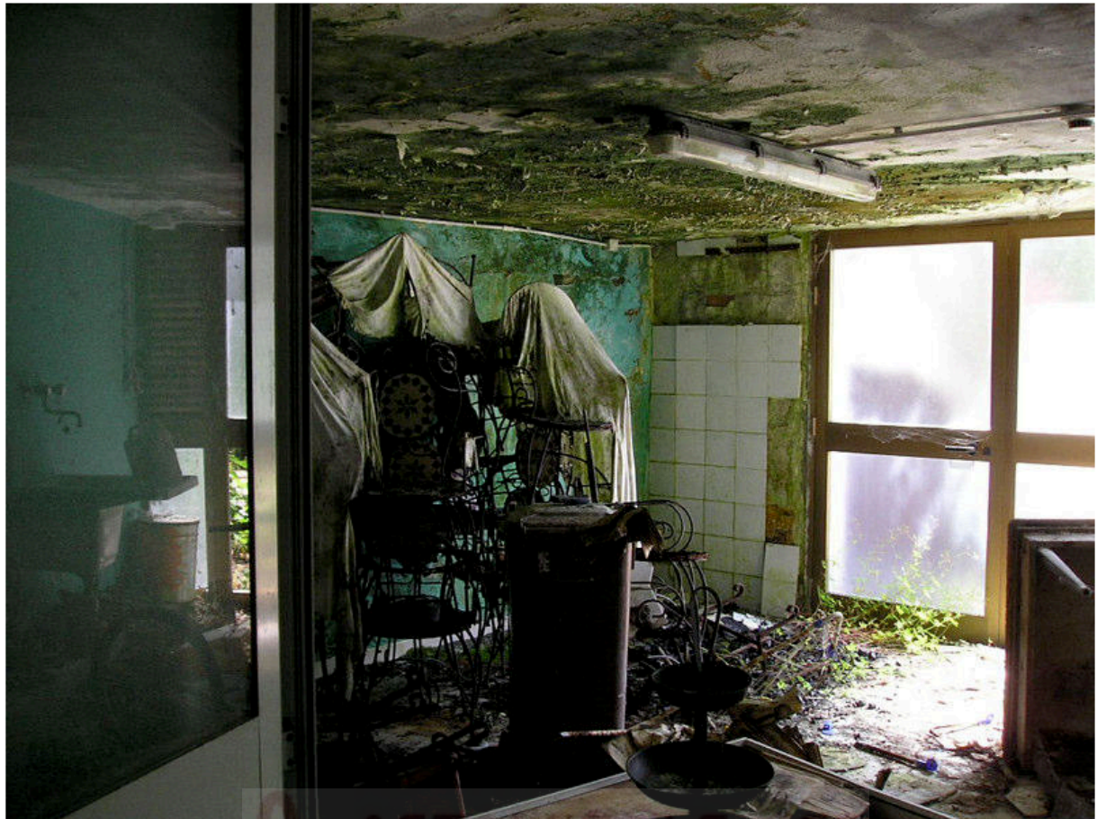
FOTOGRAFIA 39 - Piano Seminterrato / Servizi sottostanti Lastrico Ingresso
