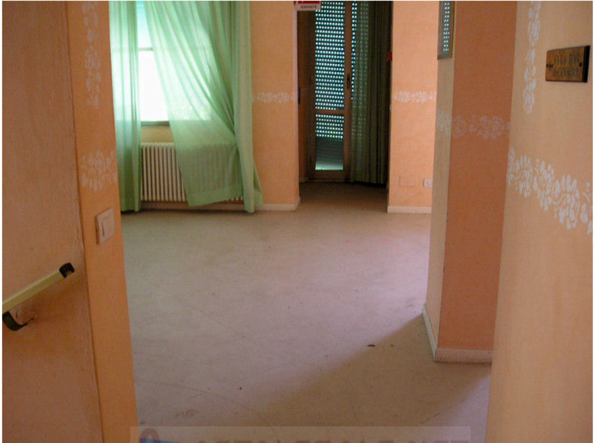
FOTOGRAFIA 23 - Piano Terreno / Soggiorno
