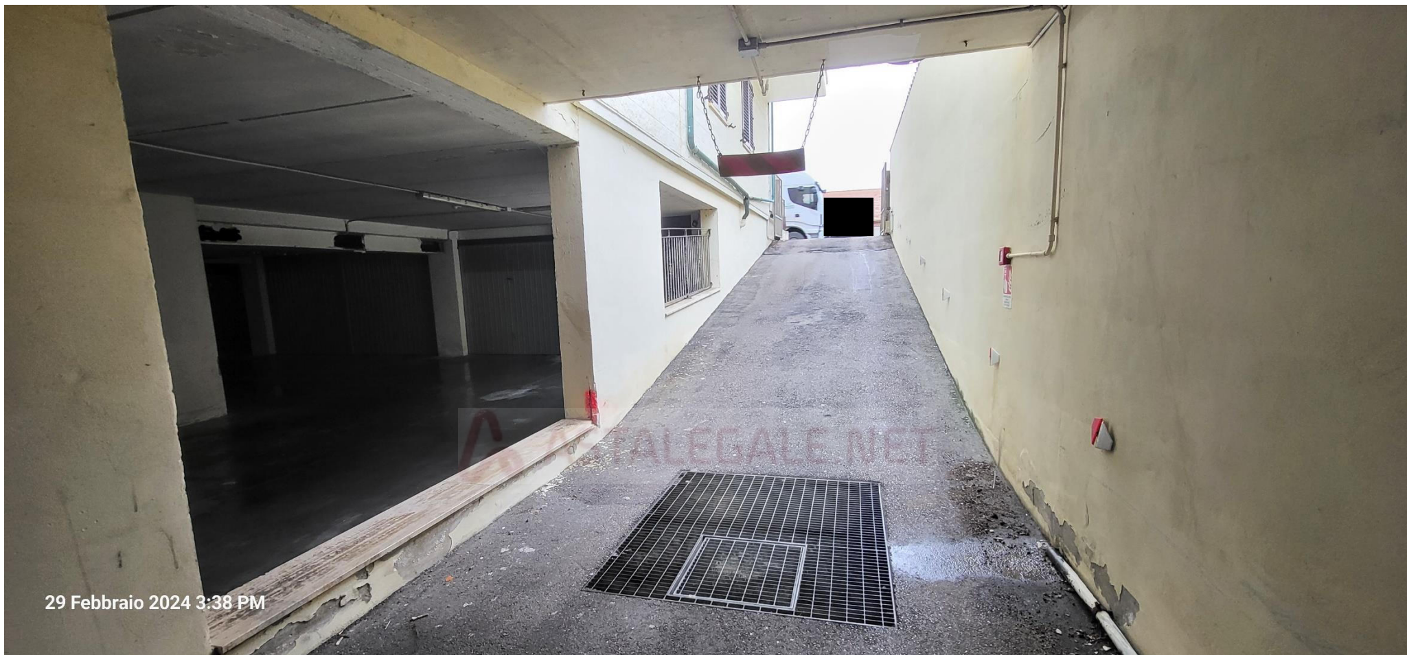
Foto n. 2 Vista della rampa di accesso al piano interrato dove è posto il garage
