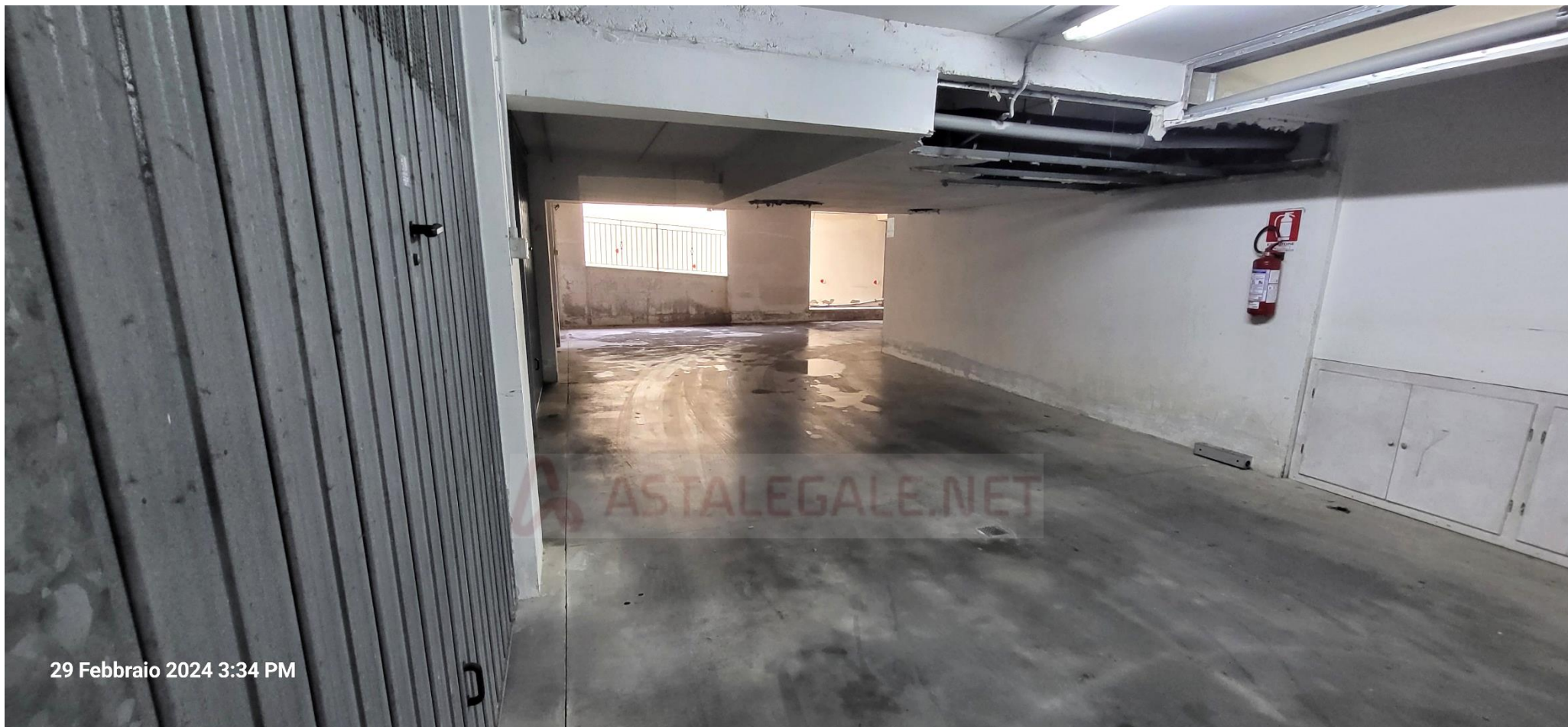
Foto n. 3 Parte iniziale della corsia di manovra e accesso al garage
