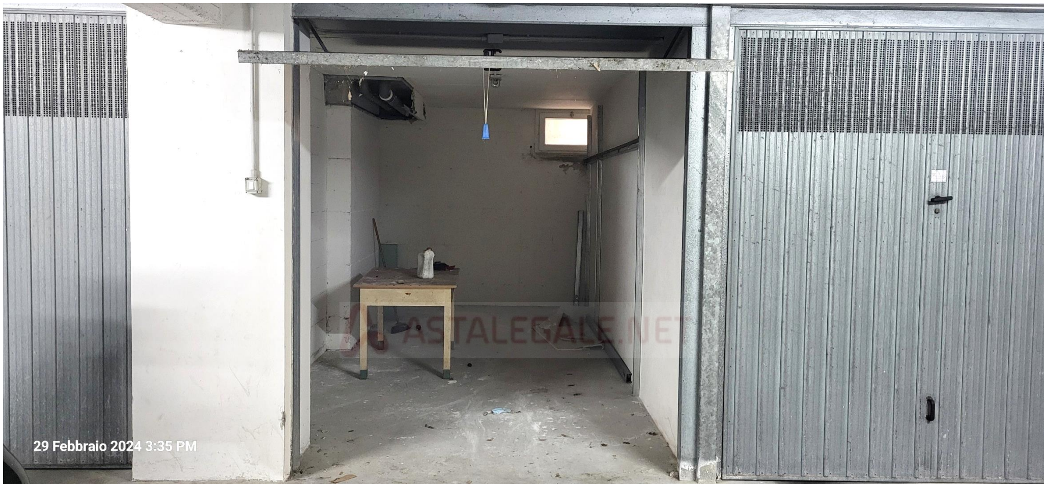
Foto n. 5 garage oggetto di espropriazione
