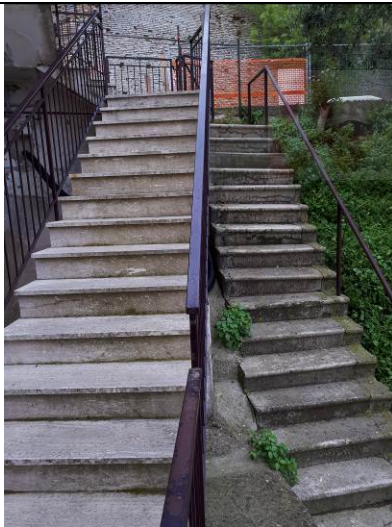
Scala di accesso
