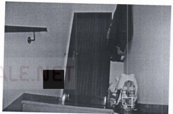
4- la porta di accesso al piano primo
