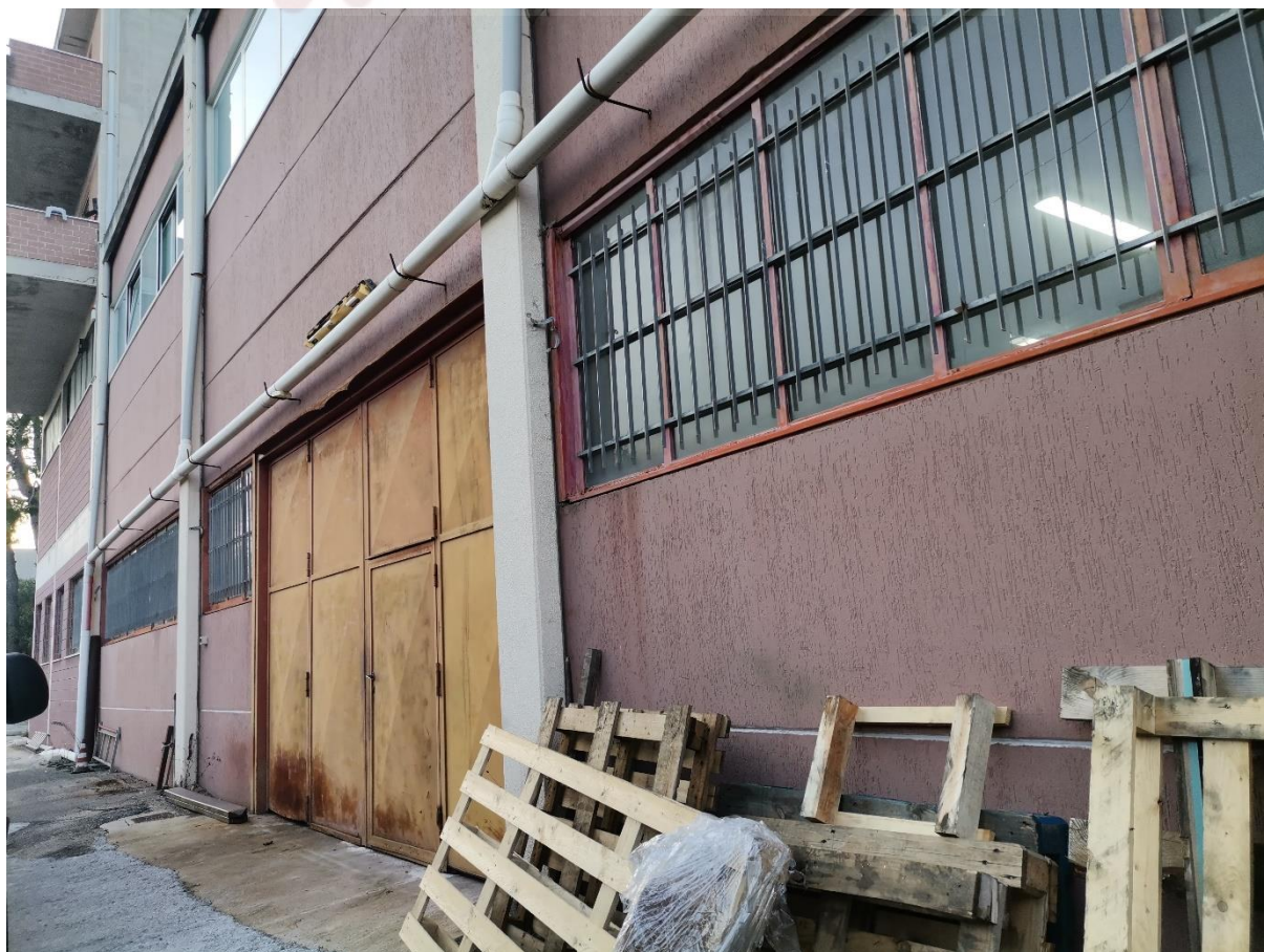
Foto n. 16: Prospetto est ed ingresso carrabile al laboratorio
