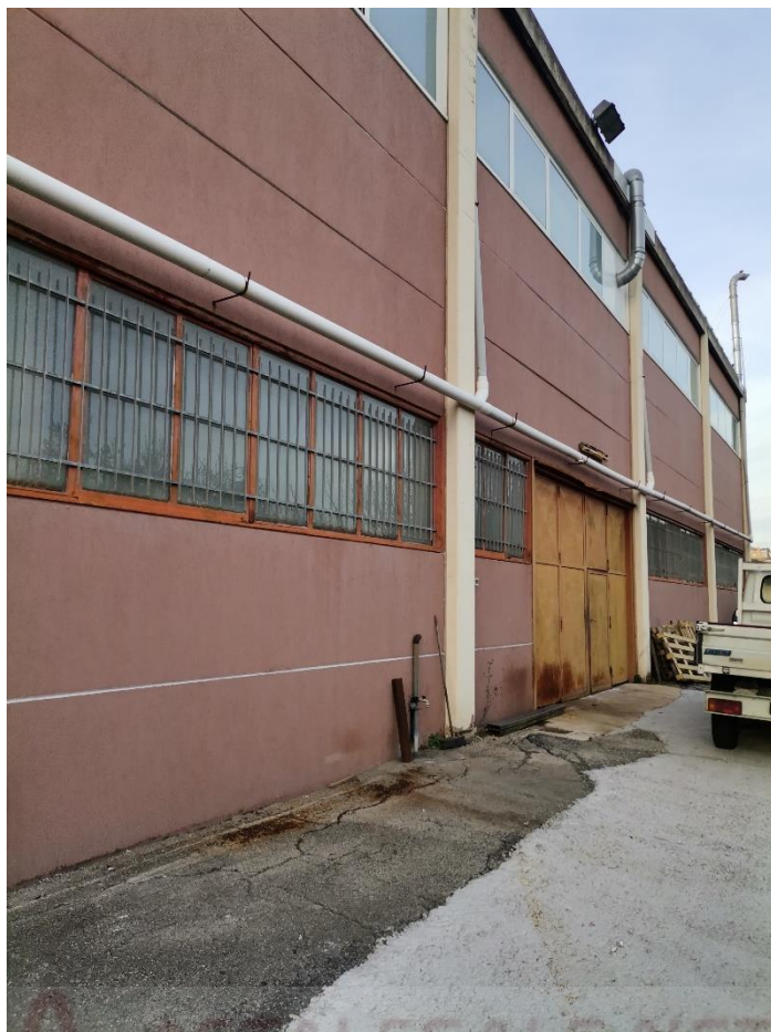
Foto n. 13: Prospetto est laboratorio con ingresso carrabile
