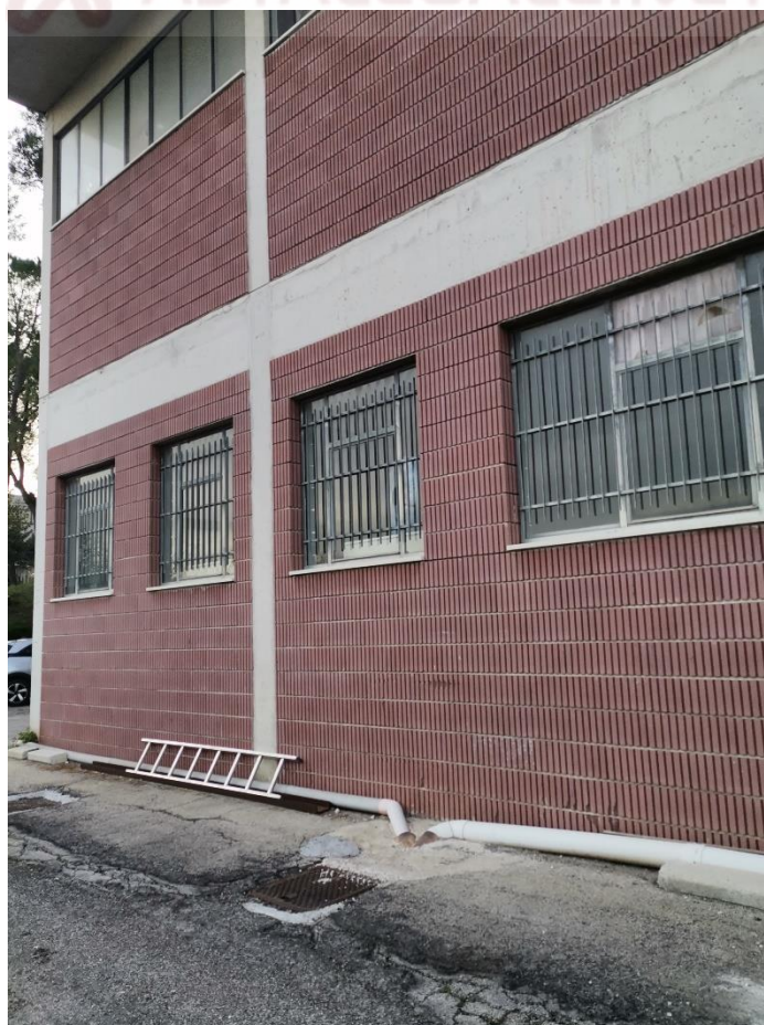
Foto n. 12: Prospetto est ufficio 1
