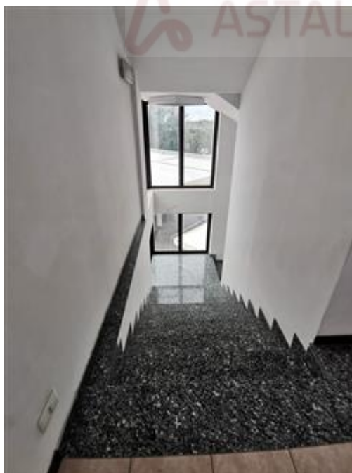
scala interna comune
