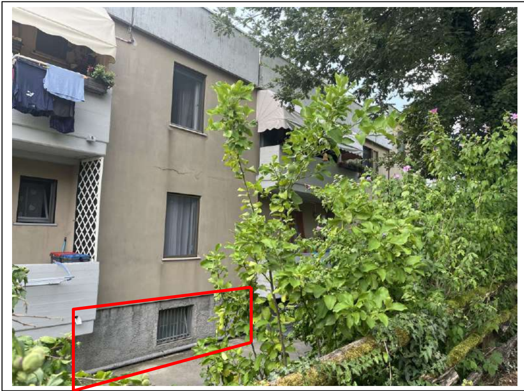
FOTO N. 3 – Vista retro (via delle Querce)
