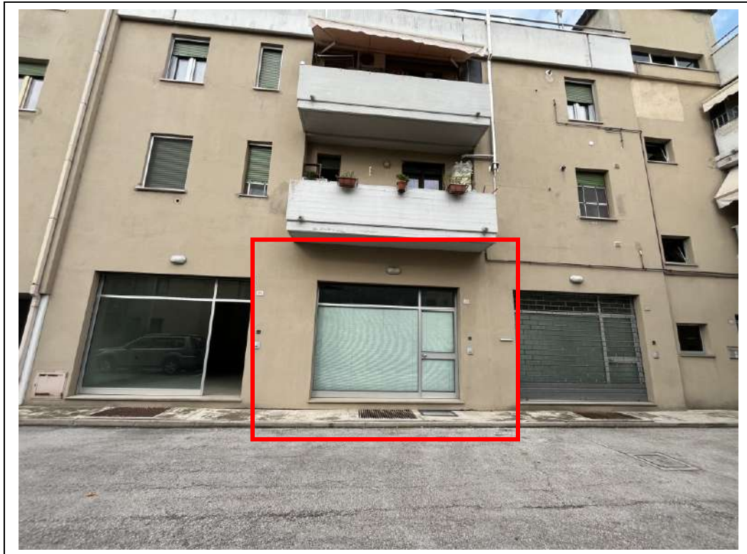
FOTO N. 1 – Vista fronte (via degli Olivi)
