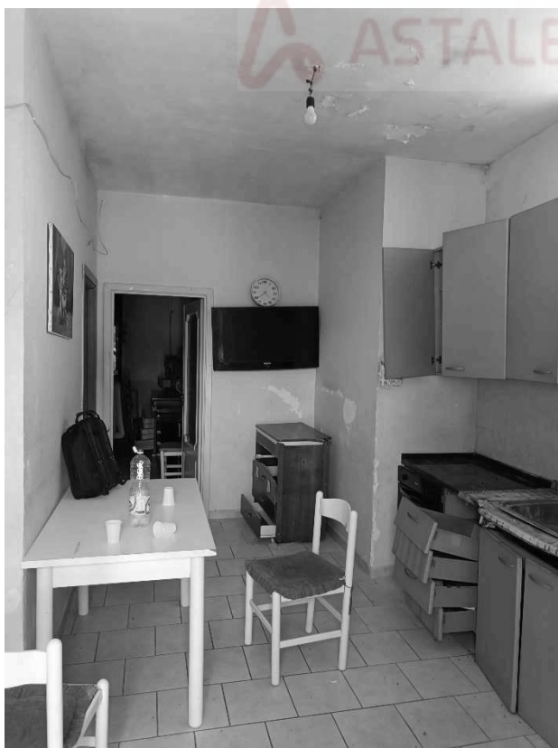
Foto 3. Foto 4. Zona ingresso cucina
