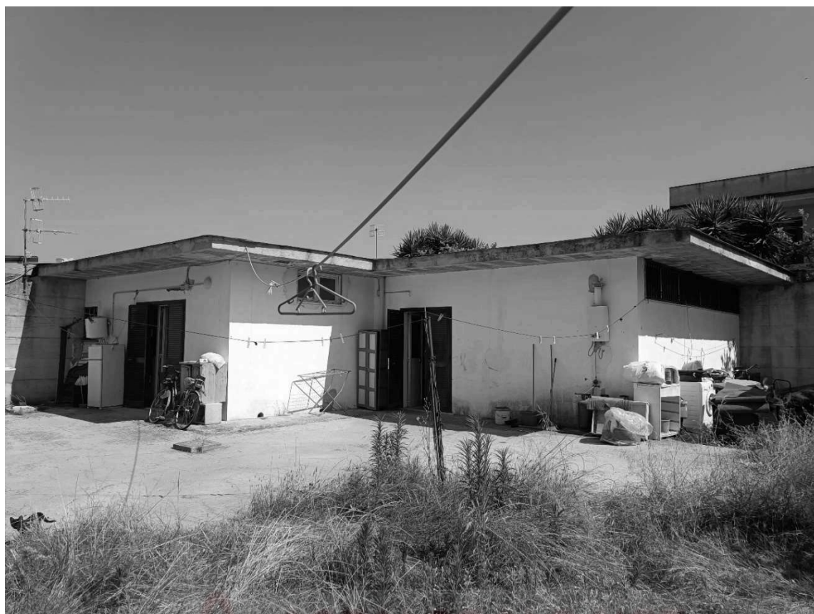
Foto 6 Esterno unità immobiliare
