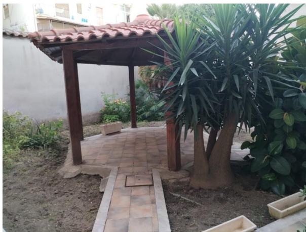
Foto n°4- Vista dell'area esterna
