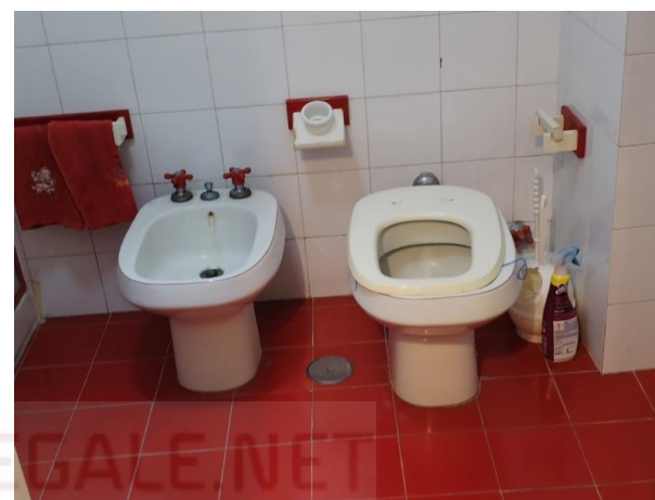
Foto n°6- Vista del bagno P.T.
