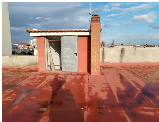
Foto n°16- Vista del terrazzo di copertura
