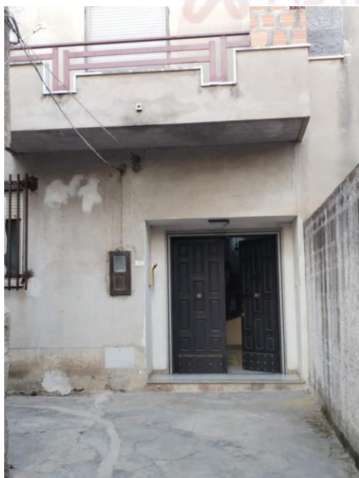
Foto n°1- Vista dell'ingresso pedonale del fabbricato
