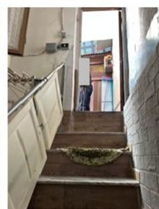
Foto n. 43 - Vano scala di accesso al terrazzo
