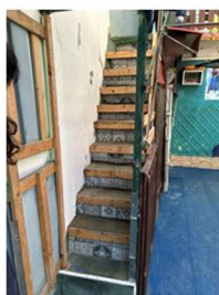
Foto n. 54 - Terrazzo esclusivo - scala di accesso al sottostante terrazzo di proprietà aliena
