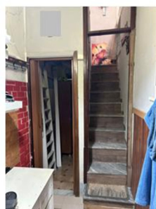
Foto n. 38 - Vano scala di accesso al terrazzo
