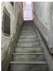
Foto n. 4 - Fabbricato - vano scala
