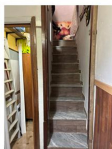
Foto n. 41 - Vano scala di accesso al terrazzo
