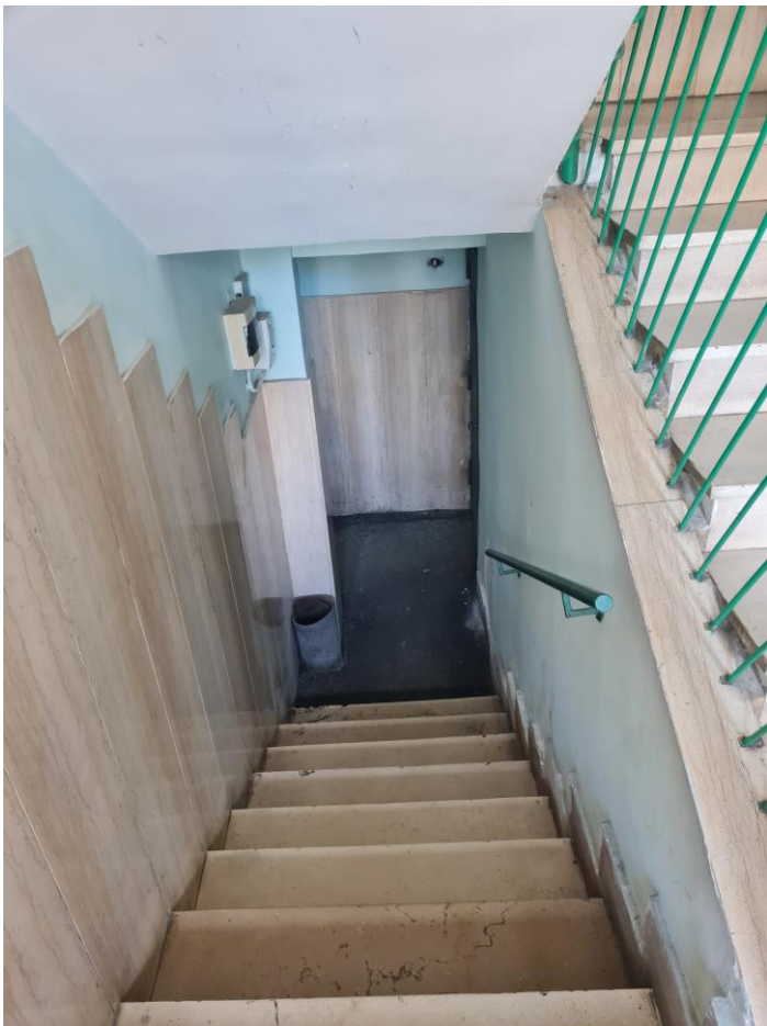
Accesso al piano seminterrato dalla scala del fabbricato
