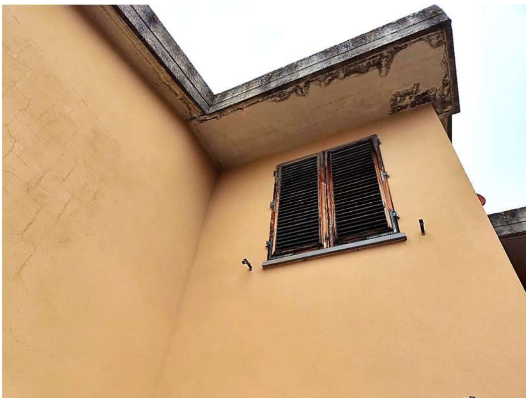
Foto 13 - Particolare facciata posteriore
