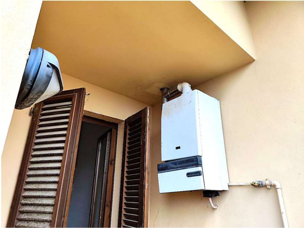
Foto 31 - La piccola loggia che precede la terrazza del primo piano
