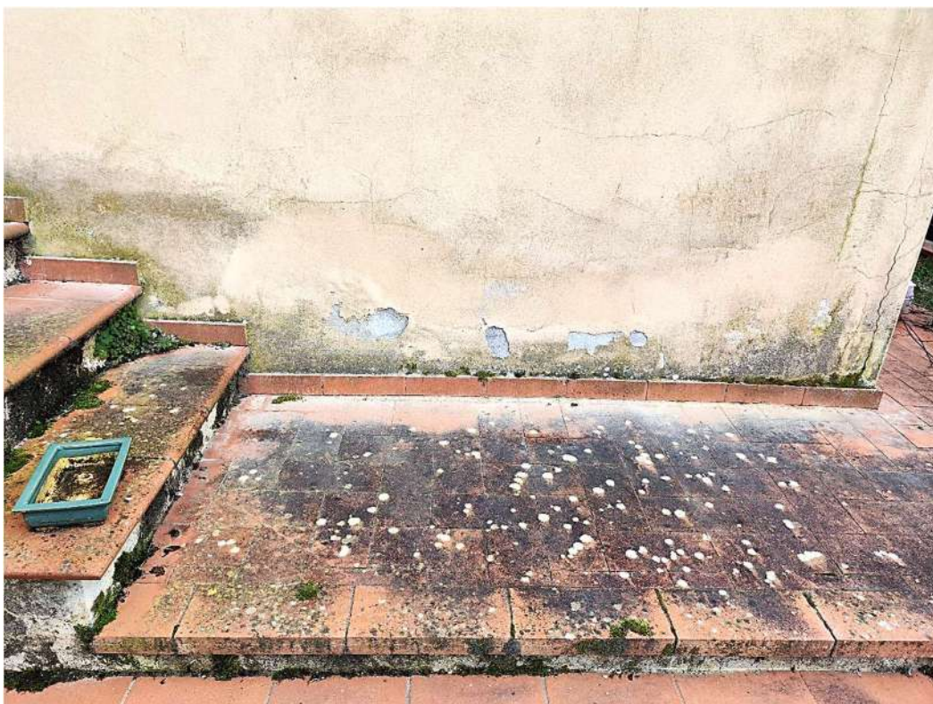
Foto 15 - Particolare murature di facciata (lato resede)
