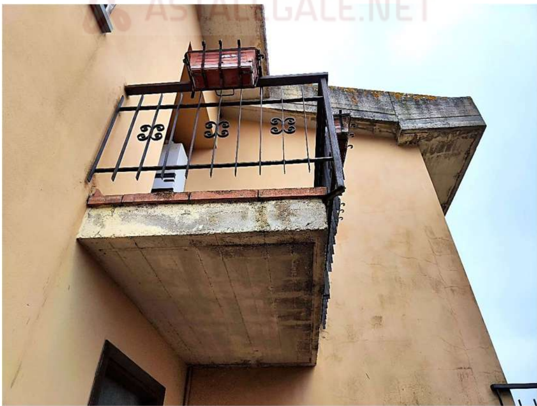
Foto 32 - Vista dal basso della terrazza e della loggia
