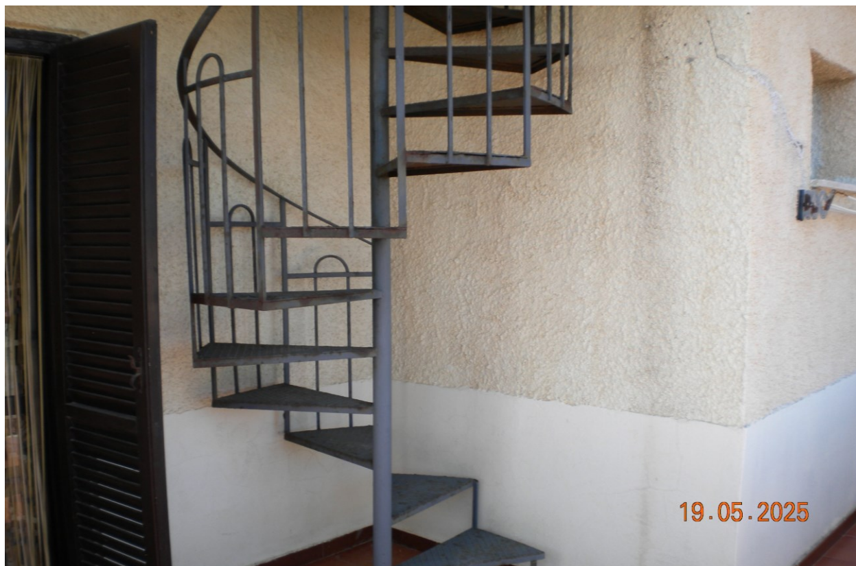
Particolare scala a chiocciola interna di accesso dal terrazzo del primo piano al secondo piano.
