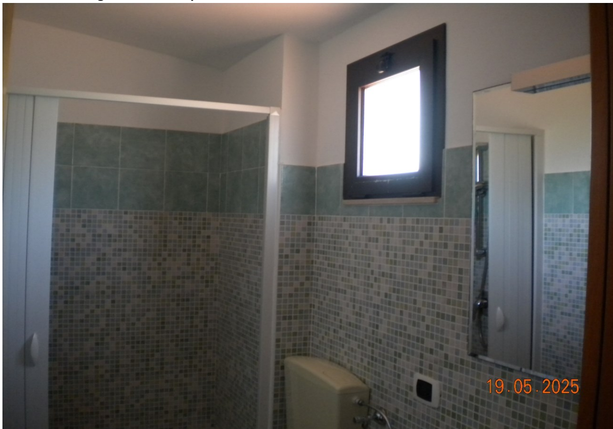
Vista interna bagno al secondo piano sottotetto
