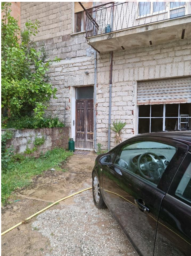
Porta di accesso al sub 2
